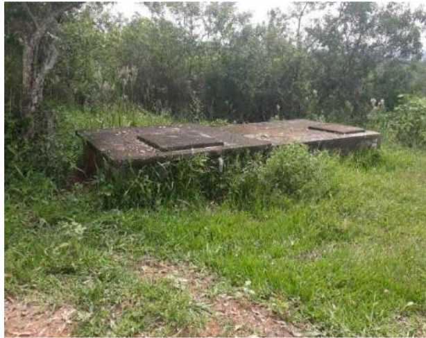
Reservatório de Água de Camargos
