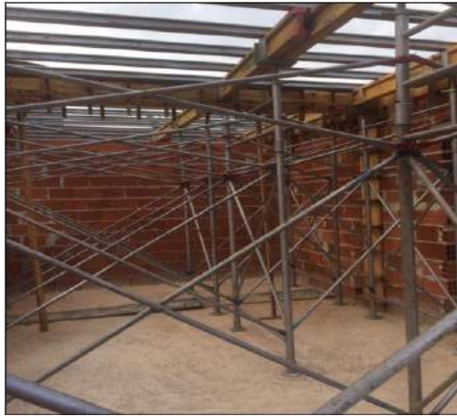
Cimbramento da laje da casa de química
