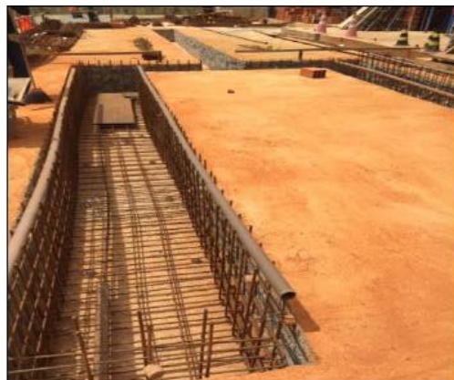
Posicionamento da ferragem das canaletas da nova ETA
