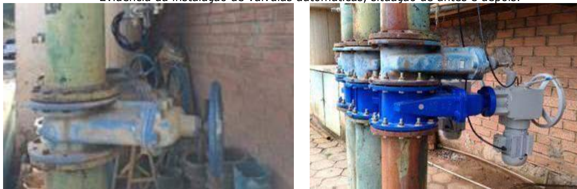
Evidência da instalação de válvulas automáticas, situação de antes e depois.
