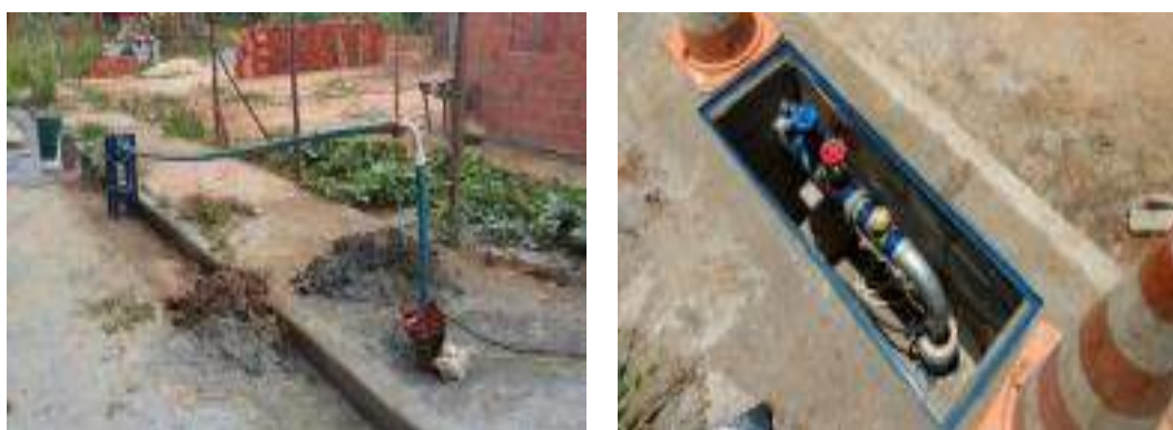
Imagens do poço perfurado em Itueta.
