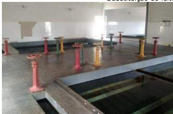
Substituição do leito filtrante dos filtros "Rápidos"
