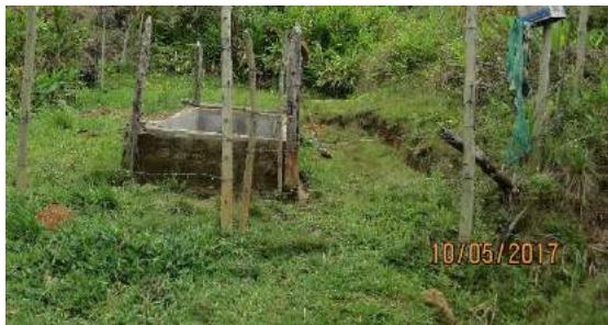
Caixa de areia utilizada após a captação por nascente (à esquerda) e Detalhes de adaptações no sistema de bóias da caixa de areia (à direita)
