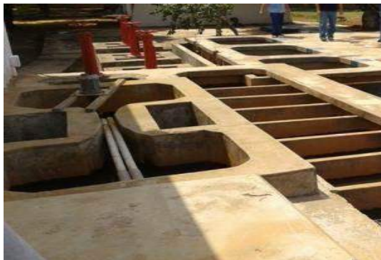
Reforma da calha Parshall , à esquerda, e guarda corpos à direita.
