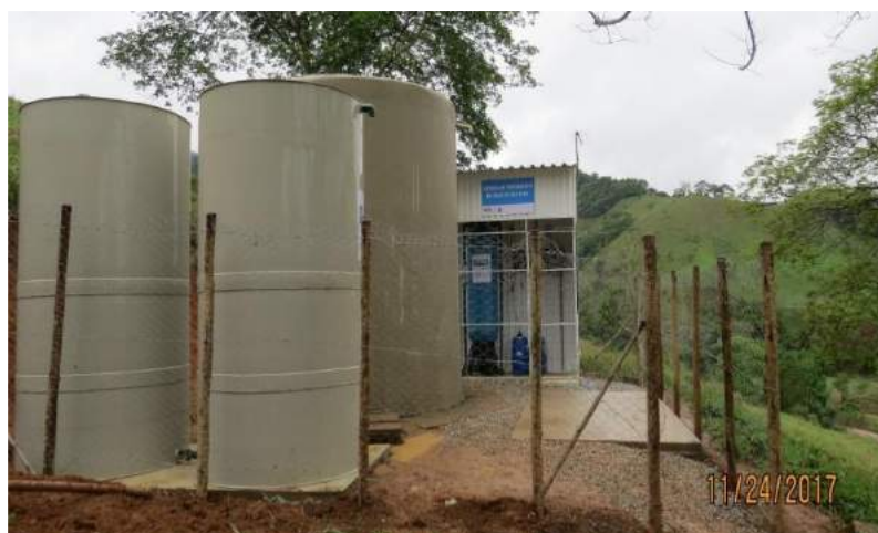
Vista do sistema de tratamento de água e reservação (dois novos reservatórios de 5 m 3 cada um) do Distrito de Gesteira
