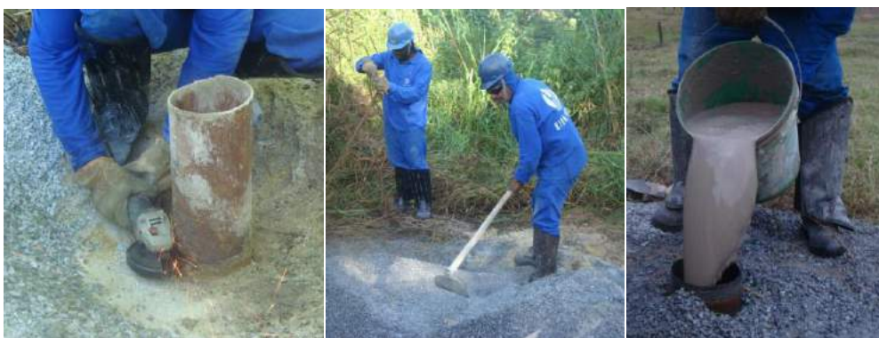
Tamponamento dos poços em Itueta.
