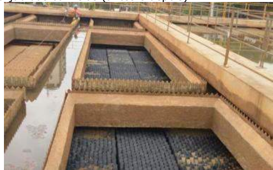
Mosaico de imagens ilustrando a substituição das colmeias (antes e depois).
