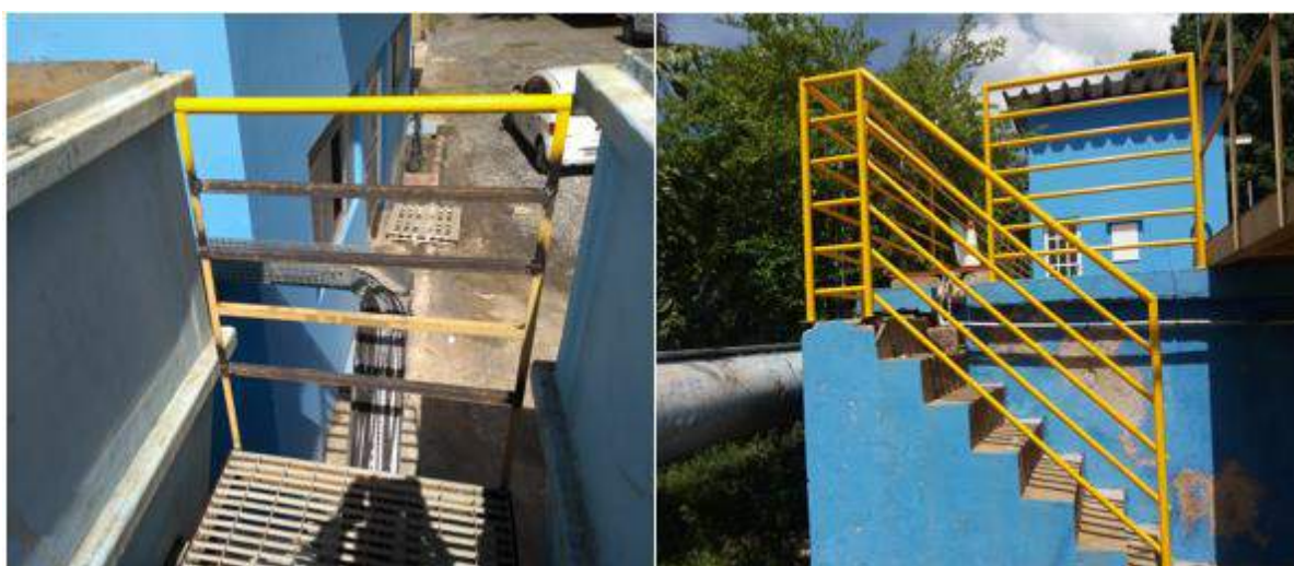
Instalação de guarda-corpo na ETA
