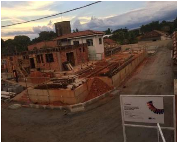
Vista geral da nova ETA
