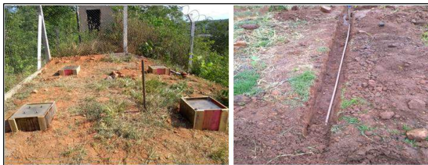
Construção das sapatas para instalação da caixa d'água e escavação e assentamento da tubulação.
