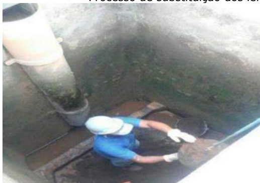
Processo de substituição dos leitos filtrantes de quatro filtros já existentes
