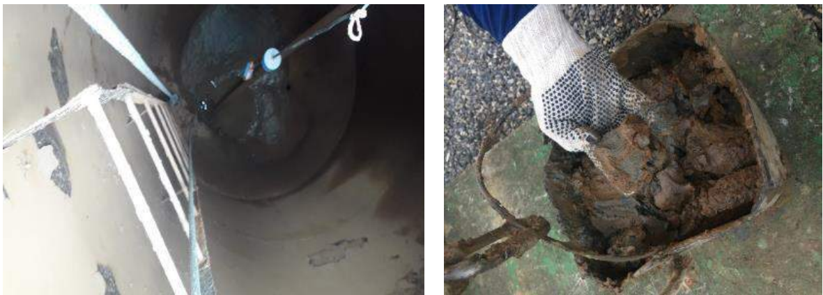
Interior da torre antes da reforma (à esquerda) e material lodoso retirado no interior do castelo d'água
