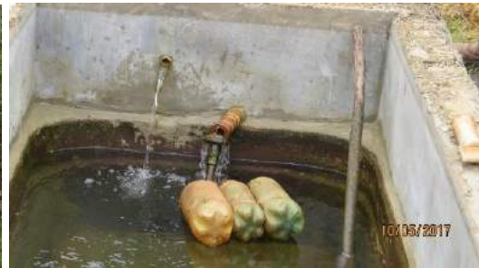
Caixa de areia utilizada após a captação por nascente (à esquerda) e Detalhes de adaptações no sistema de bóias da caixa de areia (à direita)
