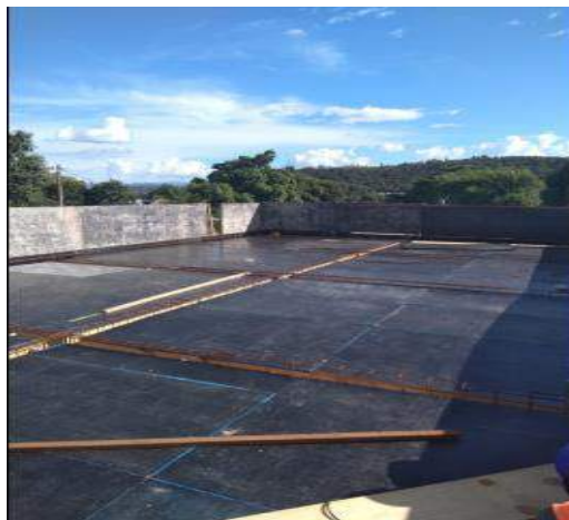
Forma da laje e viga da casa de química
