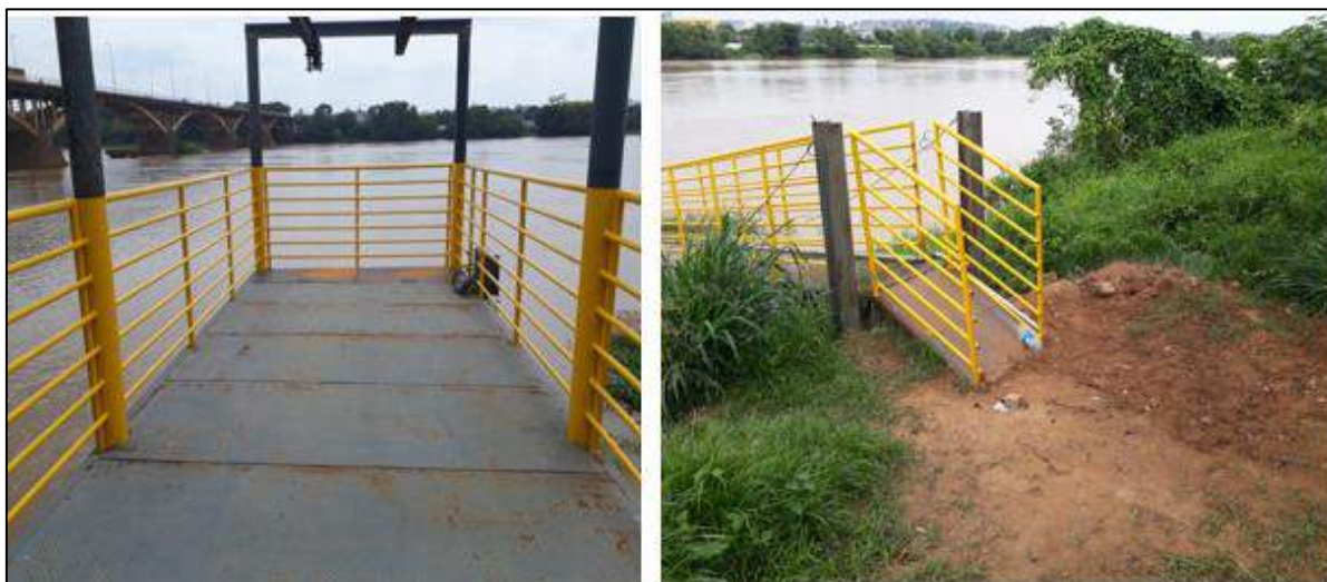
Instalação de guarda-corpo e grade de piso na área da captação de água bruta.
