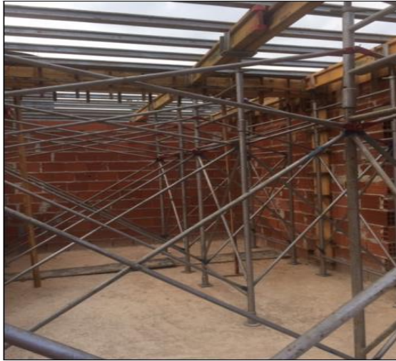
Cimbramento da laje da casa de química
