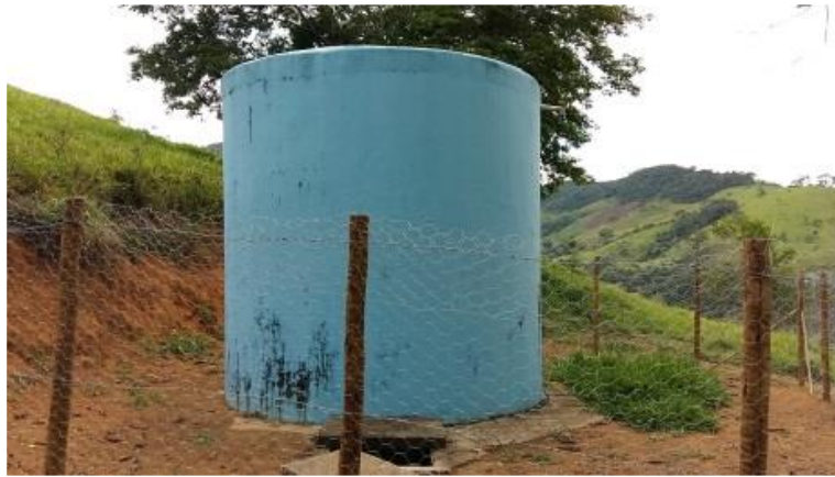
Perfuração de poço tubular em Gesteira, Barra Longa/MG (captação alternativa), posteriormente com seu entorno protegido
