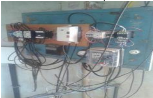
Substituição do Paine de Alimentação das Bombas da Captação
