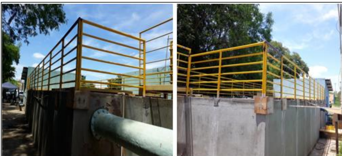
Instalação de guarda-corpo no perímetro do tanque de contato
