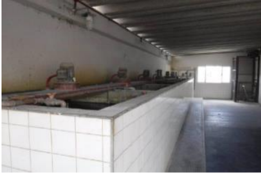
Melhoria dos tanques, que passaram por revestimento de fibra de vidro.
