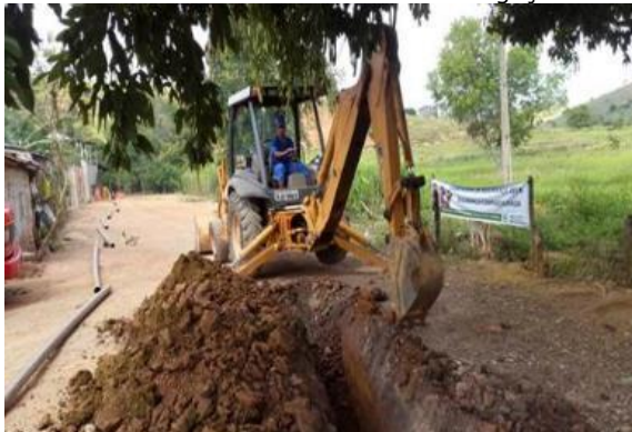
Evidências da interligação hidráulica do poço tubular PN01 à adutora.
