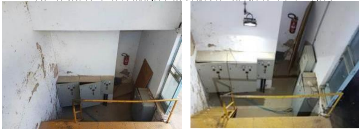
Imagem da Casa de Bomba de captação antes e depois da instalação de nova iluminação em LED.
