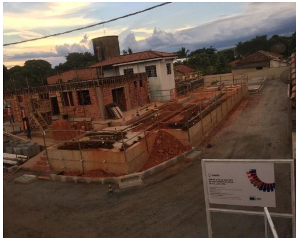
Vista geral da nova ETA
