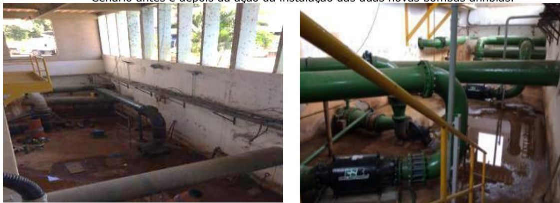
Cenário antes e depois da ação da instalação das duas novas bombas anfíbias.
