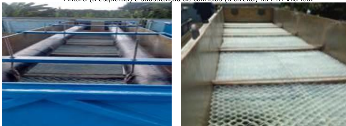
Pintura (à esquerda) e substituição de colmeias (à direita) na ETA Vila Isa.
