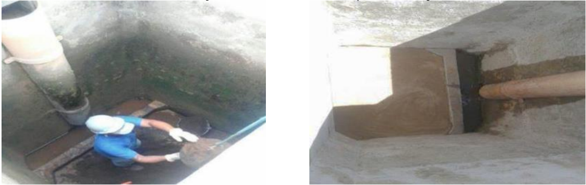
Processo de substituição dos leitos filtrantes de quatro filtros já existentes
