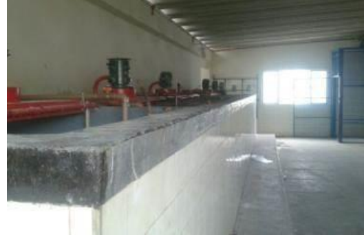
Melhoria dos tanques, que passaram por revestimento de fibra de vidro.
