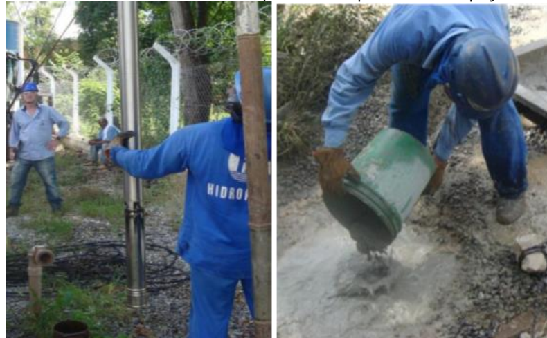
Içamento de bomba submersa na foto à esquerda e tamponamento de poço na foto à direita
