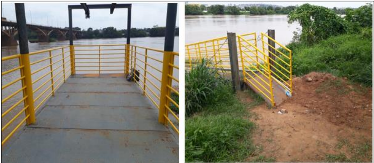
Instalação de guarda-corpo e grade de piso na área da captação de água bruta.
