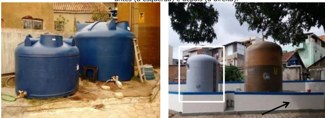
Construção de caixa de contenção para reagentes e tanque para Tanfloc, evidenciados à direita, cenários de antes (à esquerda) e depois (à direita).
