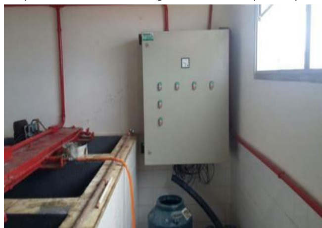
Montagem do painel de comando dos agitadores dos tanques de produto químico
