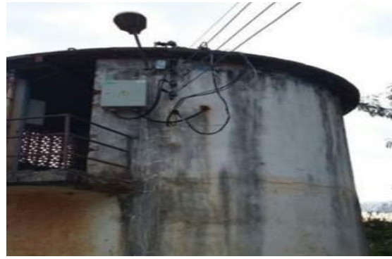
Substituição do Paine de Alimentação das Bombas da Captação
