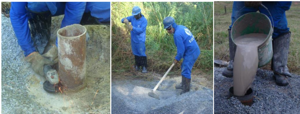
Tamponamento dos poços em Itueta.
