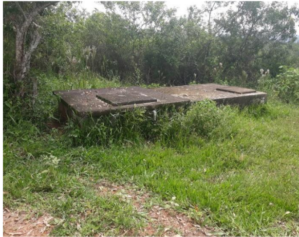
Reservatório de Água de Camargos
