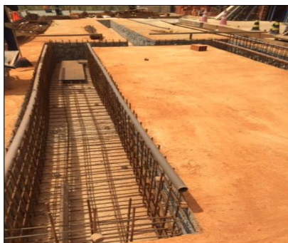
Posicionamento da ferragem das canaletas da nova ETA
