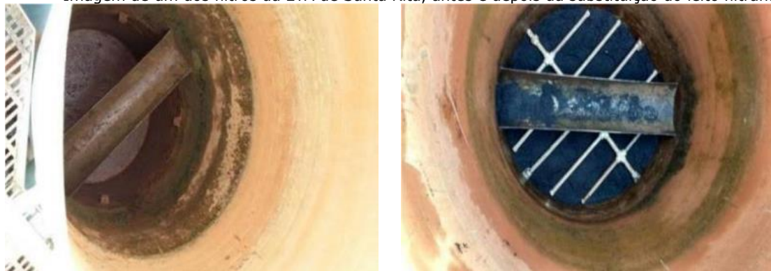
Imagem de um dos filtros da ETA de Santa Rita, antes e depois da substituição do leito filtrante.
