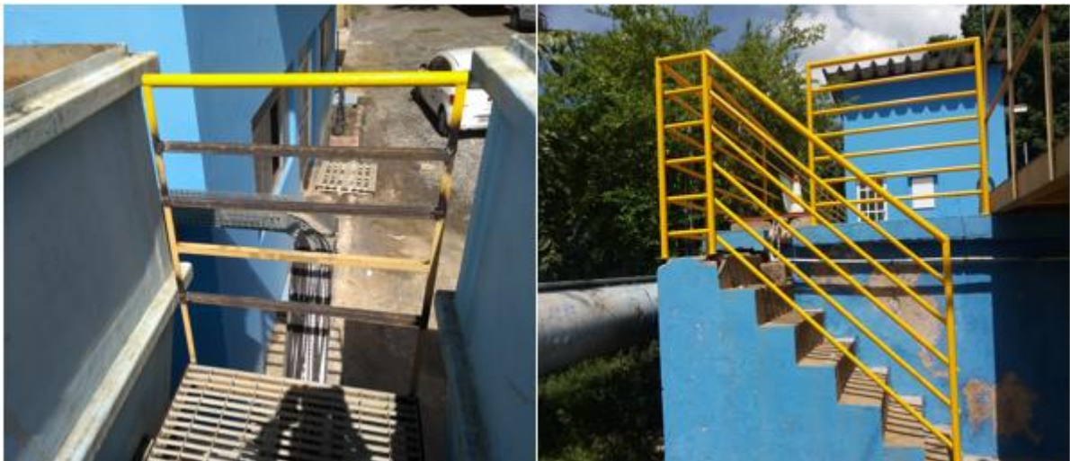
Instalação de guarda-corpo na ETA
