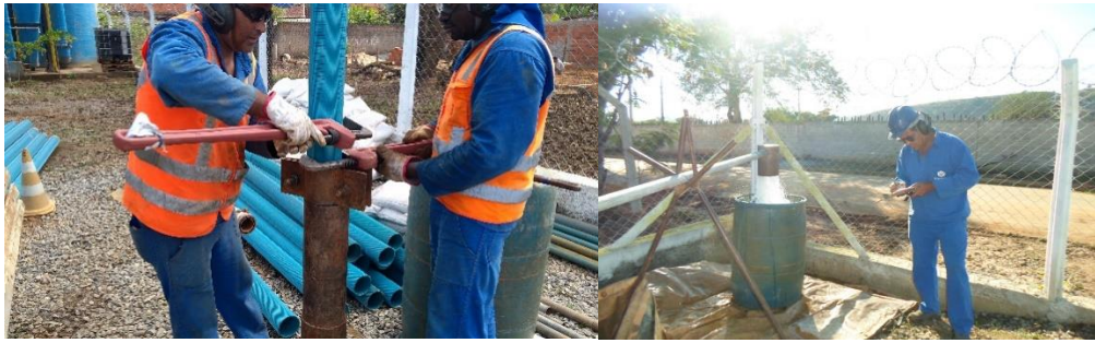
Fotos das fases de recuperação do poço tubular
