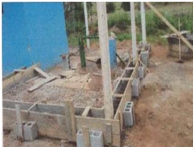
Construção do muro no entorno do reservatório em Gesteira
