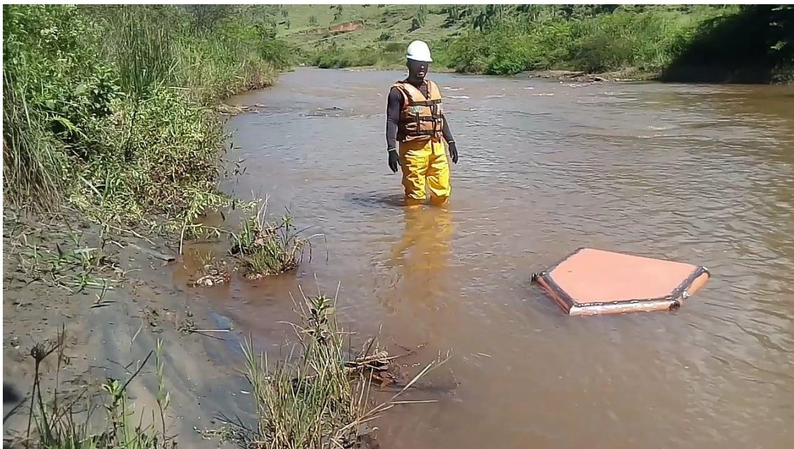
Foto 04: TESTE DE FLUTUAÇÃO EM CONDIÇÕES EQUIVALENTES AO QUE O EQUIPAMENTO SERÁ SUBMETIDO.
