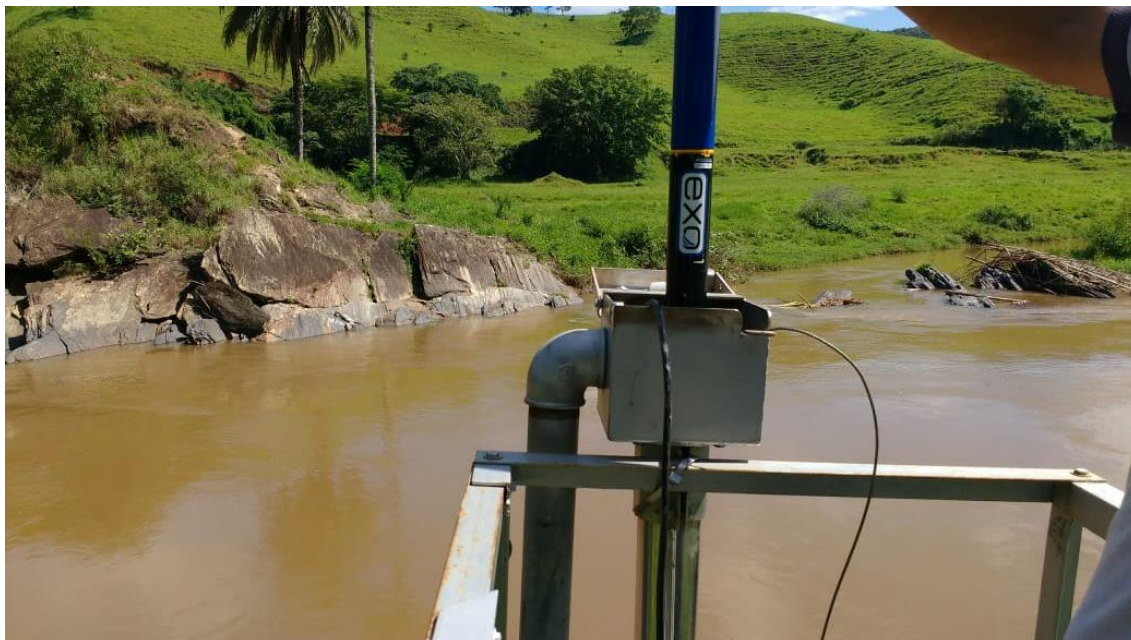
Foto 06: INSTALAÇÃO DA SONDA EXO 01 NA ESTAÇÃO RCA 01 – RIO DO CARMO.
