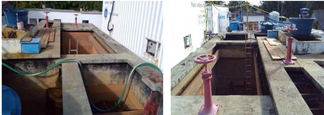
Instalação de caixas d'água na ETA de Regência.
