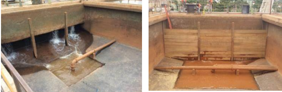
Cenário de antes e depois da instalação de cortina de madeira na entrada do Decantador 02
