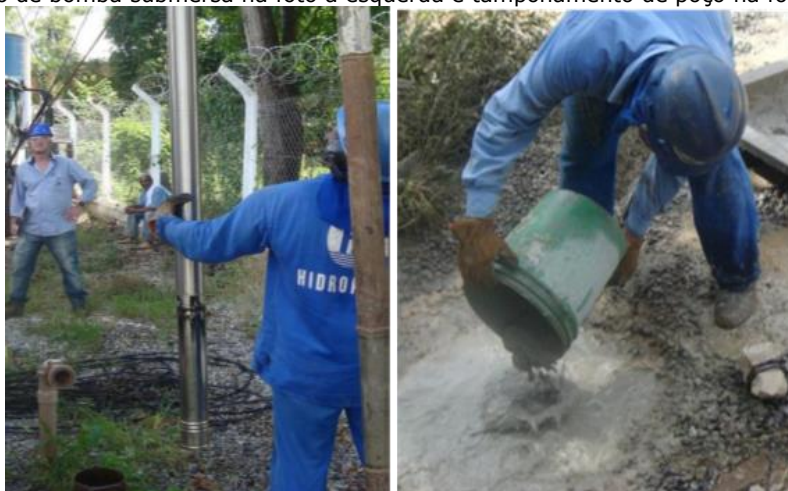
Içamento de bomba submersa na foto à esquerda e tamponamento de poço na foto à direita
