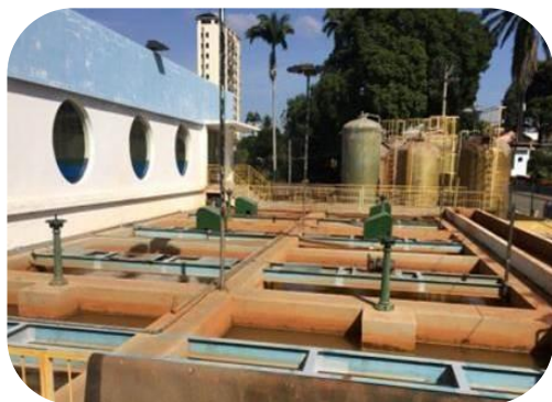
Figura 11: Imagens dos agitadores instalados na ETA Central.
