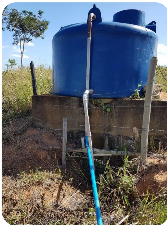
Figura 101: Reservatório instalado em substituição à cisterna com nova tubulação.
