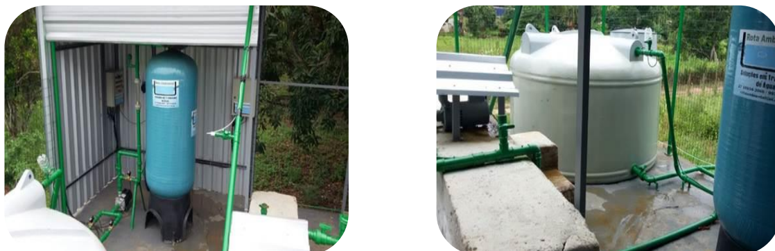
Figura 31: Imagem do filtro (à esquerda) e do reservatório (à direita) do sistema de tratamento da água do poço do distrito de São Tomé do Rio Doce.
