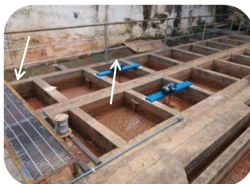
Figura 47: Implantação de acesso seguro às áreas dos floculadores e decantadores, evidenciado.
