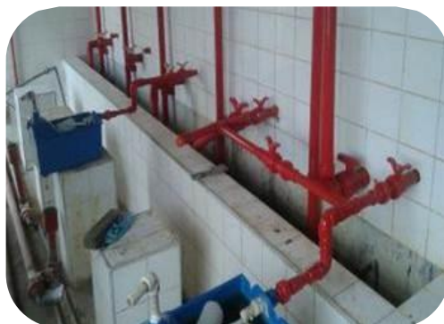
Figura 59: Reforma das caixas dosadoras dos produtos químicos.
