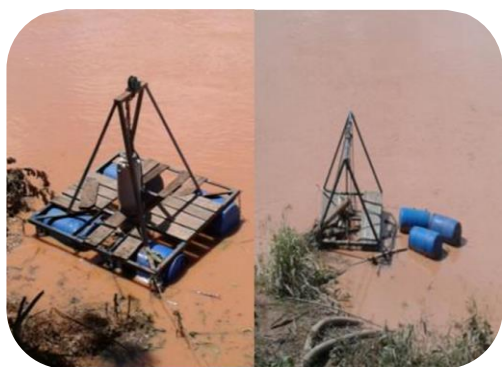
Figura 41: Substituição de balsa do sistema de captação da ETA I de Colatina.
