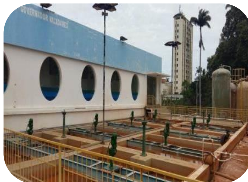
Figura 11: Imagens dos agitadores instalados na ETA Central.
