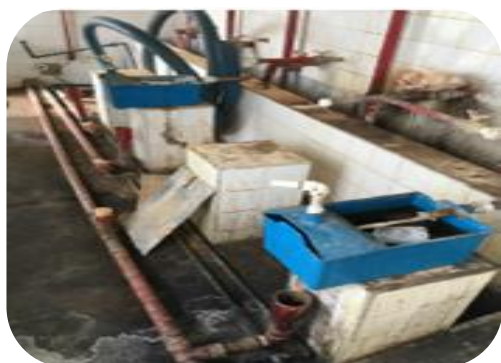
Figura 59: Reforma das caixas dosadoras dos produtos químicos.
