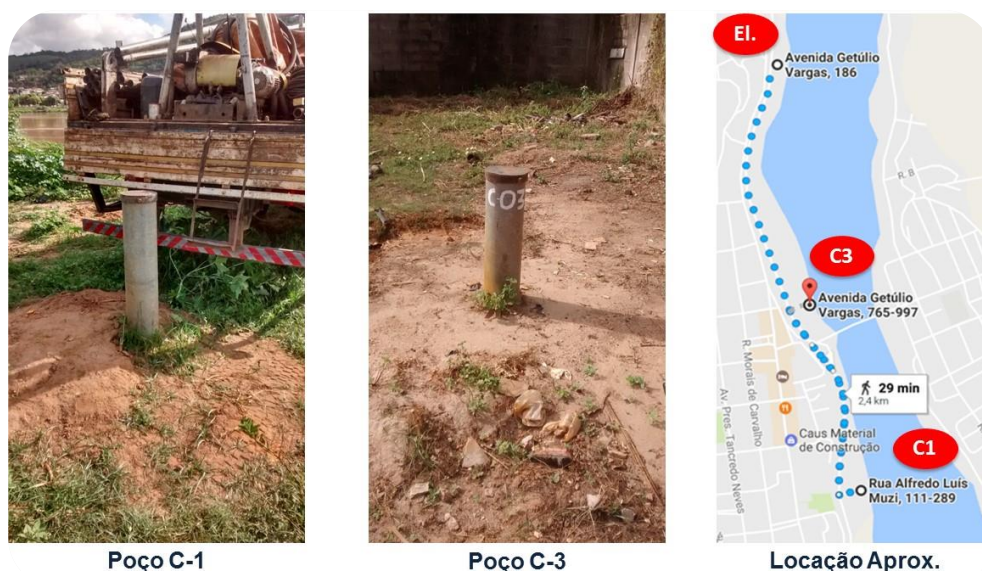
Figura 92: Imagens dos poços PC 1 com vazão de 18,5 L/s (a esquerda) e PC3 com vazão de 6,8 L/s (central) e, mapa com espacialização dos poços.
