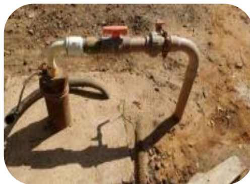
Figura 71: Poço já perfurado em Belo Oriente, interligado à Estação de Tratamento de Água de Cachoeira Escura.
