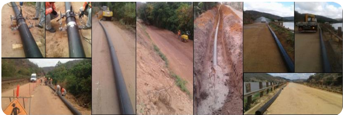
Figura 87: Detalhamento das obras da adutora do córrego Barroso.
