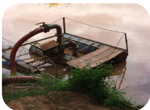
Figura 28: Imagem do sistema de captação da ETA Santa Rita, antes e depois da substituição dos flutuantes.
