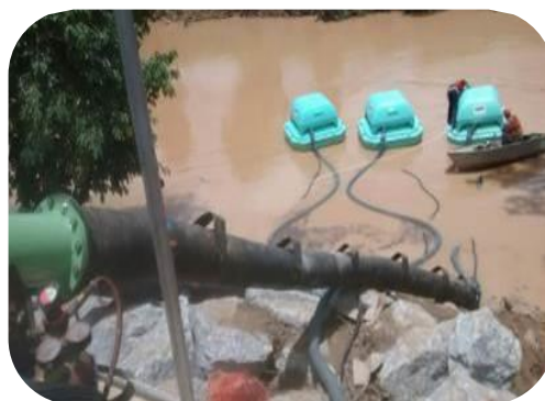
Figura 99: Imagens do sistema de operação da adutora no Rio Pancas.
