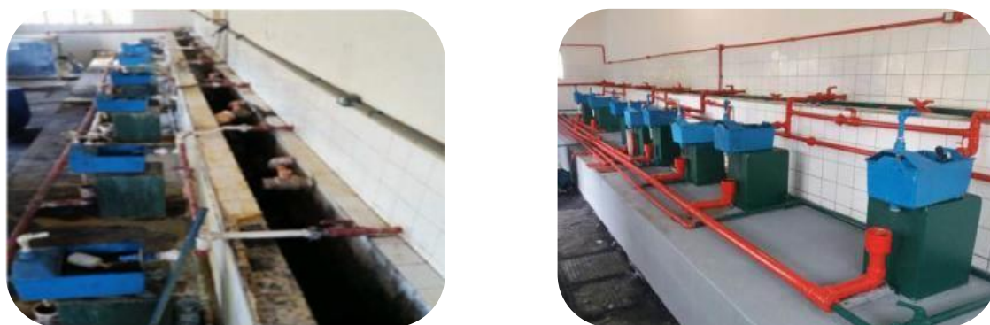
Figura 44: Instalação de caixas dosadoras de produtos químicos na ETA I de Colatina.
