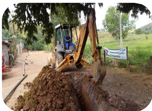
Figura 75: Evidências da interligação hidráulica do poço artesiano PN01 à adutora.
