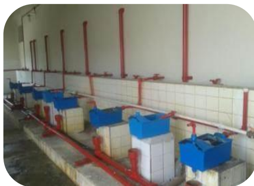
Figura 53: Melhorias nas caixas dosadoras.
