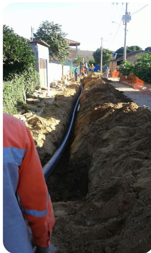
Figura 36. Imagens da construção da adutora de água tratada, que interligará a nova ETA de Galileia ao reservatório do SAAE.
