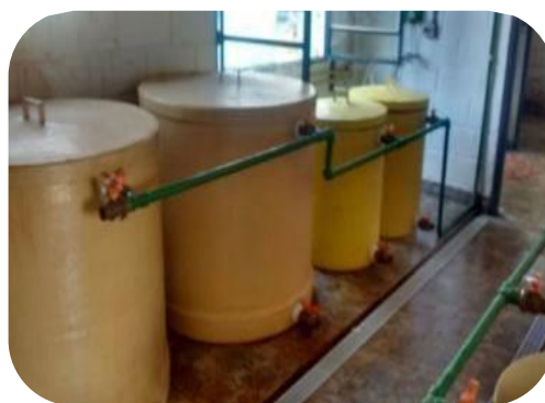
Figura 7: Melhoria das condições de armazenamento dos produtos químicos na Casa de Química da ETA de Cachoeira Escura (antes e depois).
