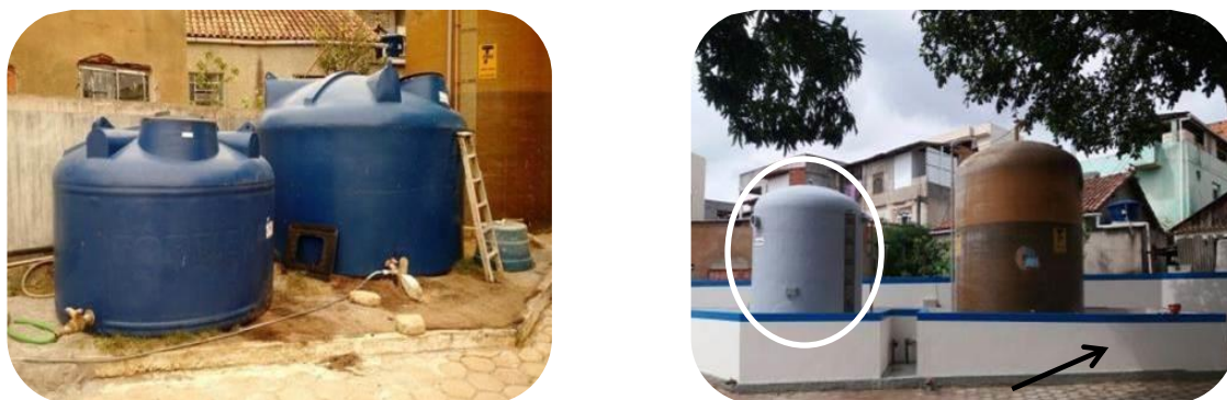
Figura 51: Construção de caixa de contenção para reagentes e tanque para Tanfloc, evidenciados à direita, cenários de antes (à esquerda) e depois (à direita).
