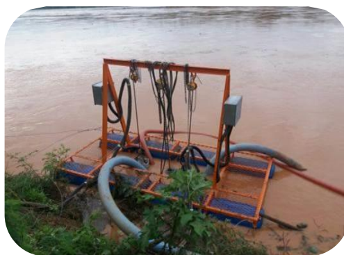
Figura 41: Substituição de balsa do sistema de captação da ETA I de Colatina.
