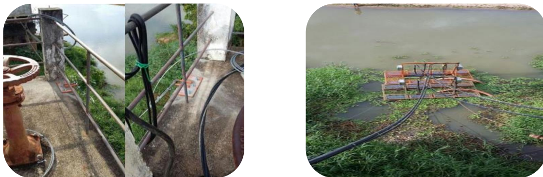
Figura 50: Novo sistema de ancoragem e alimentação elétrica da Balsa de captação da ETA II.
