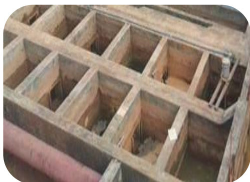
Figura 47: Implantação de acesso seguro às áreas dos floculadores e decantadores, evidenciado.
