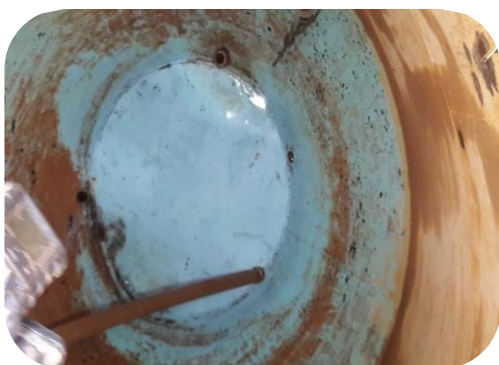
Figura 34: Jateamento do interior da torre durante a reforma (à esquerda) e resultado da pintura no mesmo interior (à direita)
