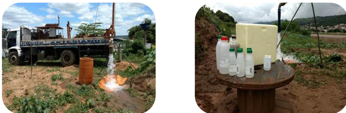
Figura 91: Imagens de recuperação do Poço C1, em Resplendor.
