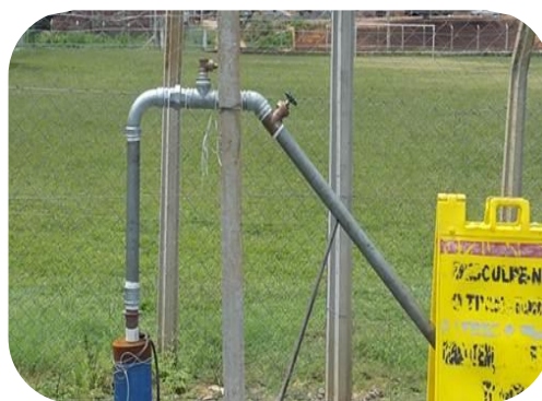
Figura 75: Evidências da interligação hidráulica do poço artesiano PN01 à adutora.
