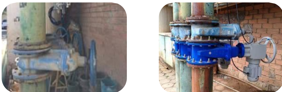
Figura 16: Evidência da instalação de válvulas automáticas, situação de antes e depois.
