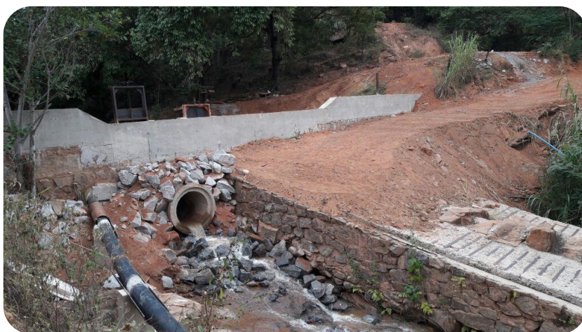
Figura 89: Barragem no córrego Barroso, após obras de reforço da barragem.
