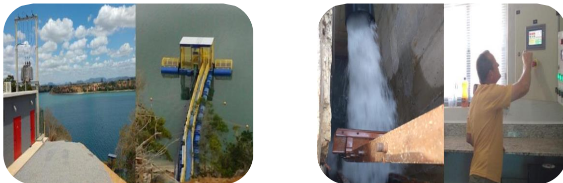
Figura 103: Sistema de Bombeamento e Subestação (esquerda) e Chegada de água no SAAE e painel de operação Remota da adutora de Lagoa Nova (direita).
