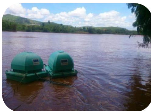
Figura 28: Imagem do sistema de captação da ETA Santa Rita, antes e depois da substituição dos flutuantes.
