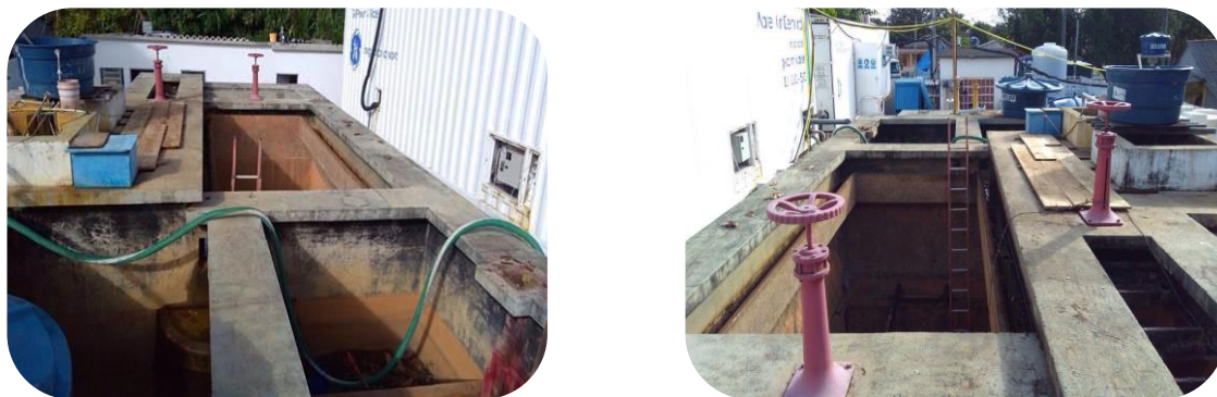
Figura 65: Instalação de caixas d'água na ETA de Regência.
