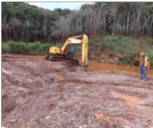
1 - Preparação da área afetada.
