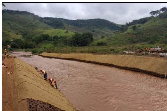
3 – Conformação de taludes das margens
