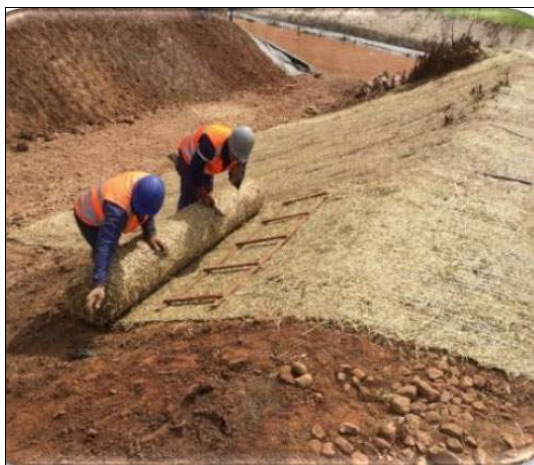
3 - Colocação de revestimento para estabilizar a calha do tributário (biomantas, enrocamentos).
