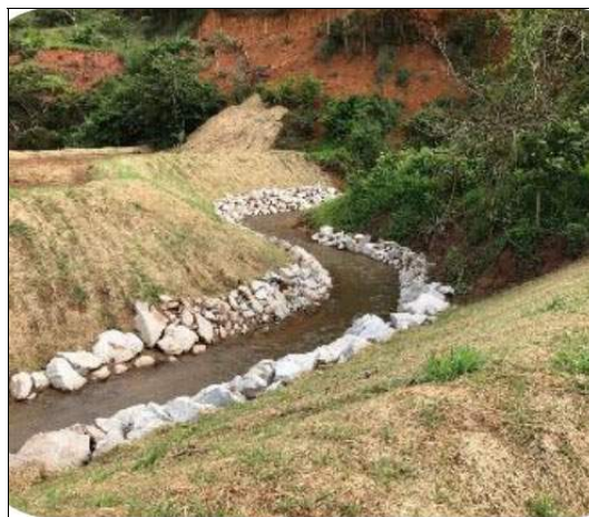
3 - Colocação de revestimento para estabilizar a calha do tributário (biomantas, enrocamentos).
