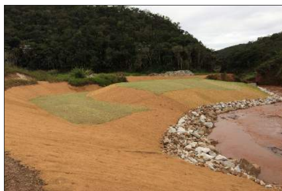
5 – Revegetação (Coveamento, semeio manual e aplicação de biomantas)
