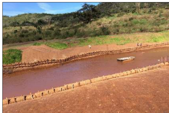
4 - Aplicação de revestimentos nas margens
