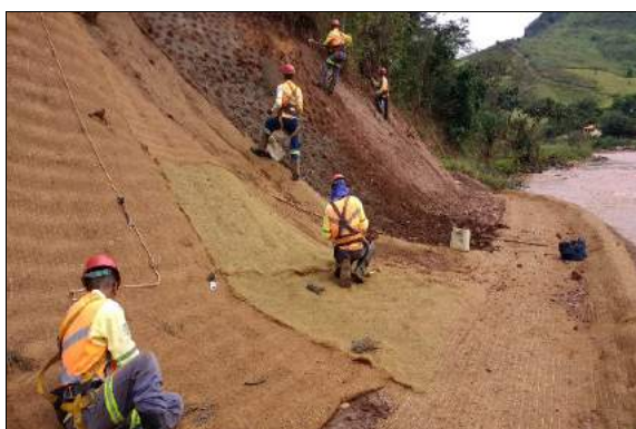
5 – Revegetação (Coveamento, semeio manual e aplicação de biomantas)
