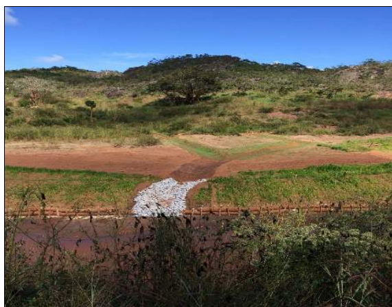
2 – Direcionamento das drenagens do escoamento superficial e instalação de medidas de controle de erosão (descidas d'água com enrocamento, retentores de sedimentos)
