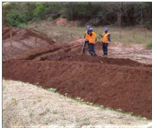
2 - Limpeza e conformação da calha.
