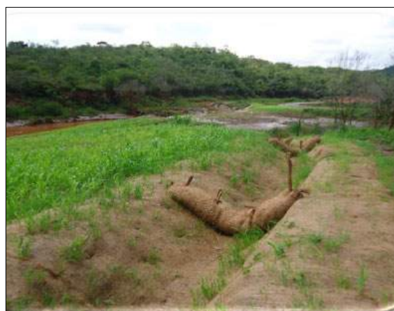
2 – Direcionamento das drenagens do escoamento superficial e instalação de medidas de controle de erosão (descidas d'água com enrocamento, retentores de sedimentos)
