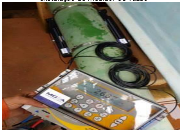
Instalação de medidor de vazão
