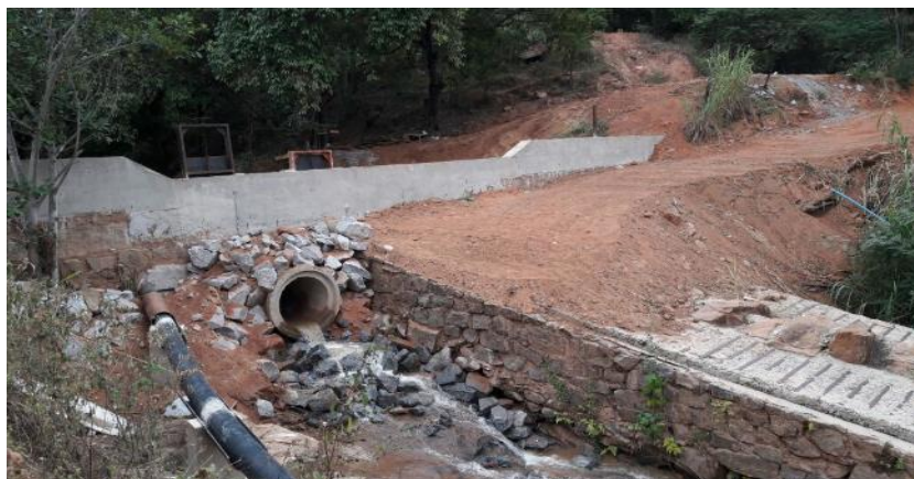
Barragem no córrego Barroso, após obras de reforço da estrutura.
