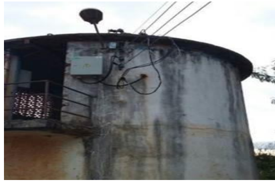
Substituição do Painel de Alimentação das Bombas da Captação
