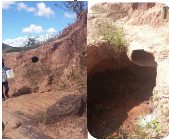
Adutora do Córrego Santaninha da COPASA.
