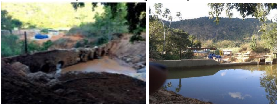
Avanço das obras da barragem no córrego Barroso.
