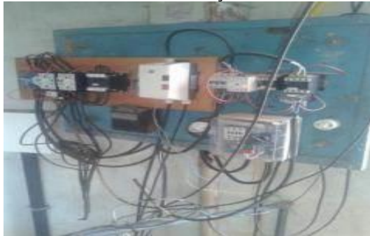
Substituição do Painel de Alimentação das Bombas da Captação
