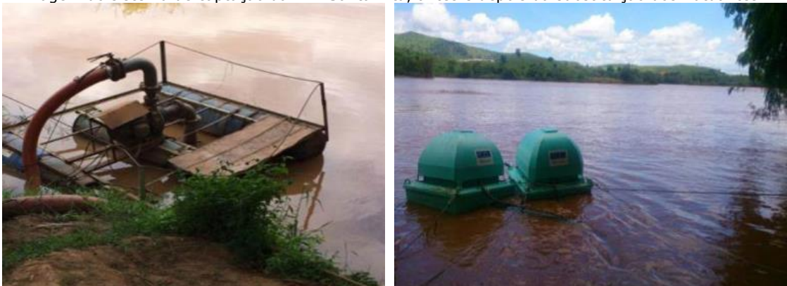
Imagem do sistema de captação da ETA Santa Rita, antes e depois da substituição dos flutuantes.
