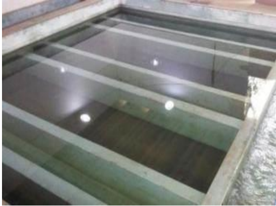
Substituição do leito filtrante dos filtros "Russos" na ETA II de Colatina
