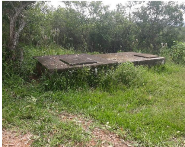
Reservatório de Água de Camargos
