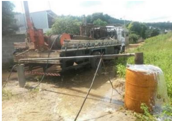
- Imagens de recuperação do Poço C1, em Resplendor.
