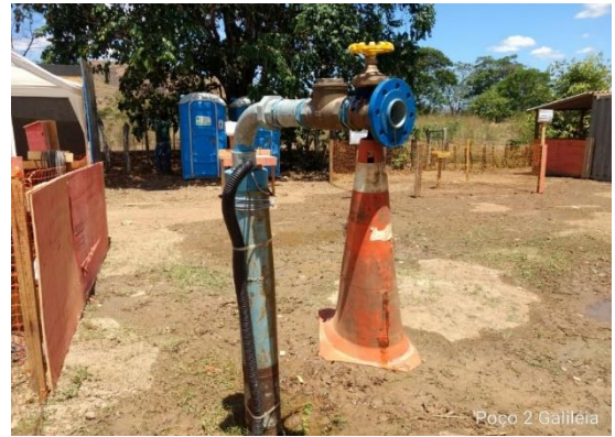
Poço 02 após limpeza, desinfecção e teste de bombeamento
