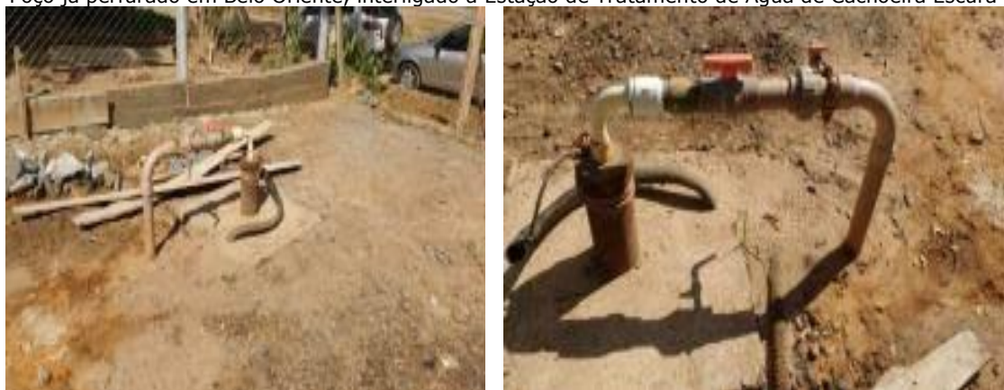
Poço já perfurado em Belo Oriente, interligado à Estação de Tratamento de Água de Cachoeira Escura
