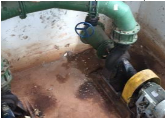
Cenário antes e depois da instalação de válvula de retenção na bomba de captação.
