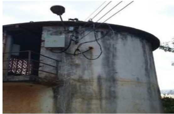
Substituição do Pannel de Alimentação das Bombas da Captação
