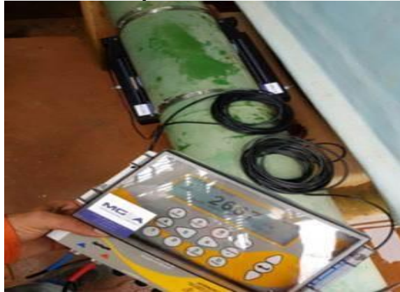
Instalação de medidor de vazão
