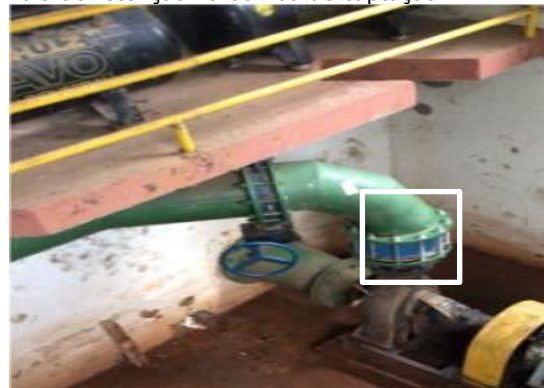
Cenário antes e depois da instalação de válvula de retenção na bomba de captação.
