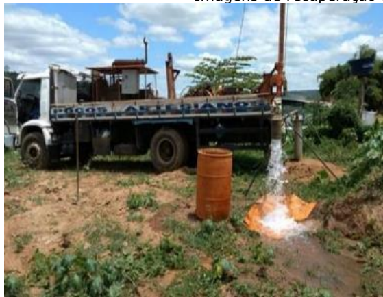
- Imagens de recuperação do Poço C1, em Resplendor.
