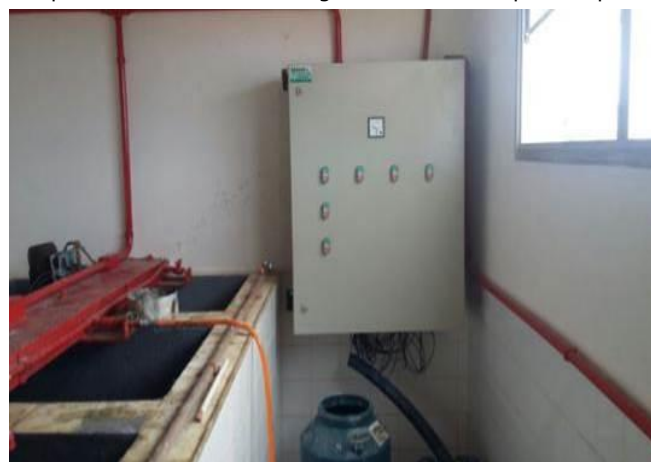
Montagem do pannel de comando dos agitadores dos tanques de produto químico
