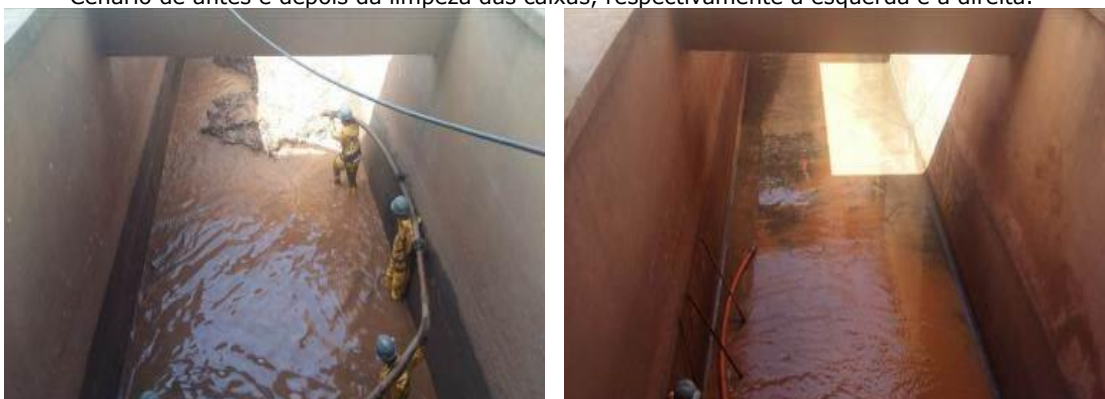
Cenário de antes e depois da limpeza das caixas, respectivamente à esquerda e à direita.
