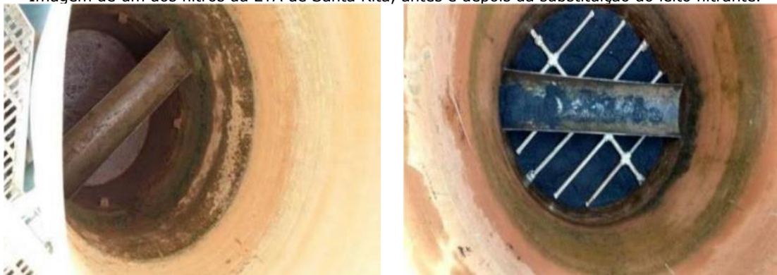
Imagem de um dos filtros da ETA de Santa Rita, antes e depois da substituição do leito filtrante.
