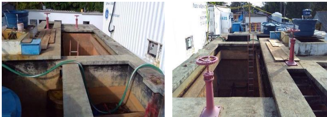
Instalação de caixas d'água na ETA de Regência.
