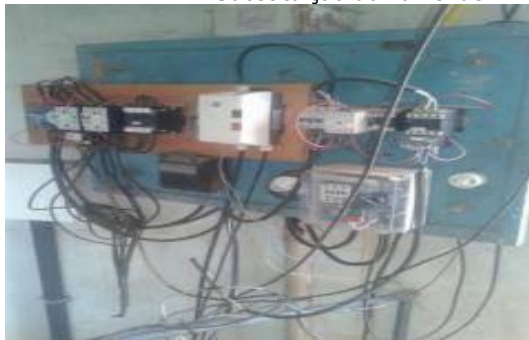
Substituição do Pannel de Alimentação das Bombas da Captação
