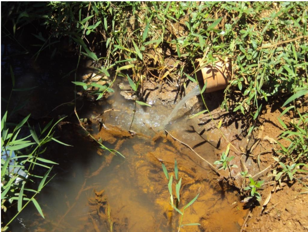
Figura 6 - Lançamento de esgoto in natura no córrego do Perdido na Rua Sercundino Cipriano – Distrito de Alto Capim – Aimorés.
