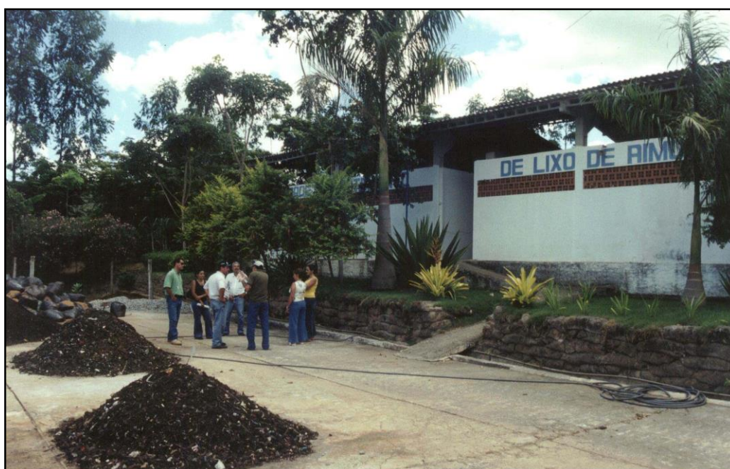
Figura 14 - Vista parcial da UTC-Aimorés e pátio de compostagem.
