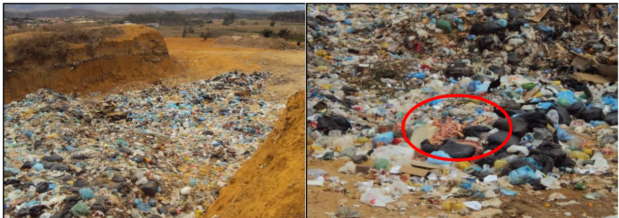
Figura 7 - Aspecto visual da vala do aterro controlado onde se pode observar RSU descobertos e carcaça de animais exposta, sendo um atrativo para vetores.
