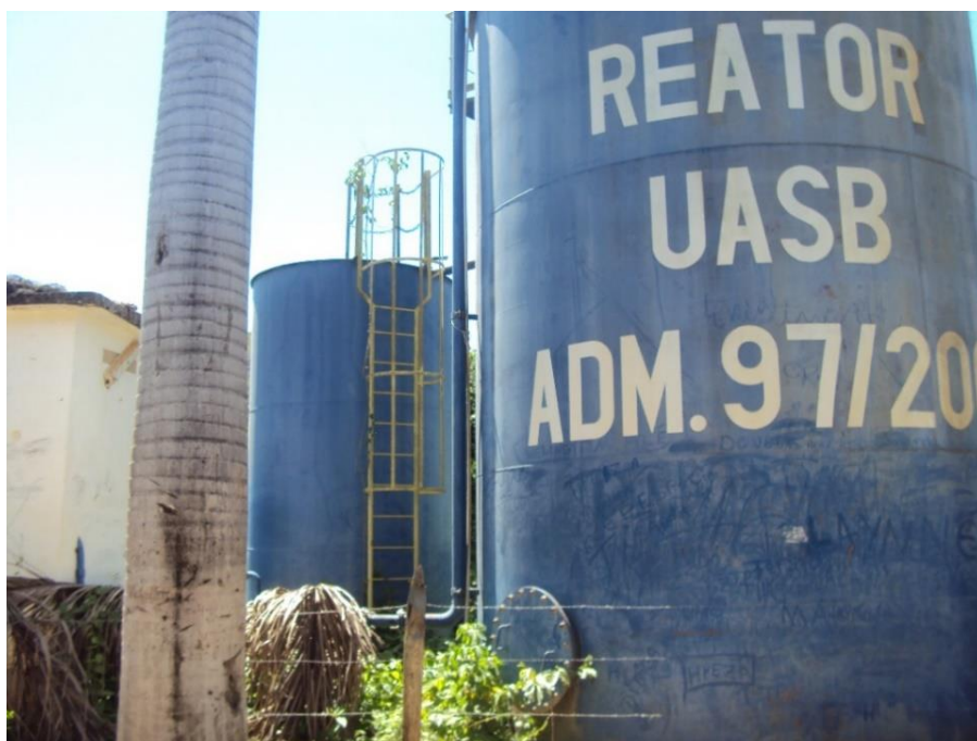
Figura 44 - Vista de parte da estrutura da antiga ETE, atualmente desativada. (Local: 24K 0261002 7813979 / Altitude: 220 m).
