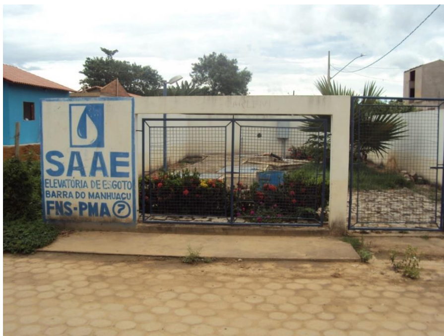
Figura 14 - Estação Elevatório de Esgoto da Barra do Manhuaçu 2 (Local: 24K 0280809 7843726 / Altitude: 86 m).
