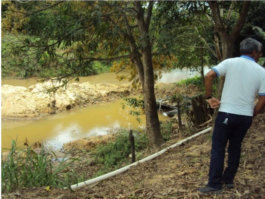
Figura 12 - Aspecto visual da captação de água bruta localizado no rio Capim (Local: 24K 0263730 7823202 / Altitude: 202 m).
