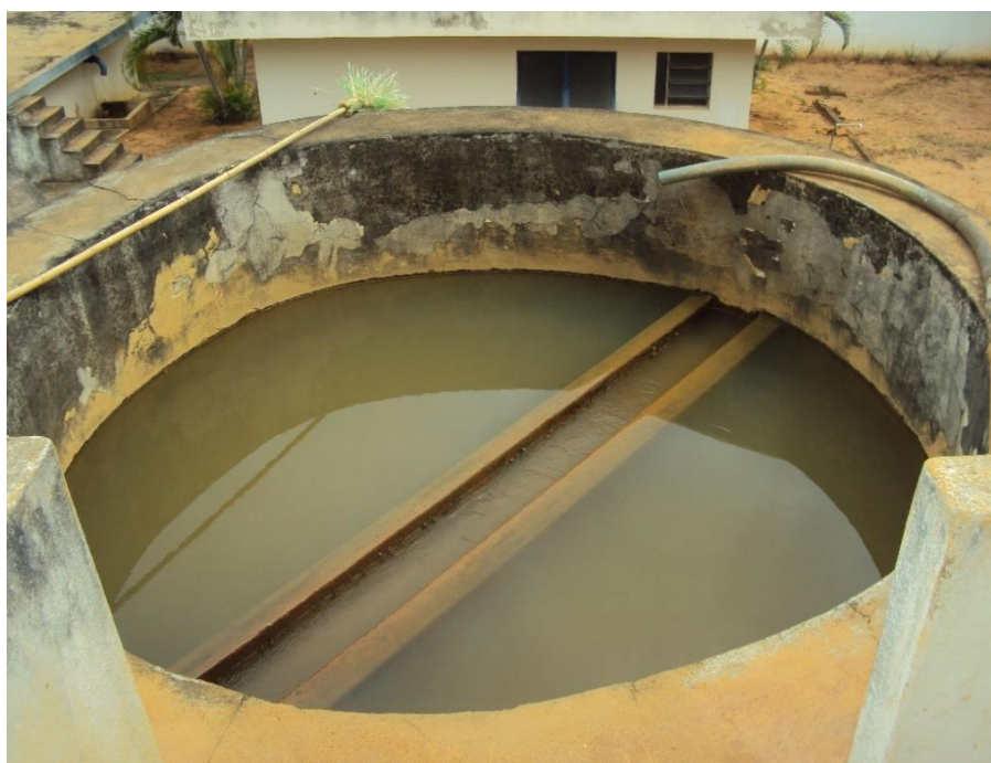
Figura 6 - Floculador (Local: 24K 0281372 7843151 /Altitude: 177 m).
