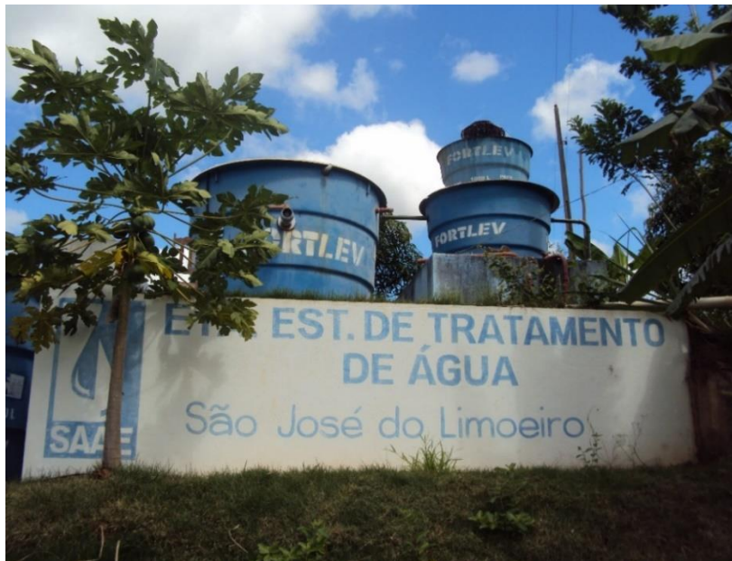
Figura 61 - Estação de Tratamento de Água (Local: 24K 0250785 7834456/ Altitude: 218 m).
