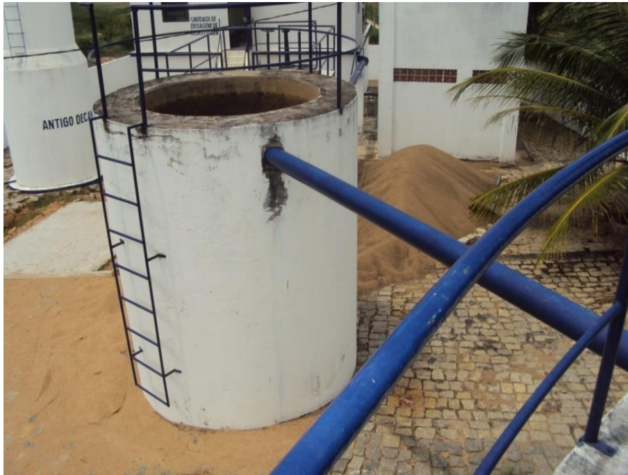
Figura 31 - Unidade de Dosagem de Cloro e Flúor (Local: 24K 0260829 7814145 / Altitude: 252 m).
