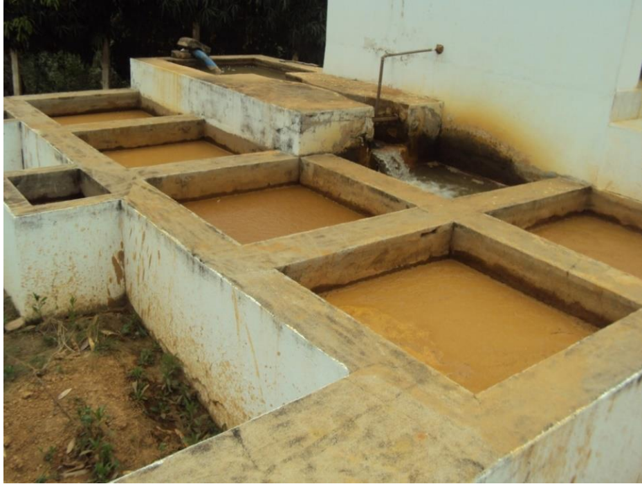
Figura 19 - Decantador (Local: 24K 0263973 7823449 / Altitude: 222 m).
