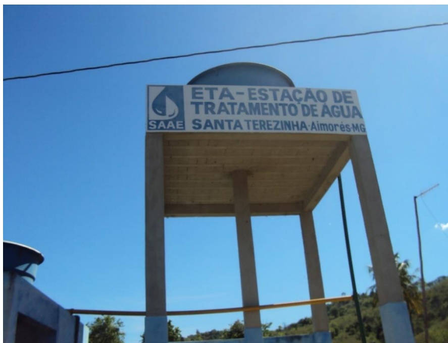
Figura 65 - ETA e Reservatório (Local: 24K 0251188 7819836/ Altitude:234 m).
