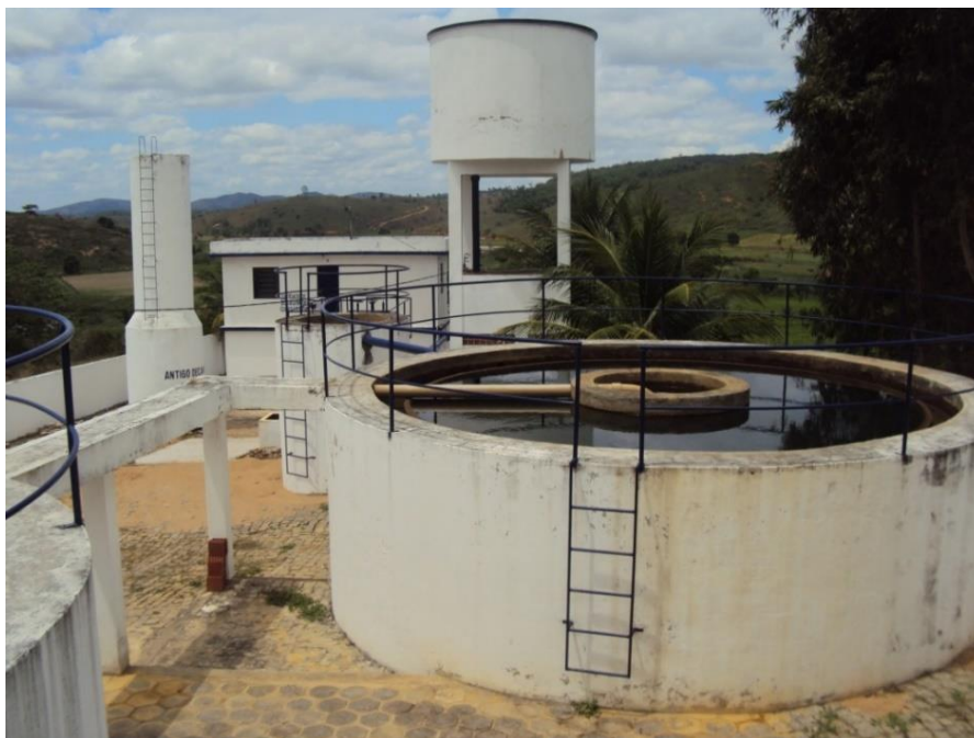
Figura 29 - Unidade de Filtro Descendente (Local: 24K 0260829 7814145 / Altitude: 252 m).
