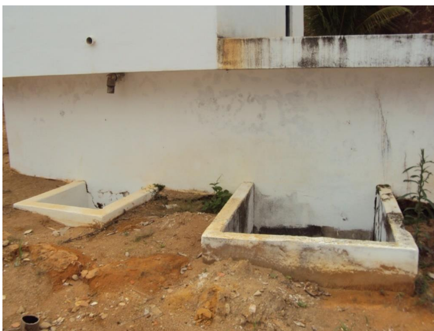
Figura 23 - Reservatório (Local: 24K 0263973 7823449 / Altitude: 222 m).
