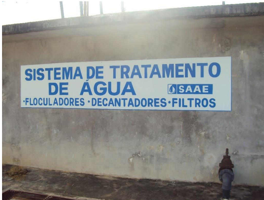
Figura 40 - Estação de Tratamento de Água de Santo Antônio do Rio Doce (Local: 24 K 0288435 7842556/ Altitude: 110 m).
