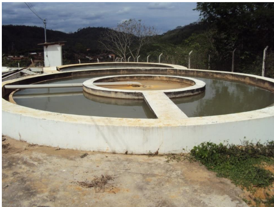
Figura 37 - Unidade de Filtragem Lenta (Local: 24K 0257631 7841957 / Altitude: 179 m).
