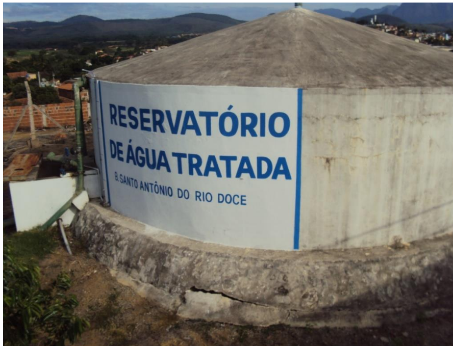
Figura 47 - Reservatório (Local: 24K 0288435 7842556/ Altitude: 110 m).
