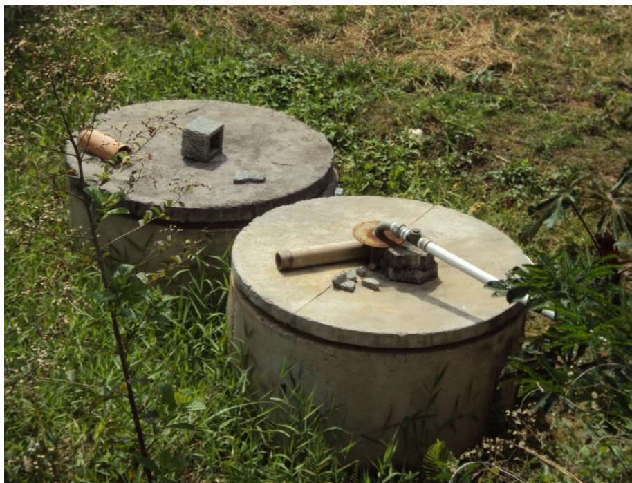
Figura 60 - Aspecto visual da estrutura de proteção da captação de água bruta em poço raso (Local: 24K 0250785 7834484 / Altitude: 192 m).
