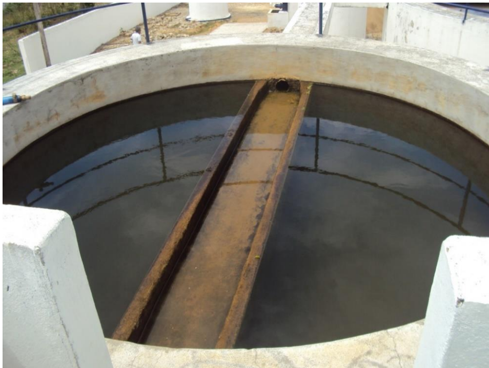
Figura 27 - Floculador (Local: 24K 0260829 7814145 / Altitude: 252 m).
