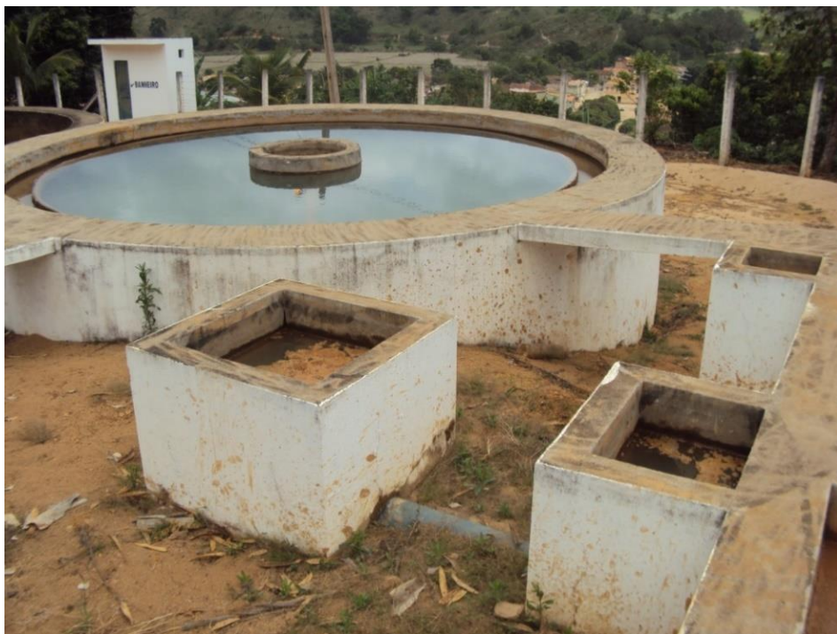
Figura 19 - Decantador (Local: 24K 0263973 7823449 / Altitude: 222 m).
