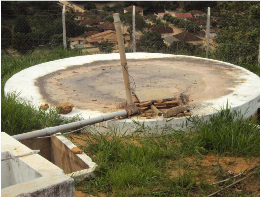
Figura 39 - Reservatório (Local: 24K 0257631 7841957 / Altitude: 179 m).
