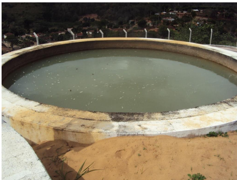
Figura 37 - Unidade de Filtragem Lenta (Local: 24K 0257631 7841957 / Altitude: 179 m).
