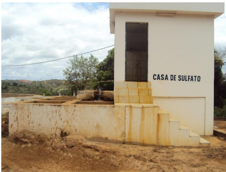
Figura 16 - Casa de Química (Local: 24K 0263973 7823449 / Altitude: 222 m)
