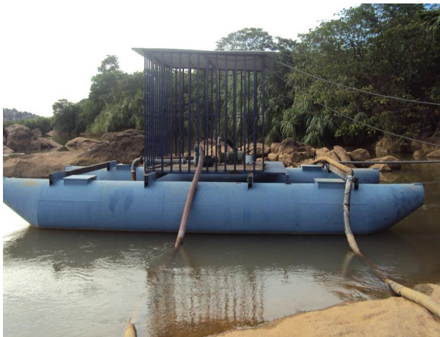
Figura 41 - Aspecto visual da captação de água bruta localizada no rio Doce (Local: 24K 0288330 7842085 / Altitude: 110 m).
