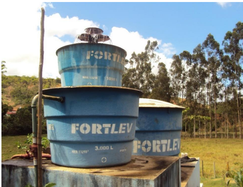
Figura 62 - Reservatório (Local: 24K 0250785 7834456/ Altitude: 218 m).
