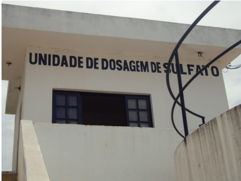
Figura 26 - Casa de Química (Local: 24K 0260829 7814145 / Altitude: 252 m).
