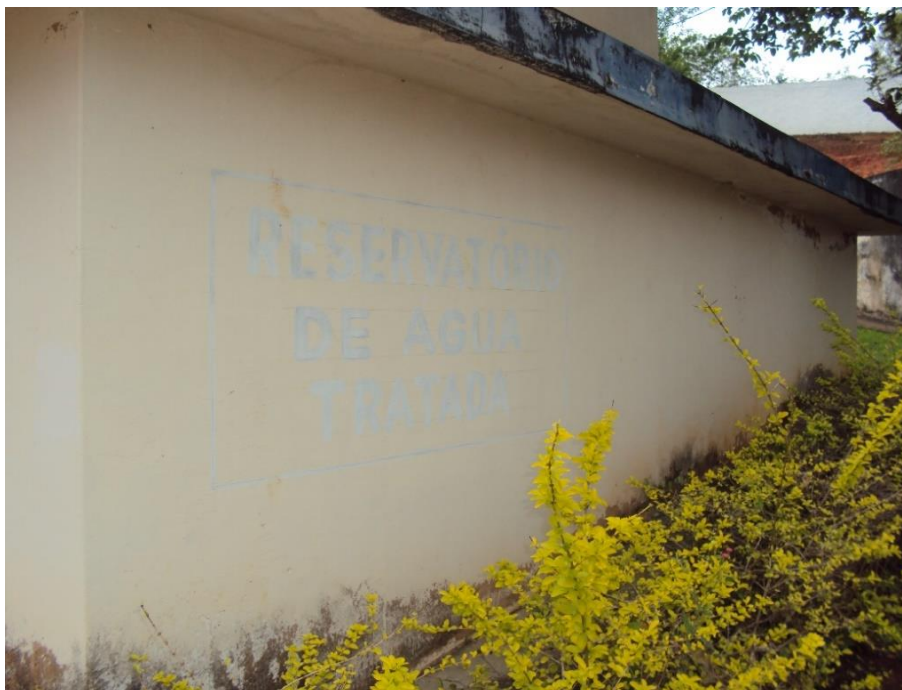
Figura 11 - Reservatório do sistema (Local: 24K 0281372 7843151 /Altitude: 177 m).
