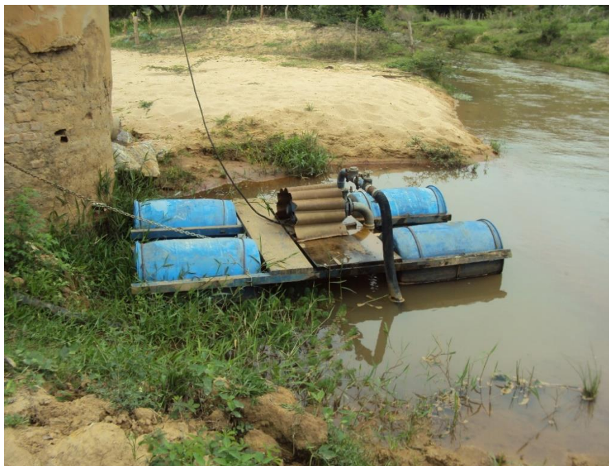
Figura 4 - Aspecto visual da captação de água bruta localizado no rio Capim Anésio (Local: 24K 0265946 7834742/Altitude: 147 m).
