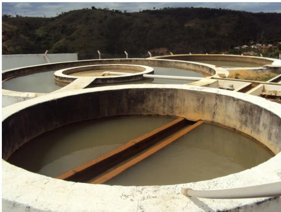
Figura 35 - Floculador (Local: 24K 0257631 7841957 / Altitude: 179 m).
