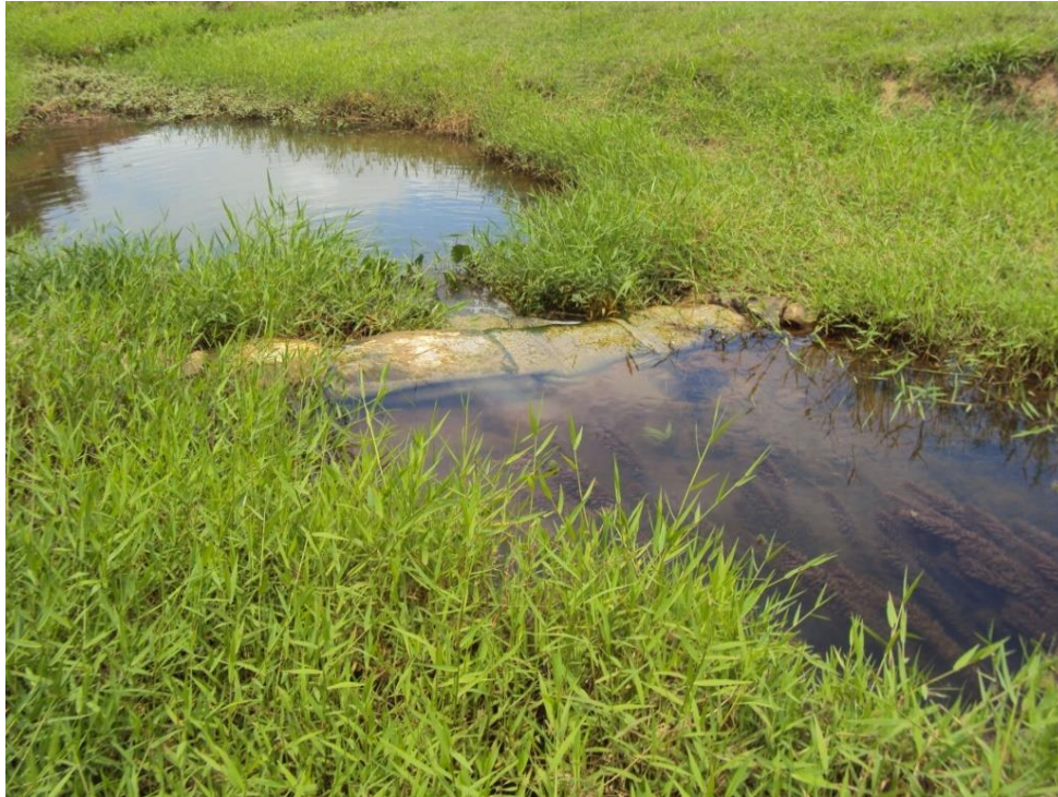
Figura 24 - Vista parcial da pequena barragem no córrego Vala do Ubá para captação de água bruta (Local: 24K 0264463 7817859 / Altitude: 215 m).
