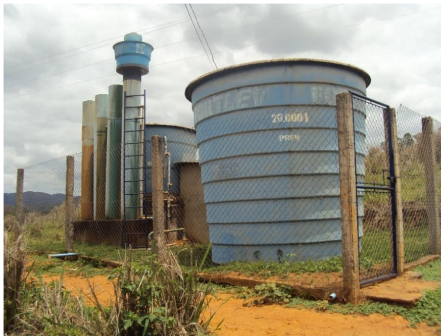
Figura 59 - Reservatório (Local: 24K 0264463 7817859/ Altitude: 206 m).
