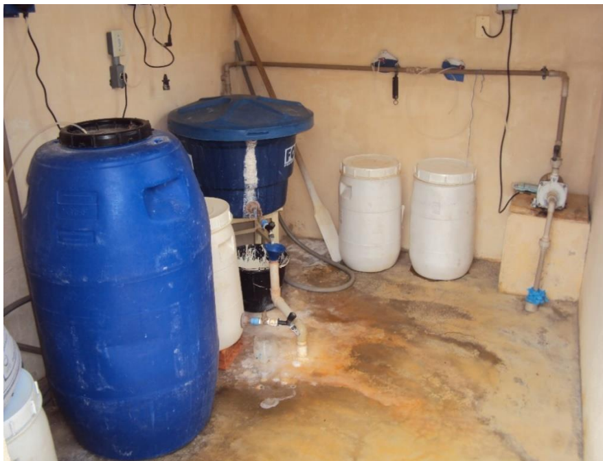
Figura 10 - Área de adição de cloro e flúor (Local: 24K 0281372 7843151 /Altitude: 177 m).
