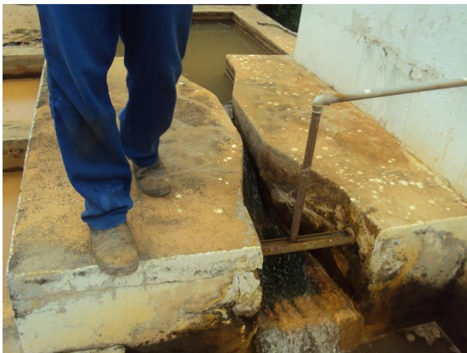
Figura 17 - Adição de Sulfeto de Alumínio (Local: 24K 0263973 7823449 / Altitude: 222 m).
