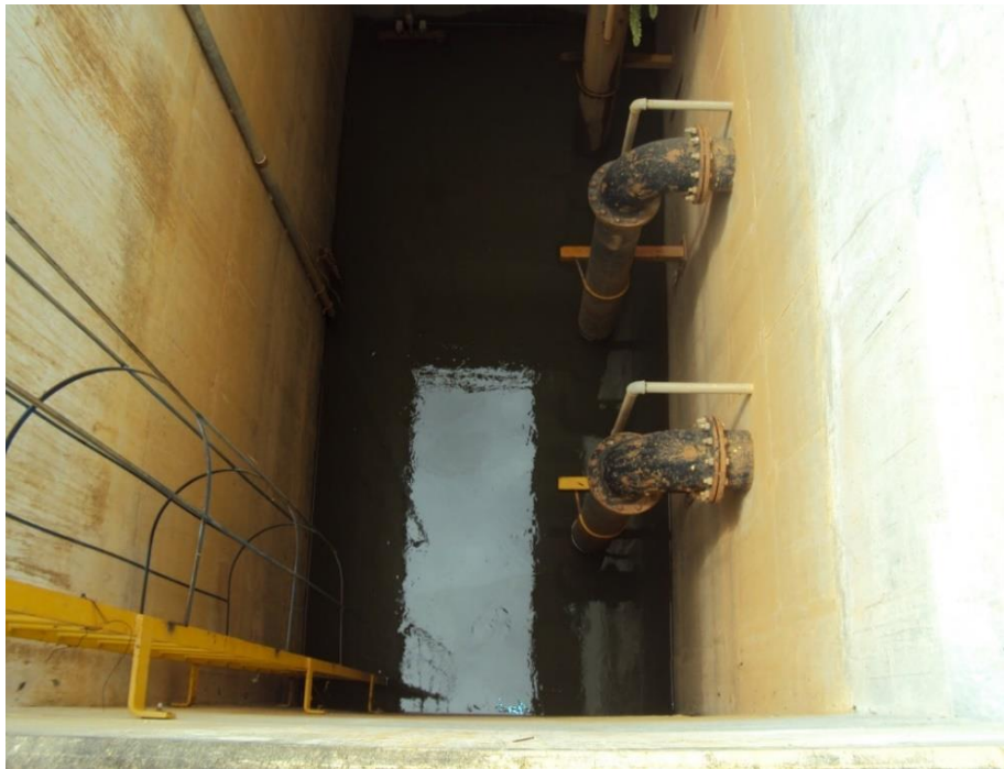
Figura 6 - Aspecto visual do bombeamento da água (Local: 24K 0279712 7844239/Altitude: 88 m).
