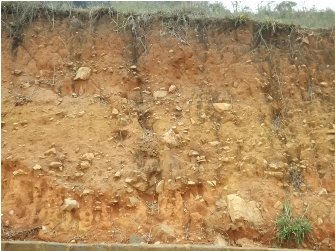
Figura 5- Material resultante (colúvio) de grandes deslizamentos no Distrito de Alto Capim.
