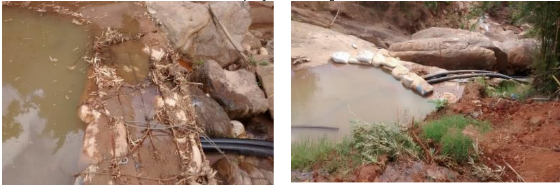
Evidências de captação no córrego Santaninha.
