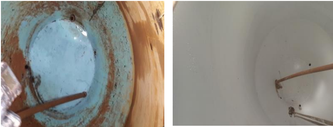
Torre antes da pintura (à esquerda) e depois da pintura (à direita)
