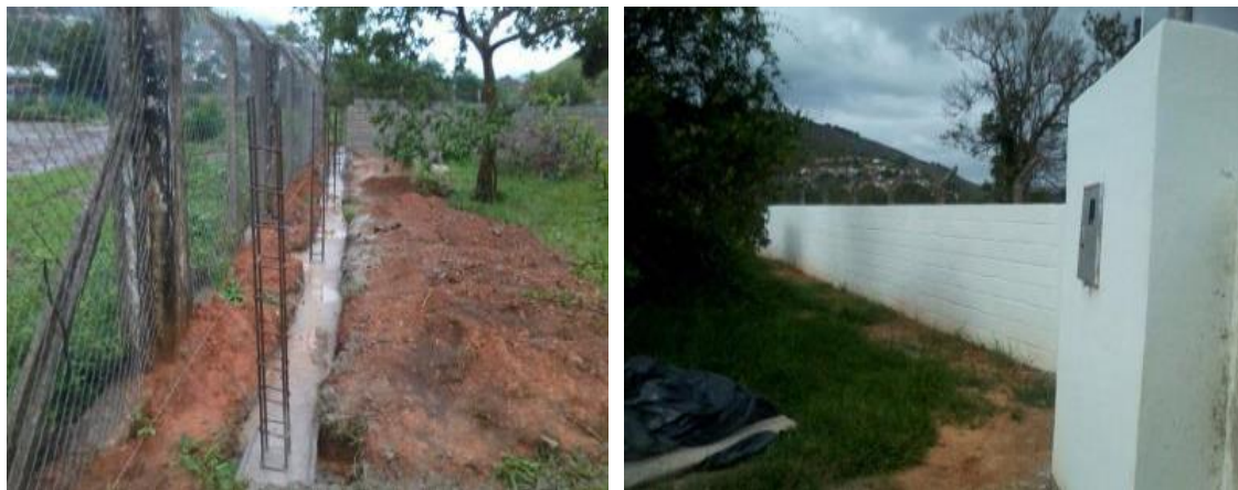
Antes e depois da construção do muro ao redor da ETA de Barra Longa
