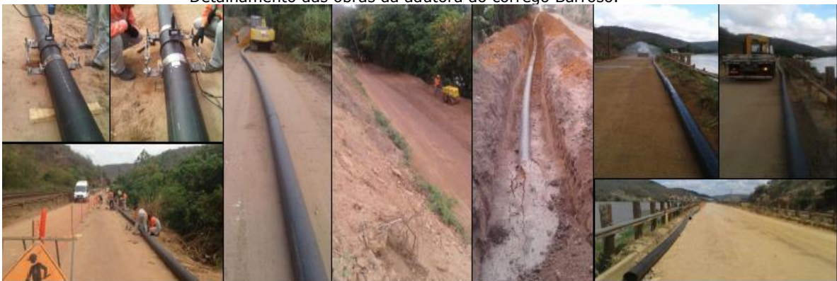
Detalhamento das obras da adutora do córrego Barroso.
