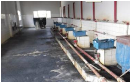
Instalação de instalação de bombas para dosagem de Tanfloc
