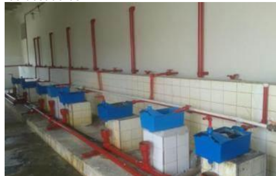
Instalação de instalação de bombas para dosagem de Tanfloc
