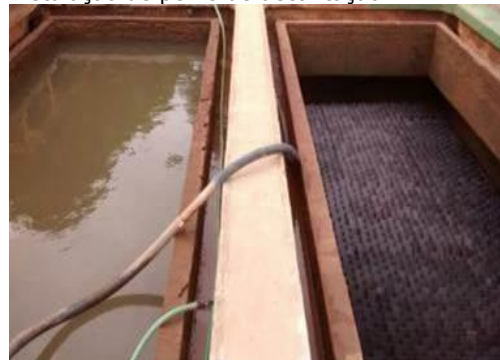
Melhoria do sistema de decantação, pela instalação de perfis de decantação.
