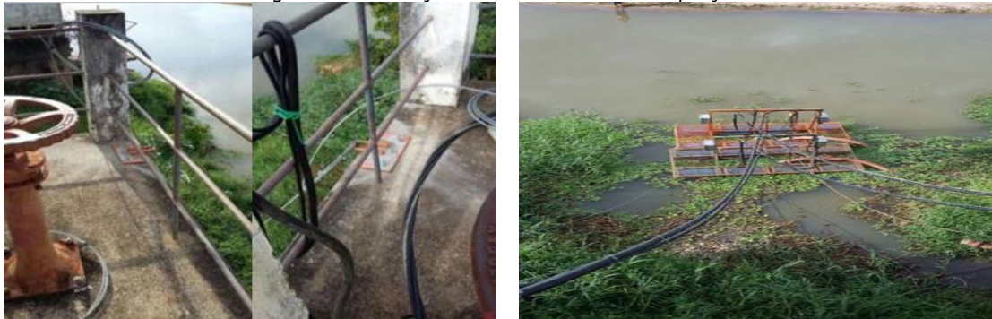
Novo sistema de ancoragem e alimentação elétrica da Balsa de captação da ETA II
