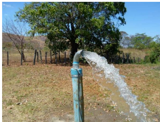
Poço 02 após limpeza, desinfecção e teste de bombeamento
