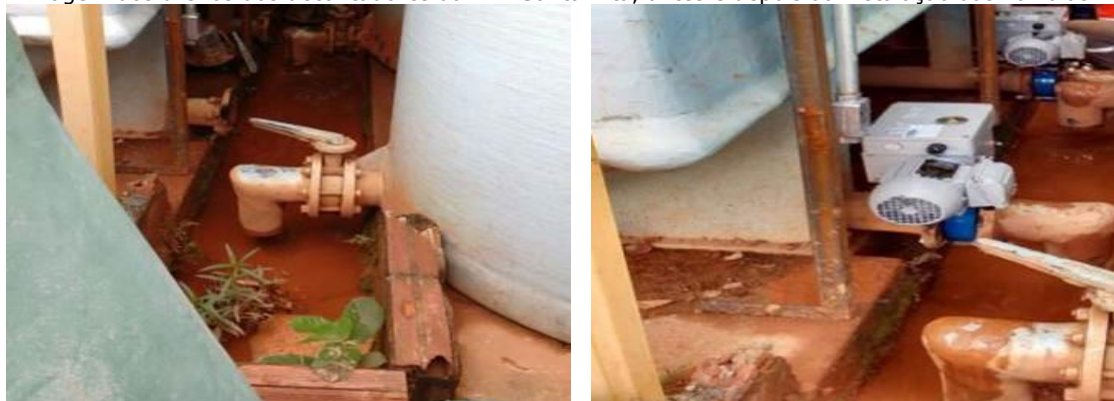
Imagem dos drenos dos decantadores da ETA Santa Rita, antes e depois da instalação das válvulas.
