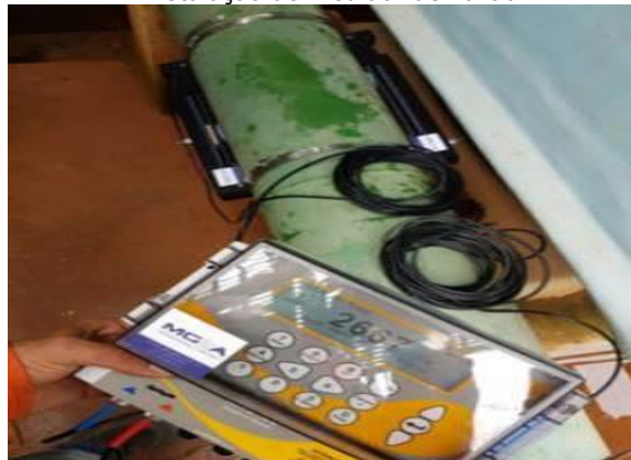
Instalação de medidor de vazão
