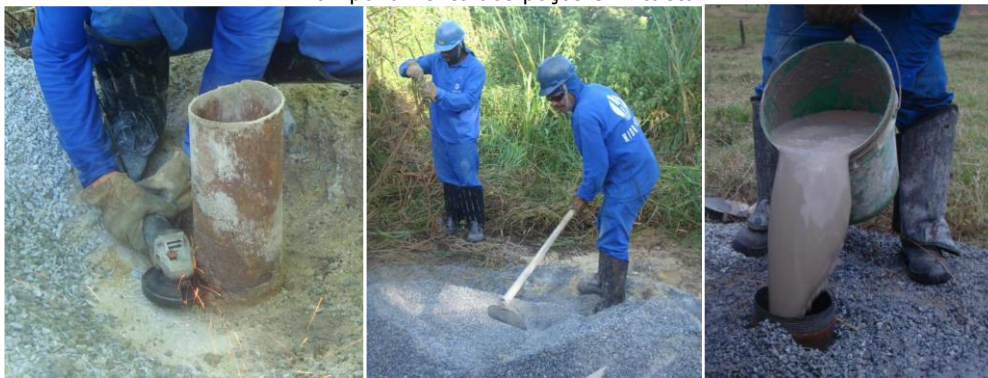
Tamponamento dos poços em Itueta.
