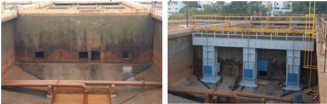
Melhoria da decantação pela instalação de calhas de overflow , cenário de antes e depois, respectivamente à esquerda e à direita.
