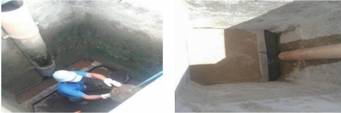
Processo de substituição dos leitos filtrantes de quatro filtros já existentes
