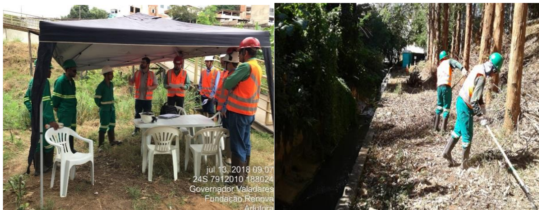
Início da supressão vegetal para realização da obra da adutora de Governador Valadares
