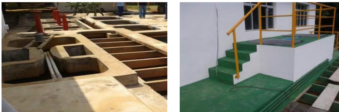
Reforma da calha Parshall , à esquerda, e guarda corpos à direita.
