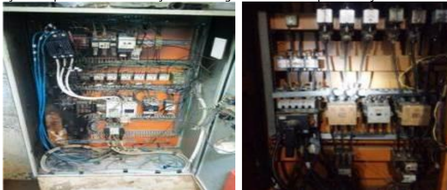
Situação dos painéis de distribuição de voltagem antes da implementação de melhorias.
