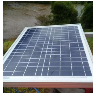
Realizada limpeza do painel solar.
