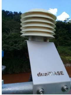
Termohigrômetro encontra-se em perfeito estado de conservação.
