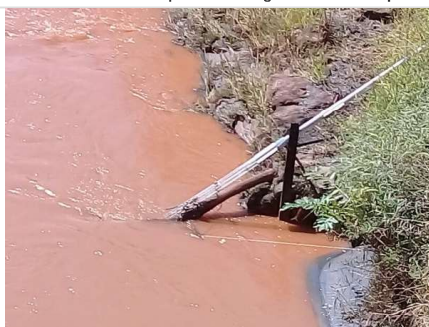
Material acumulado na estrutura.
