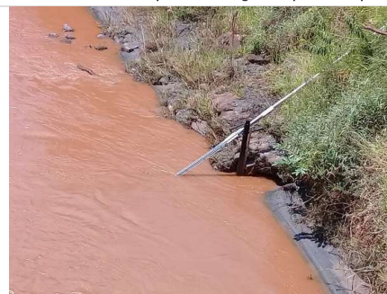
Estrutura após limpeza.
