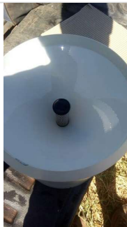
Foto do pluviômetro - Depois da limpeza
