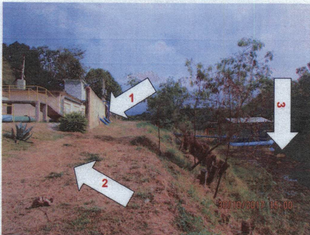
1 - Muro de Contenção, 2 -Ausência do Muro e 3 -Rio Pequeno
