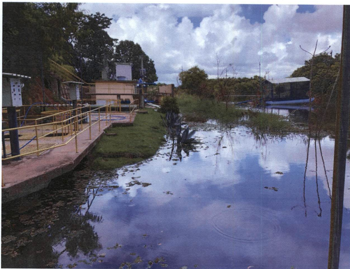
Sistema de Captação de Água Bruta
