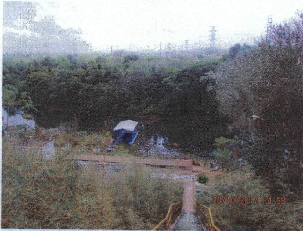
Ponto de Captação da Água bruto no Rio Pequeno
