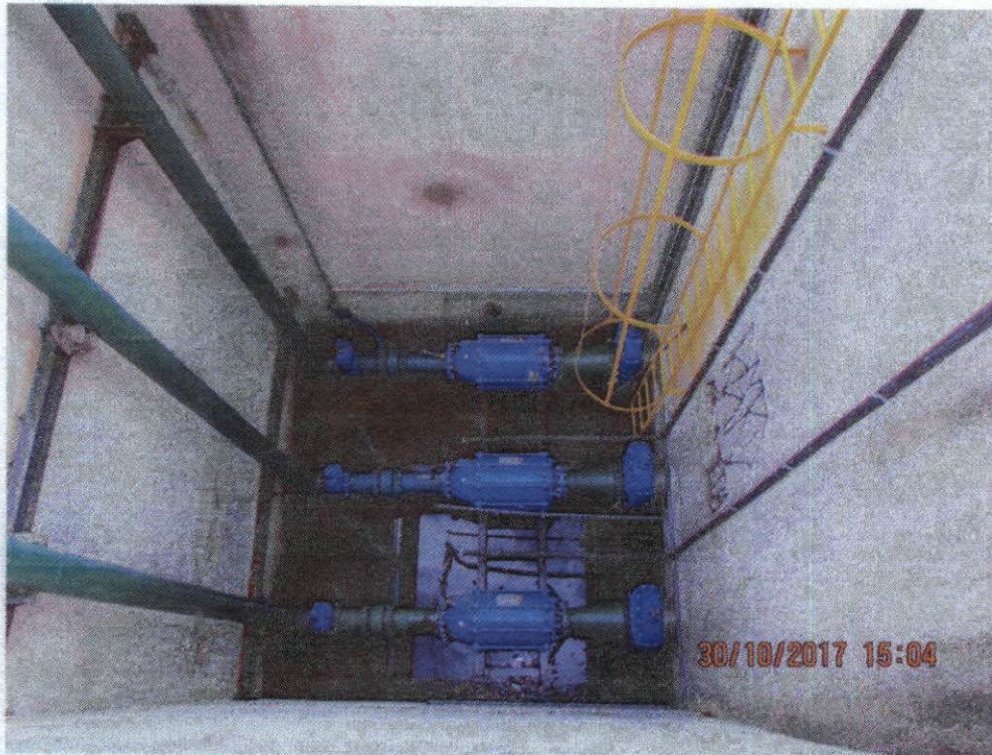
Conjunto de motobomba para elevação água até ETA
