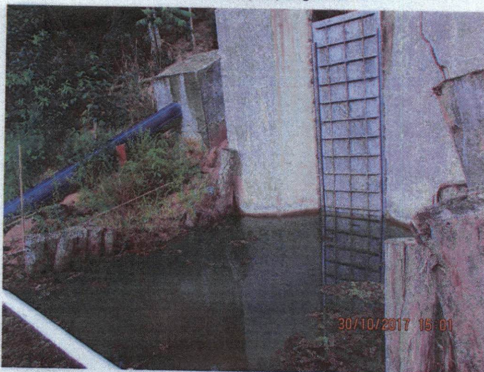
Comporta do sistema de captação por gravidade
