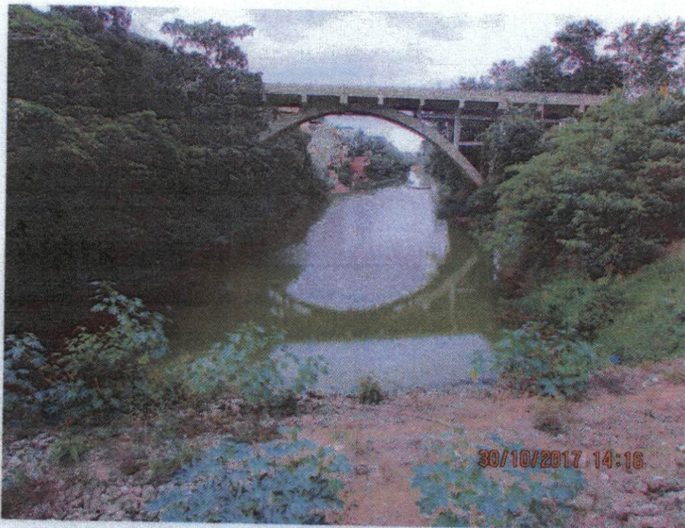
Barragem (lado Rio Doce)
