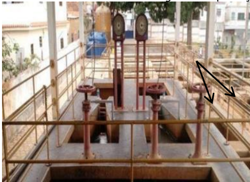
Corrimão e grade de proteção instalados, ambos evidenciados.
