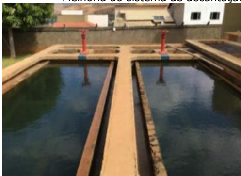
Melhoria do sistema de decantação, pela instalação de perfis de decantação.
