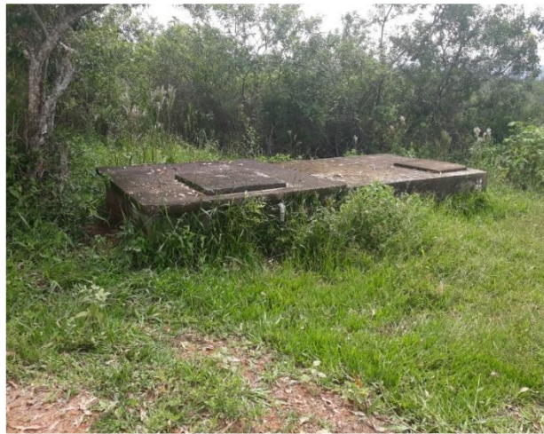
Reservatório de Água de Camargos
