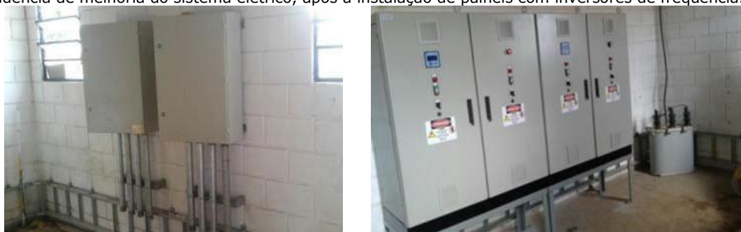
Evidência de melhoria do sistema elétrico, após a instalação de painéis com inversores de frequência.
