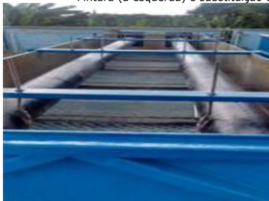
Pintura (à esquerda) e substituição de colmeias (à direita) na ETA Vila Isa.
