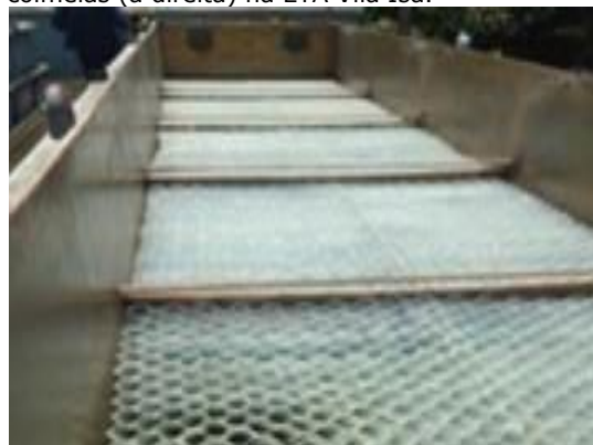
Pintura (à esquerda) e substituição de colmeias (à direita) na ETA Vila Isa.
