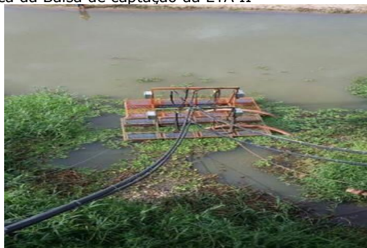
Novo sistema de ancoragem e alimentação elétrica da Balsa de captação da ETA II
