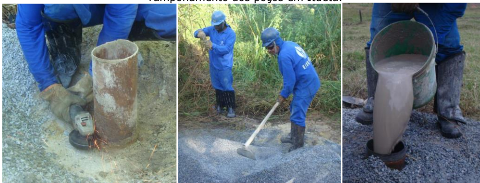
Tamponamento dos poços em Itueta.
