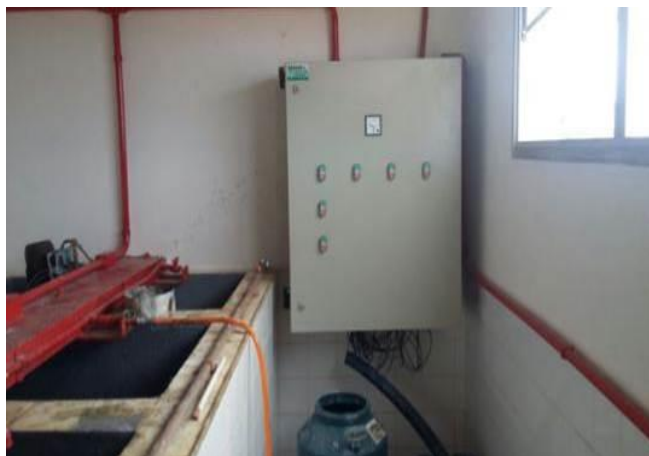
Montagem do painel de comando dos agitadores dos tanques de produto químicos
