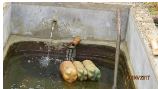
Caixa de areia utilizada após a captação por nascente (à esquerda) e Detalhes de adaptações no sistema de bóias da caixa de areia (à direita)
