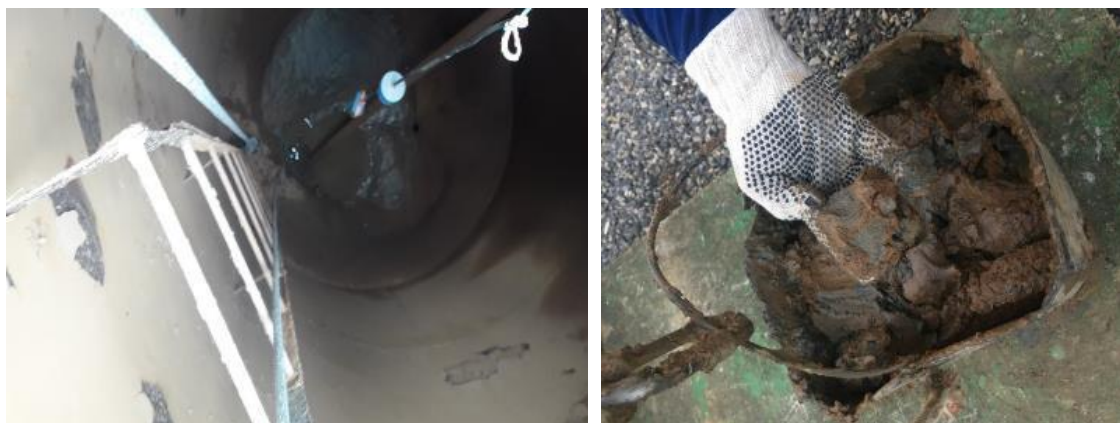
Interior da torre antes da reforma (à esquerda) e material lodoso retirado no interior do castelo d'água
