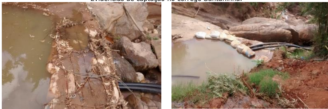
Evidências de captação no córrego Santaninha.
