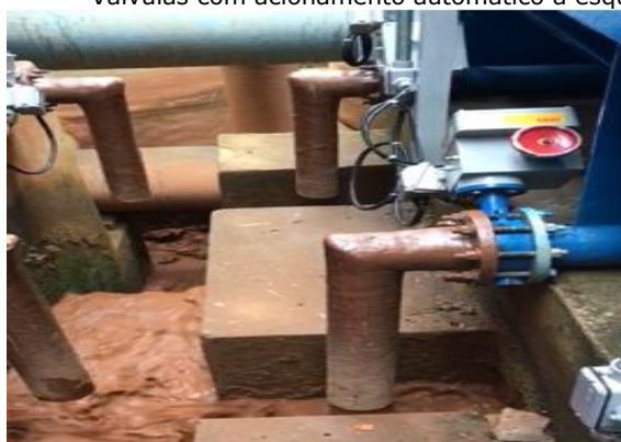
Válvulas com acionamento automático à esquerda e painel de controle instalado à direita.
