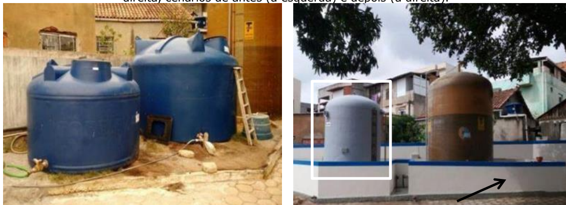
Figura 100 - Construção de caixa de contenção para reagentes e tanque para Tanfloc, evidenciados à direita, cenários de antes (à esquerda) e depois (à direita).
