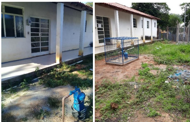
Figura 12 - Perfuração de poço tubular em Gesteira, Barra Longa/MG (captação alternativa), posteriormente com seu entorno protegido
