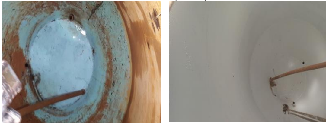
Figura 64 - Torre antes da pintura (à esquerda) e depois da pintura (à direita)
