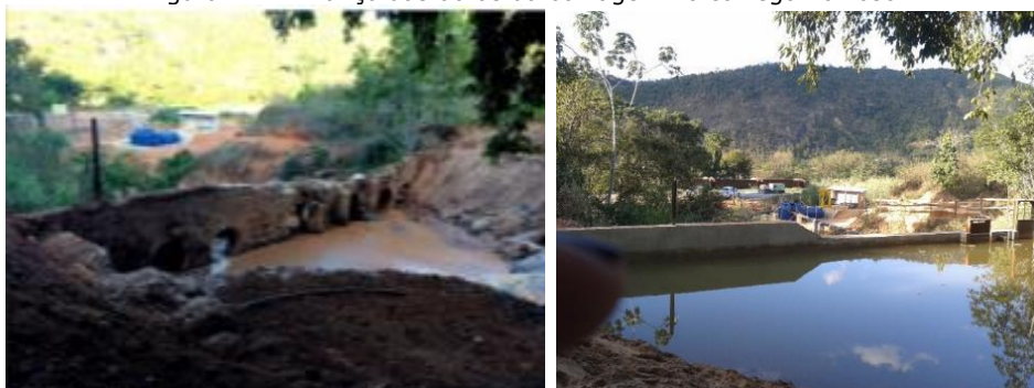
Figura 71 - Avanço das obras da barragem no córrego Barroso.
