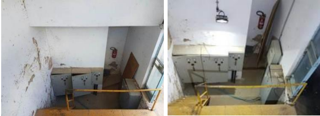
Figura 54 - Imagem da Casa de Bomba de captação antes e depois da instalação de nova iluminação em LED.
