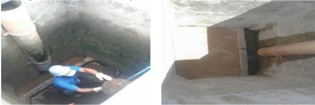
Figura 110 - Processo de substituição dos leitos filtrantes de quatro filtros já existentes
