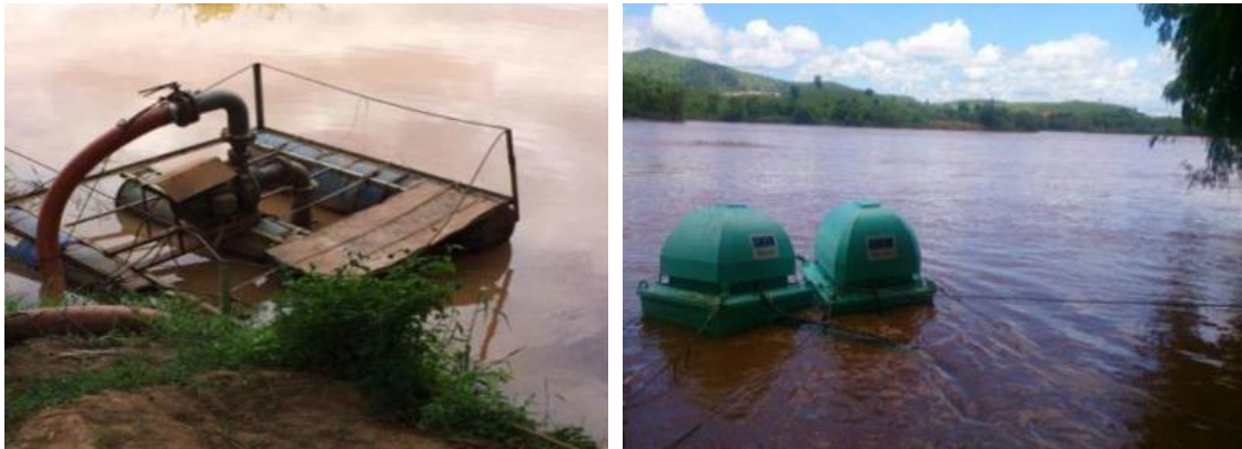
Figura 57 - Imagem do sistema de captação da ETA Santa Rita, antes e depois da substituição dos flutuantes.
