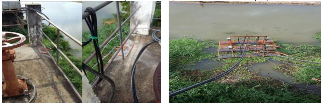
Figura 99 - Novo sistema de ancoragem e alimentação elétrica da Balsa de captação da ETA II
