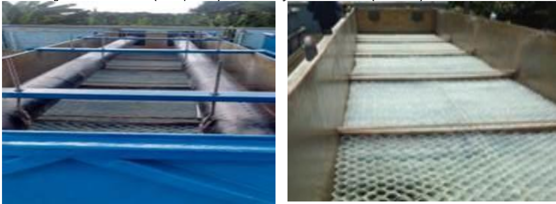
Figura 52 - Pintura (à esquerda) e substituição de colmeias (à direita) na ETA Vila Isa.
