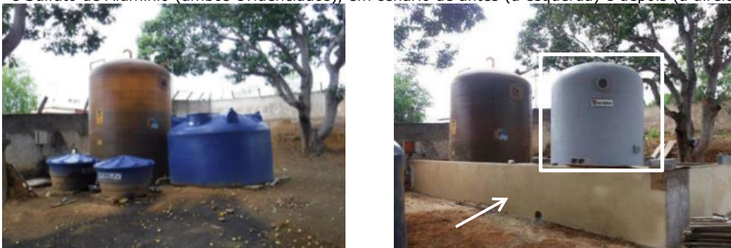
Figura 95 - Instalação de Tanque de Tanfloc de 15.000l (à direita) e Caixa de Contenção para Tanfloc e Sulfato de Alumínio (ambos evidenciados), em cenário de antes (à esquerda) e depois (à direita).
