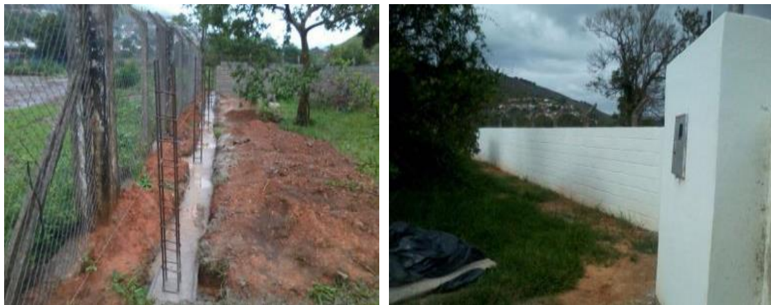
Figura 9 - Antes e depois da construção do muro ao redor da ETA de Barra Longa
