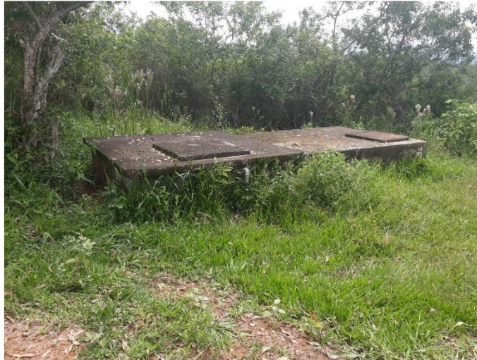
Figura 4 - Reservatório de Água de Camargos.
