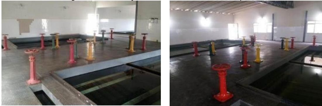
Figura 98 - Substituição do leito filtrante dos filtros "Rápidos"
