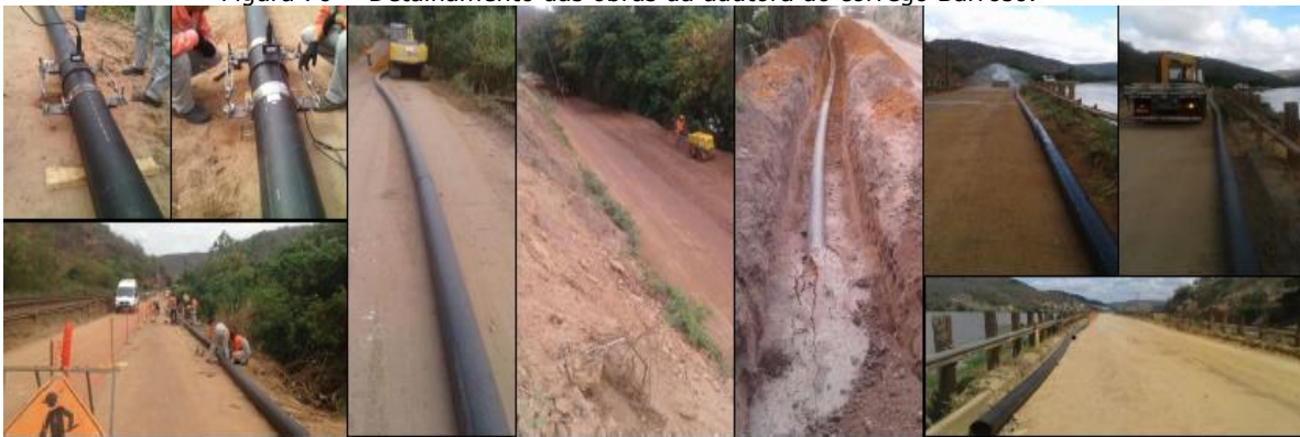
Figura 70 - Detalhamento das obras da adutora do córrego Barroso.
