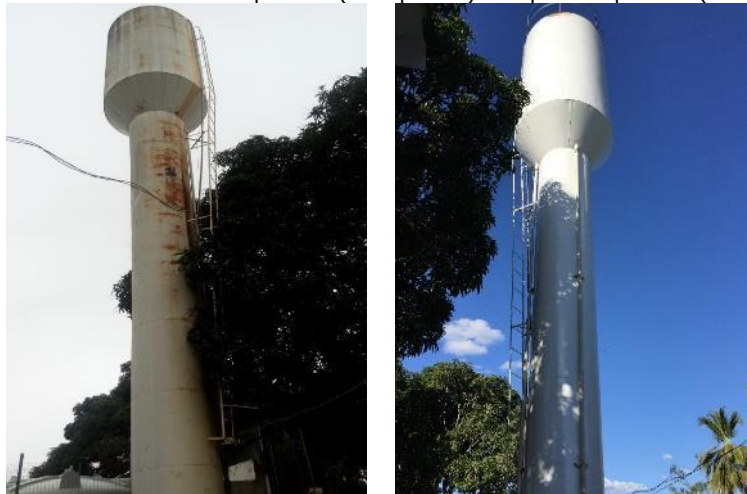
Figura 64 - Torre antes da pintura (à esquerda) e depois da pintura (à direita)
