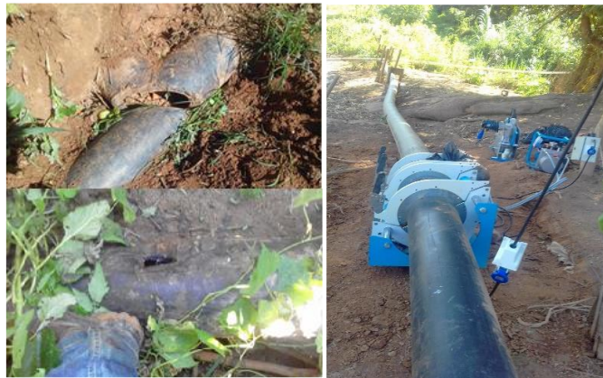
Figura 112 - Reparo e interligação da adutora dos poços; adutora antes do reparo (à esquerda) e após o reparo (à direita)
