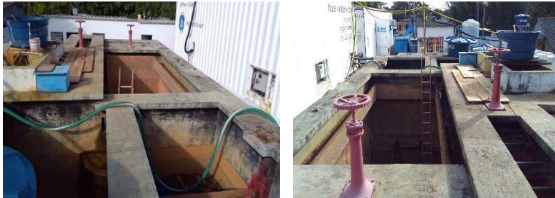
Figura 119 - Instalação de caixas d'água na ETA de Regência.
