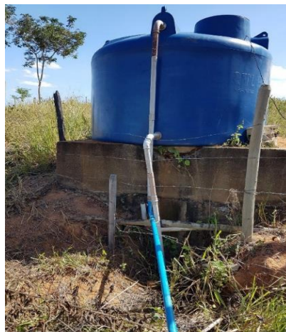
Figura 114 - Reservatório instalado em substituição à cisterna com nova tubulação.
