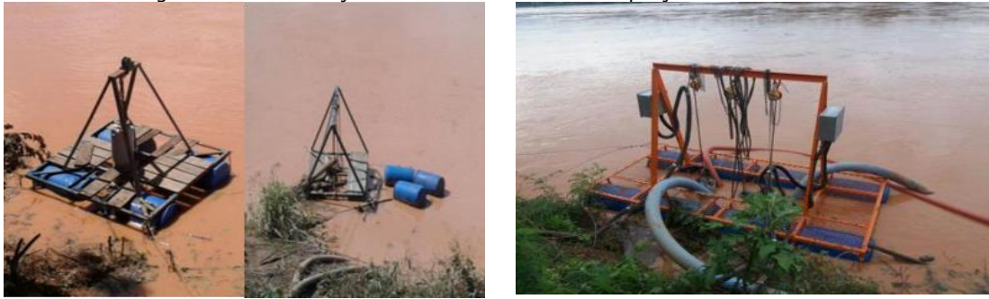
Figura 90 - Substituição de balsa do sistema de captação da ETA I de Colatina.
