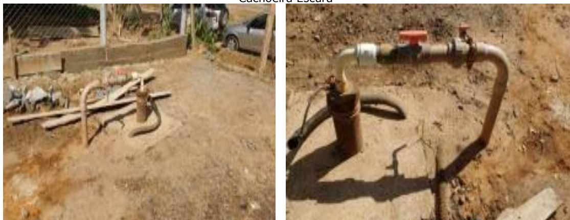
Figura 20 - Poço já perfurado em Belo Oriente, interligado à Estação de Tratamento de Água de Cachoeira Escura
