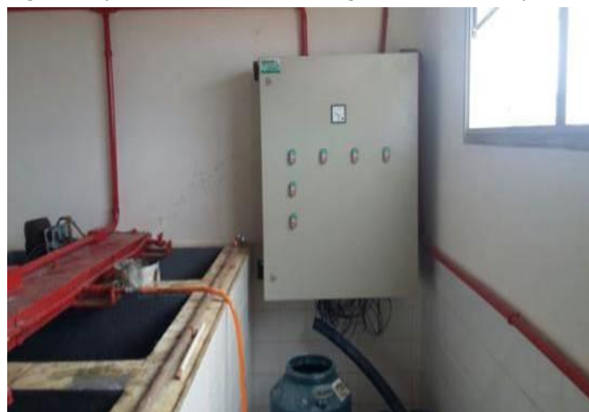
Figura 109 - Montagem do painel de comando dos agitadores dos tanques de produto químico
