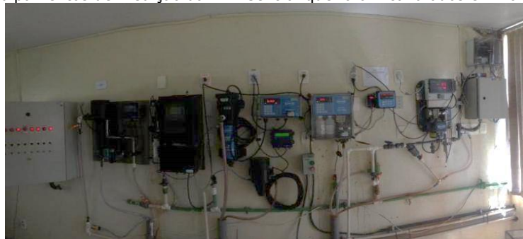
Figura 46 - Equipamentos de medição da ETA Central que foram calibrados em novembro de 2016.
