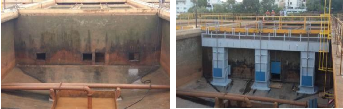
Figura 41 - Melhoria da decantação pela instalação de calhas de overflow , cenário de antes e depois, respectivamente à esquerda e à direita.
