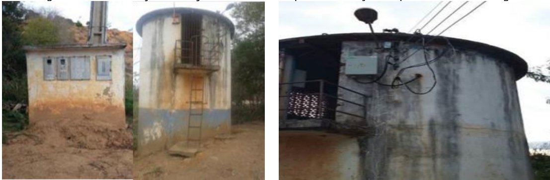
Figura 106 - Instalação de disjuntor de entrada para eliminação do padrão elétrico antigo
