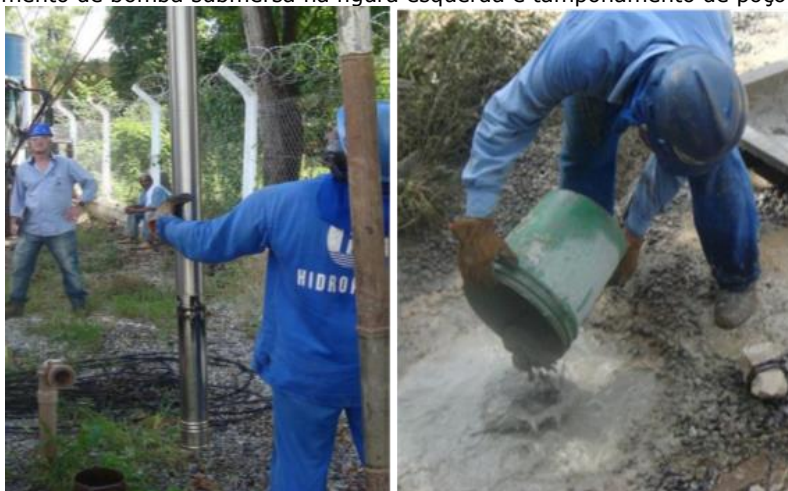
Figura 22 – Içamento de bomba submersa na figura esquerda e tamponamento de poço na figura direita
