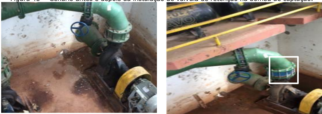
Figura 48 - Cenário antes e depois da instalação de válvula de retenção na bomba de captação.
