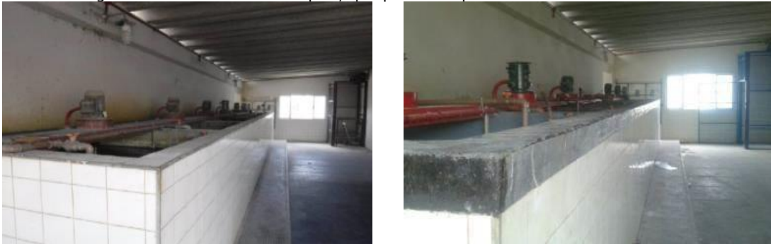
Figura 101: Melhoria dos tanques, que passaram por revestimento de fibra de vidro.
