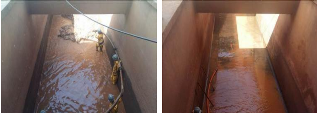
Figura 38 - Cenário de antes e depois da limpeza das caixas, respectivamente à esquerda e à direita.
