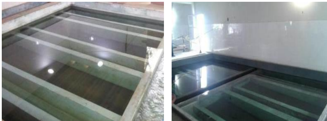
Figura 97 - Substituição do leito filtrante dos filtros “Russos” na ETA II de Colatina
