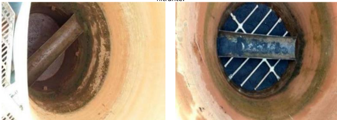
Figura 55 - Imagem de um dos filtros da ETA de Santa Rita, antes e depois da substituição do leito filtrante.
