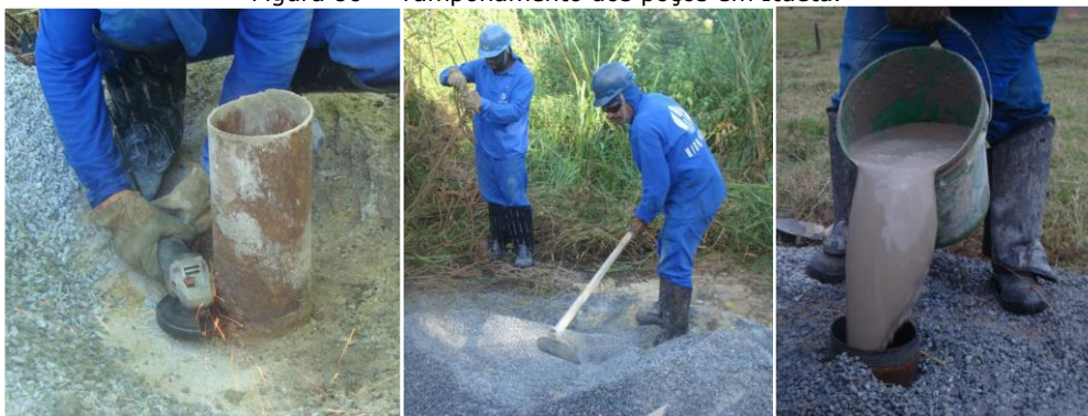
Figura 80 - Tamponamento dos poços em Itueta.
