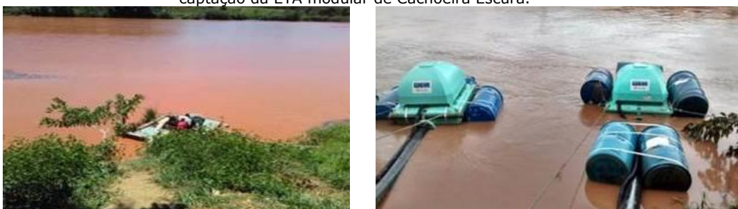
Figura 18 - Substituição da balsa de captação (à esquerda) por dois flutuadores (à direita) no sistema de captação da ETA modular de Cachoeira Escura.
