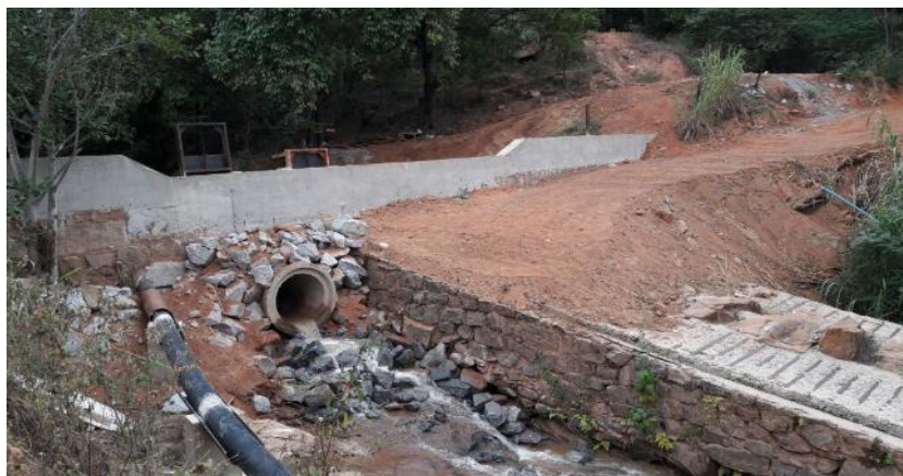
Figura 73 - Barragem no córrego Barroso, após obras de reforço da estrutura.
