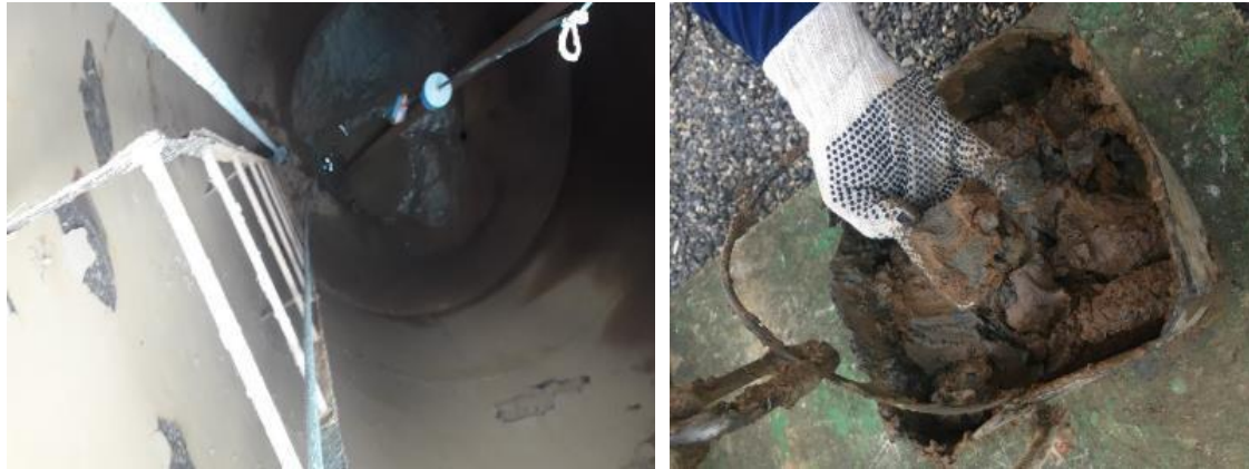
Figura 62 - Interior da torre antes da reforma (à esquerda) e material lodoso retirado no interior do castelo d'água
