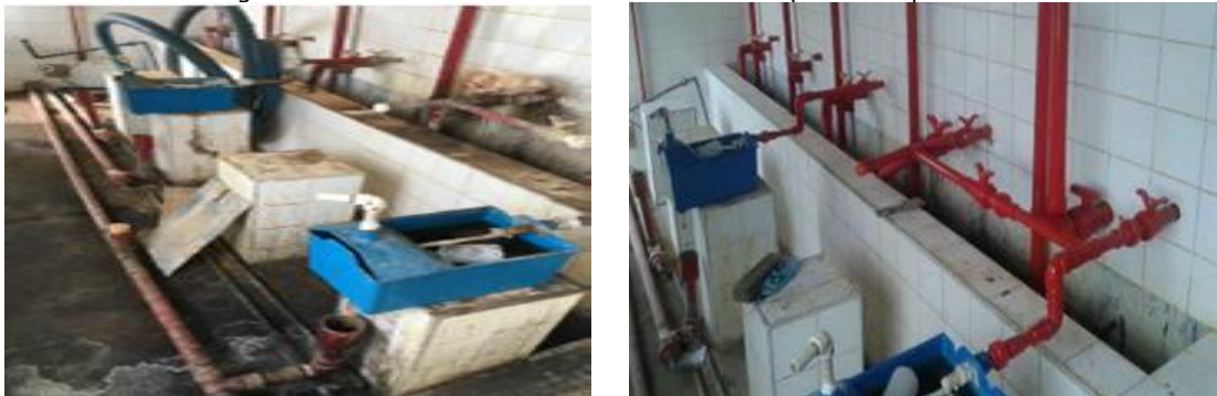
Figura 108 - Reforma das caixas dosadoras dos produtos químicos
