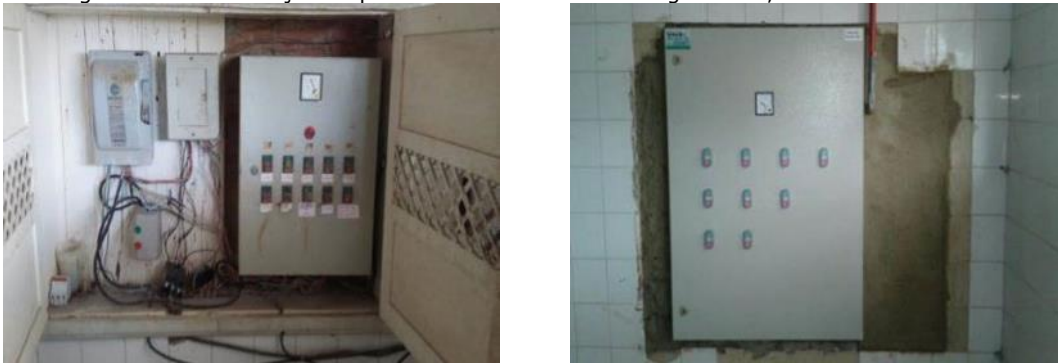
Figura 94 - Substituição do painel de acionamento dos agitadores, na ETA I de Colatina.
