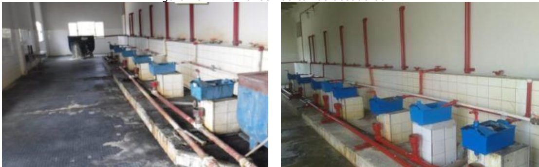
Figura 103 - Instalação de instalação de bombas para dosagem de Tanfloc
