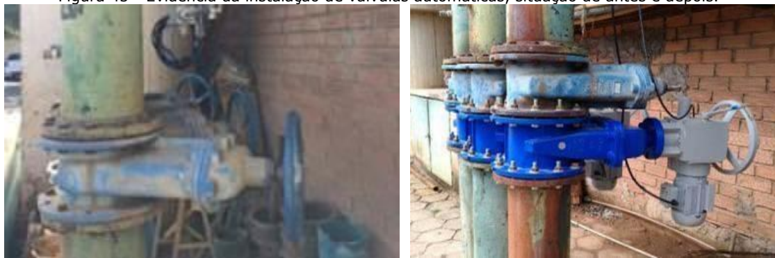
Figura 45 - Evidência da instalação de válvulas automáticas, situação de antes e depois.
