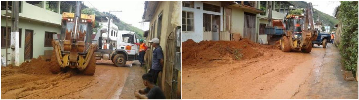
Figura 12: Limpeza de acessos na sede de Barra Longa
