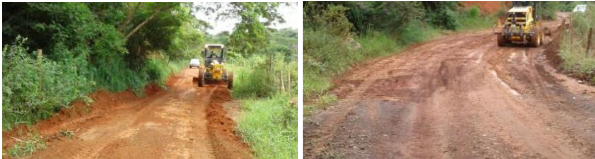
Figura 13: Limpeza do acesso entre Barra Longa e Gesteira
