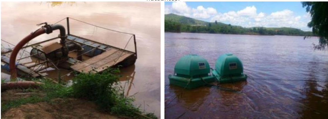
Figura 56 - Imagem do sistema de captação da ETA Santa Rita, antes e depois da substituição dos flutuantes.
