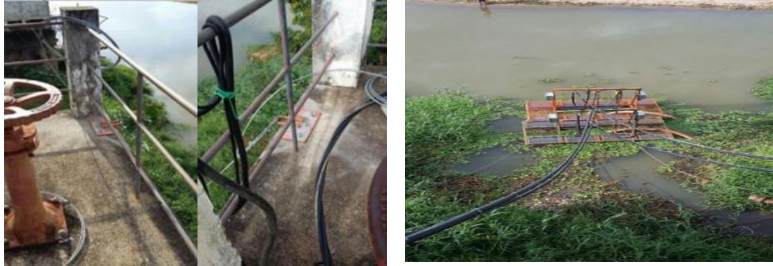
Figura 96 - Novo sistema de ancoragem e alimentação elétrica da Balsa de captação da ETA II
