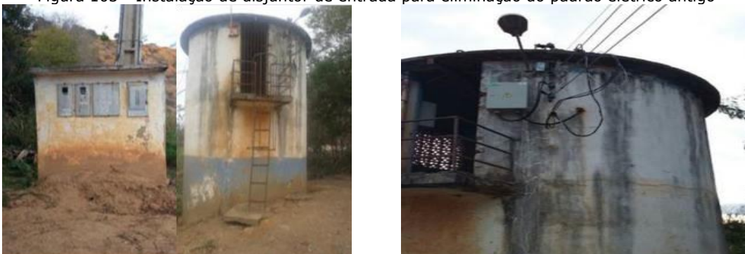
Figura 103 - Instalação de disjuntor de entrada para eliminação do padrão elétrico antigo
