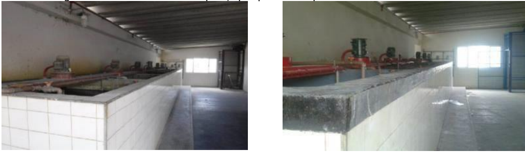
Figura 98: Melhoria dos tanques, que passaram por revestimento de fibra de vidro.
