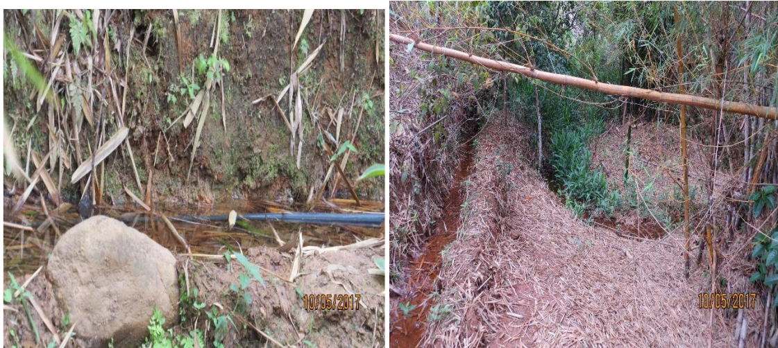
Figura 16 - (à esquerda) Detalhe de captação em nascente para abastecimento de residências no distrito de Barreto - (à direita) Captação em nascente na localidade de Barreto
