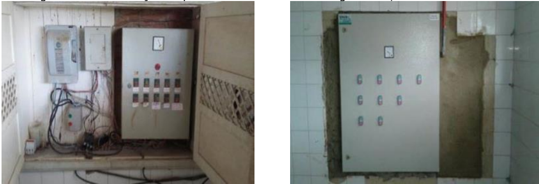
Figura 91 - Substituição do painel de acionamento dos agitadores, na ETA I de Colatina.
