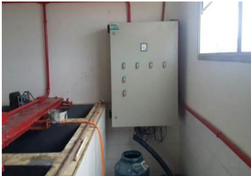
Figura 106 - Montagem do pannel de comando dos agitadores dos tanques de produto químico
