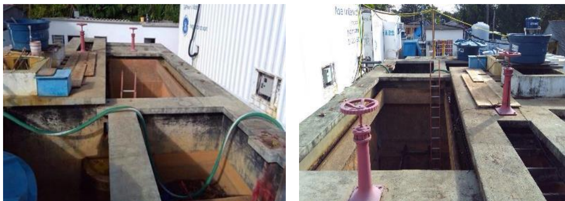
Figura 116 - Instalação de caixas d'água na ETA de Regência.
