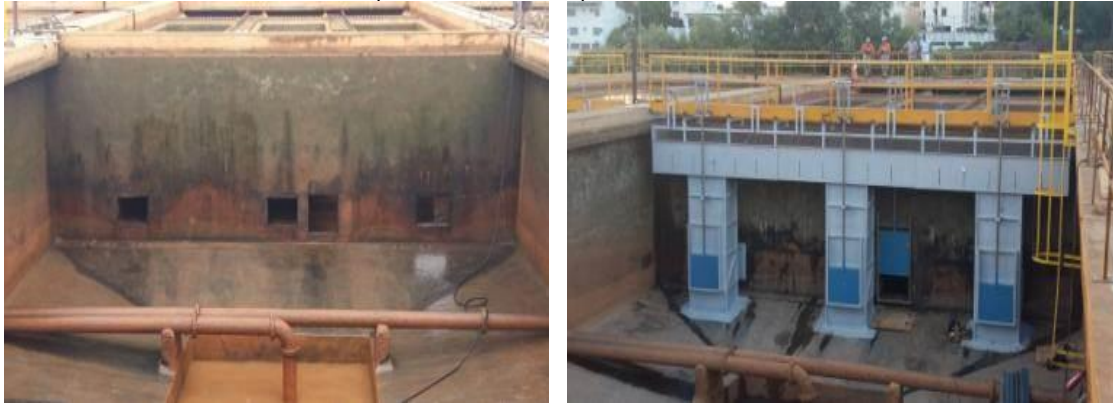
Figura 40 - Melhoria da decantação pela instalação de calhas de overflow , cenário de antes e depois, respectivamente à esquerda e à direita.
