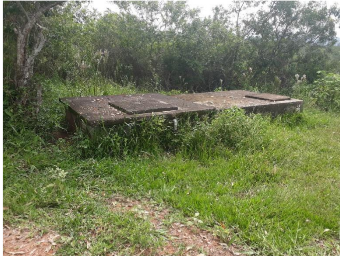
Figura 4 - Reservatório de Água de Camargos.
