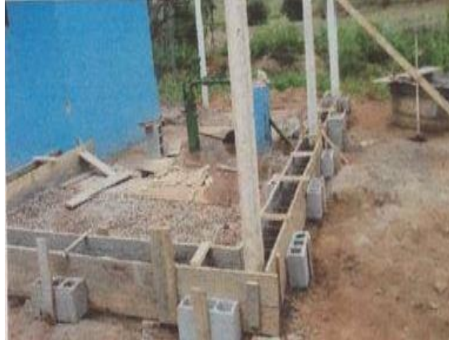
Figura 8 - construção do muro no entorno do reservatório em Gesteira
