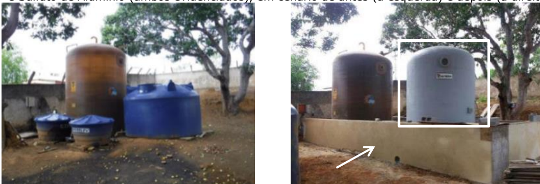
Figura 92 - Instalação de Tanque de Tanfloc de 15.000l (à direita) e Caixa de Contenção para Tanfloc e Sulfato de Alumínio (ambos evidenciados), em cenário de antes (à esquerda) e depois (à direita).
