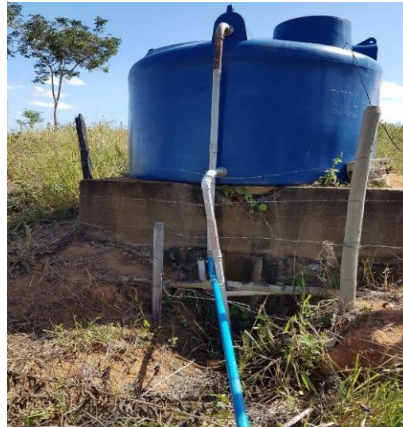
Figura 10 - Reservatório instalado em substituição à cisterna com nova tubulação.
