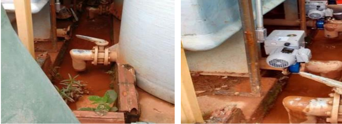
Figura 55: Imagem dos drenos dos decantadores da ETA Santa Rita, antes e depois da instalação das válvulas.
