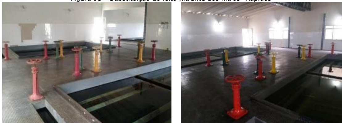
Figura 95 - Substituição do leito filtrante dos filtros “Rápidos”
