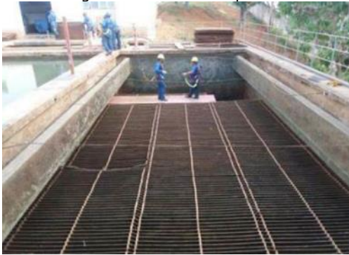
Figura 86 - Troca das placas de amianto (à esquerda) pelos perfis em PVC (à direita).
