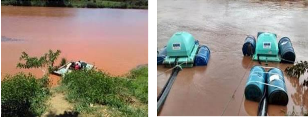
Figura 18 - Substituição da balsa de captação (à esquerda) por dois flutuadores (à direita) no sistema de captação da ETA modular de Cachoeira Escura.
