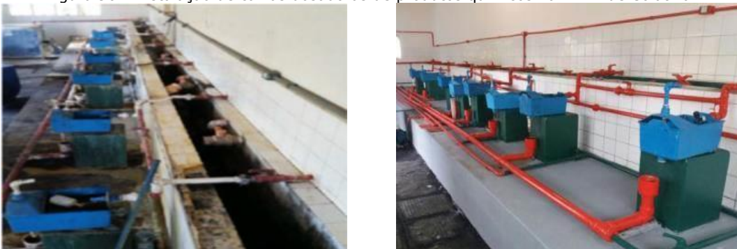
Figura 90 - Instalação de caixas dosadoras de produtos químicos na ETA I de Colatina.
