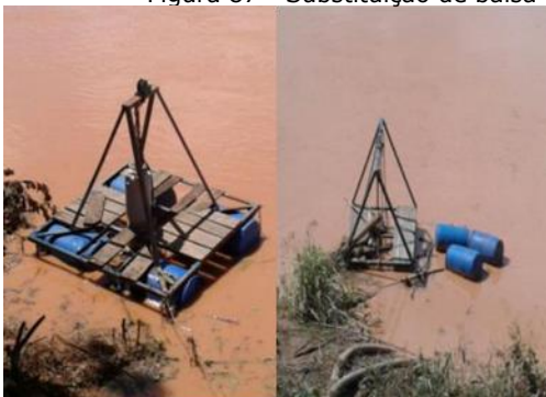
Figura 87 - Substituição de balsa do sistema de captação da ETA I de Colatina.
