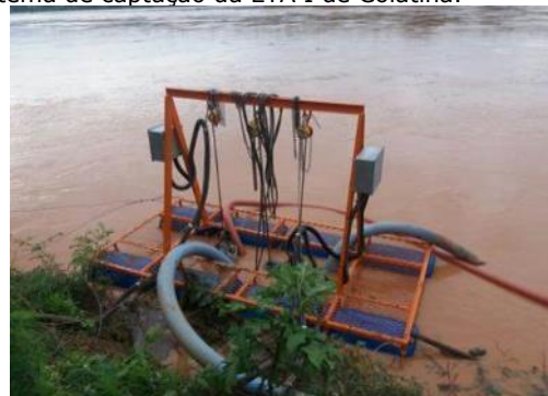
Figura 87 - Substituição de balsa do sistema de captação da ETA I de Colatina.
