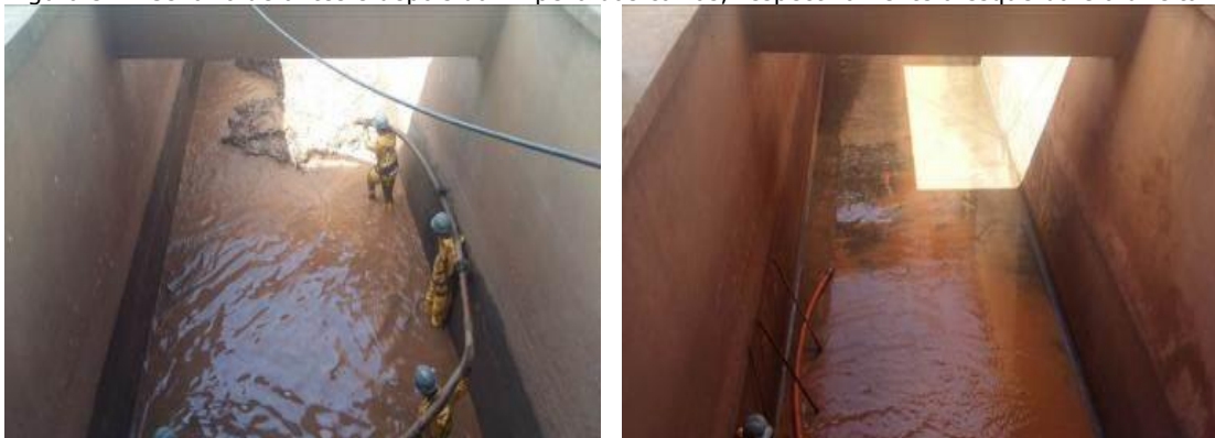
Figura 37 - Cenário de antes e depois da limpeza das caixas, respectivamente à esquerda e à direita.
