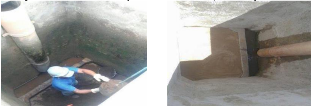
Figura 107 - Processo de substituição dos leitos filtrantes de quatro filtros já existentes
