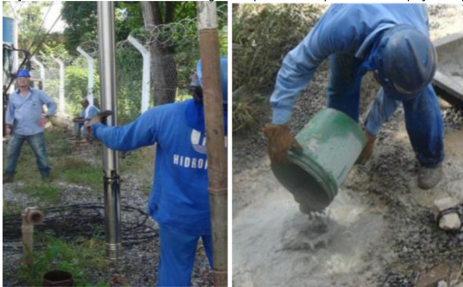
Figura 22 – Içamento de bomba submersa na figura esquerda e tamponamento de poço na figura direita
