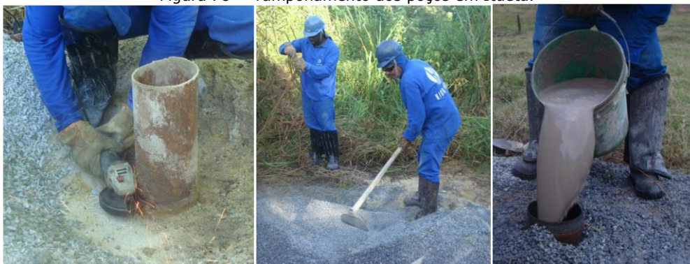
Figura 78 - Tamponamento dos poços em Itueta.
