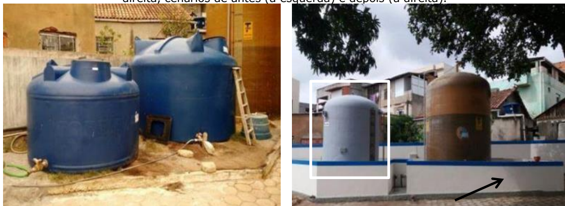
Figura 97 - Construção de caixa de contenção para reagentes e tanque para Tanfloc, evidenciados à direita, cenários de antes (à esquerda) e depois (à direita).
