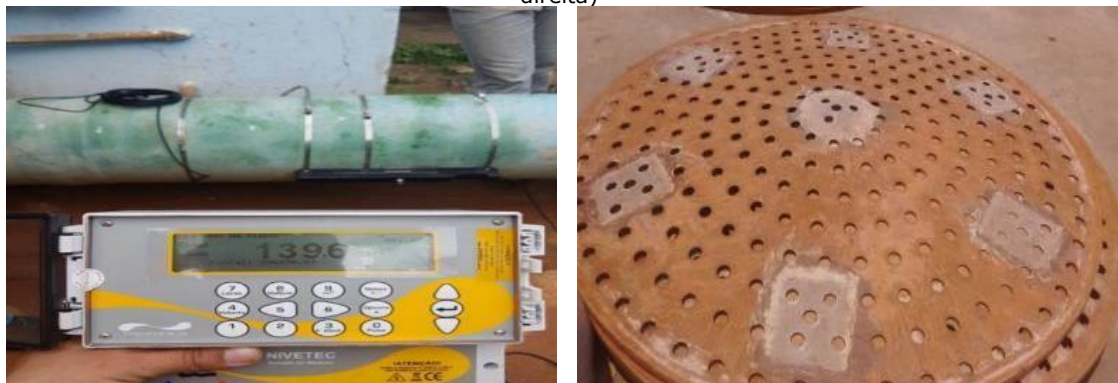
Figura 50 - Sistema de medição melhorado (à esquerda) e manutenção de anel de floculador (à direita)
