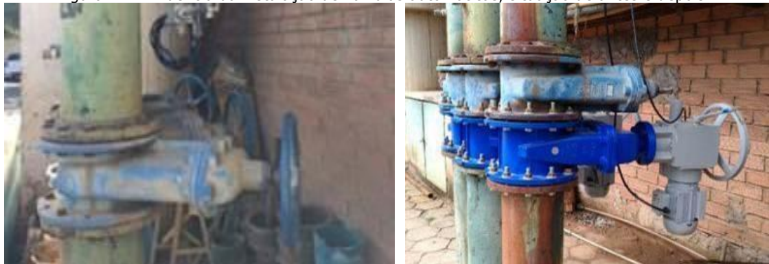
Figura 44 - Evidência da instalação de válvulas automáticas, situação de antes e depois.
