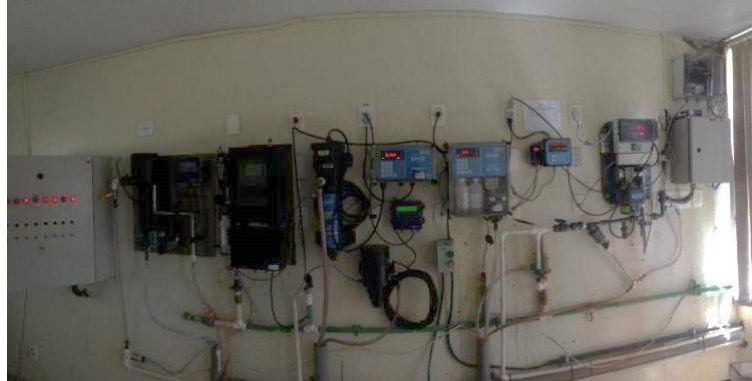
Figura 45 - Equipamentos de medição da ETA Central que foram calibrados em novembro de 2016.
