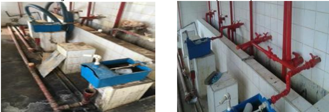
Figura 105 - Reforma das caixas dosadoras dos produtos químicos
