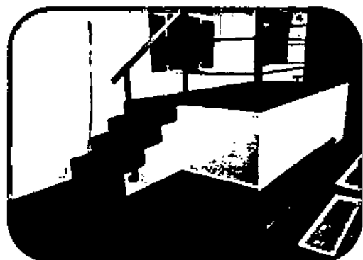
Figura 57: Reforma da calha Parshall , à esquerda, e guarda corpos à direita.
