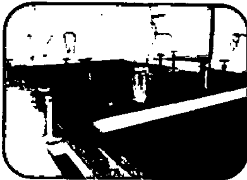
Figura 44: Substituição do leito filtrante dos filtros "Rápidos".
