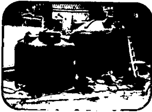
Figura 46: Construção de caixa de contenção para reagentes e tanque para Tanfloc, evidenciados à direita, cenários de antes (à esquerda) e depois (à direita).
