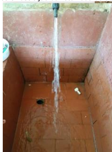
Figura 11 - Ilustração da limpeza dos reservatórios e ilustração da retomada do abastecimento.
