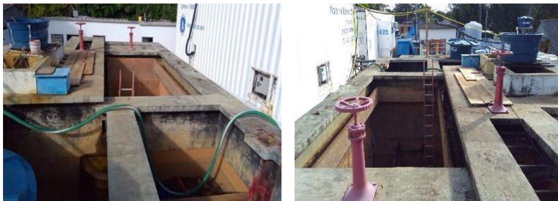
Figura 116 - Instalação de caixas d'água na ETA de Regência.
