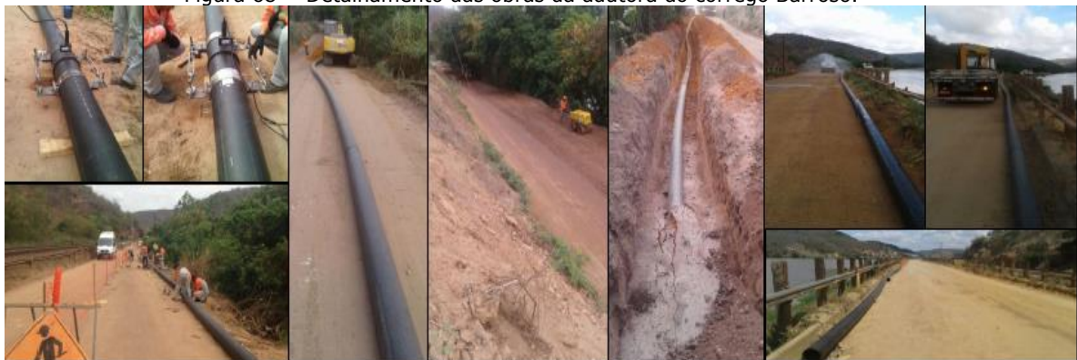
Figura 68 - Detalhamento das obras da adutora do córrego Barroso.
