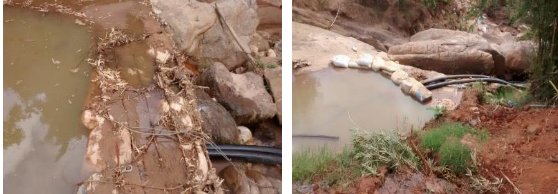
Figura 67 - Evidências de captação no córrego Santaninha.
