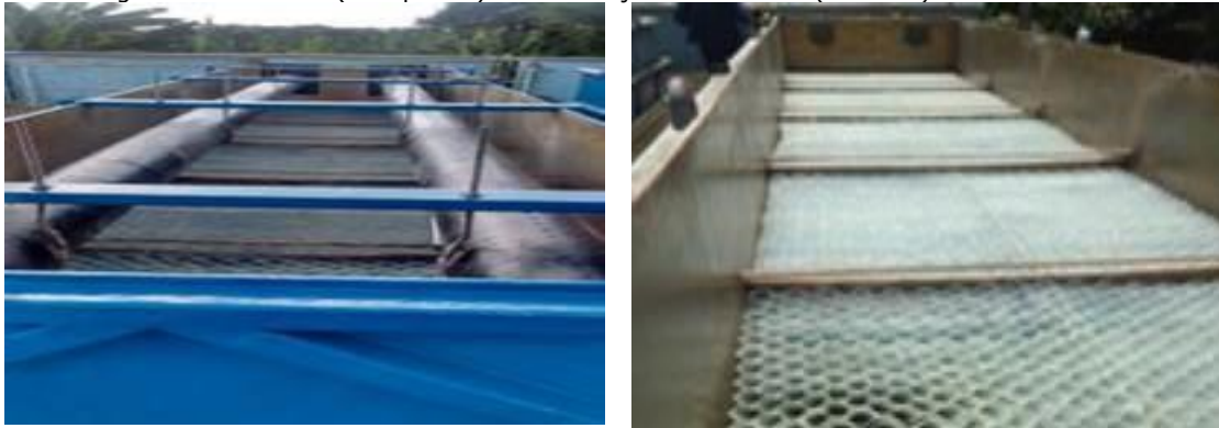
Figura 51 - Pintura (à esquerda) e substituição de colmeias (à direita) na ETA Vila Isa.
