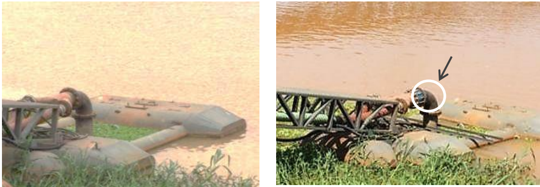
Figura 46 - Cenário de antes e depois, evidenciando a instalação de válvula de retenção.
