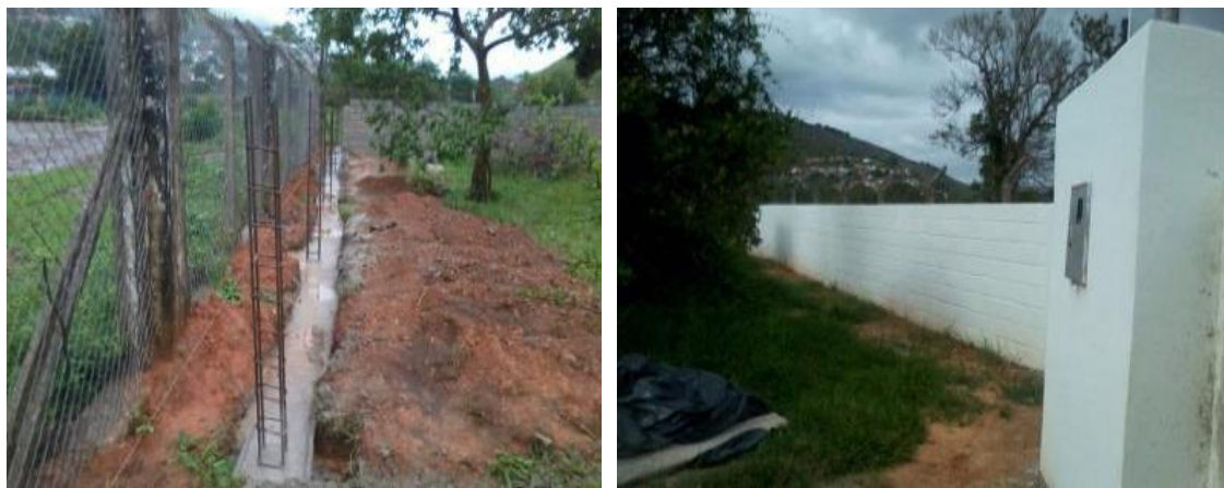
Figura 9 - Antes e depois da construção do muro ao redor da ETA de Barra Longa
