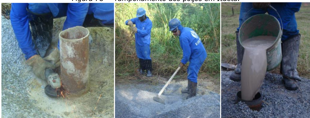
Figura 78 - Tamponamento dos poços em Itueta.
