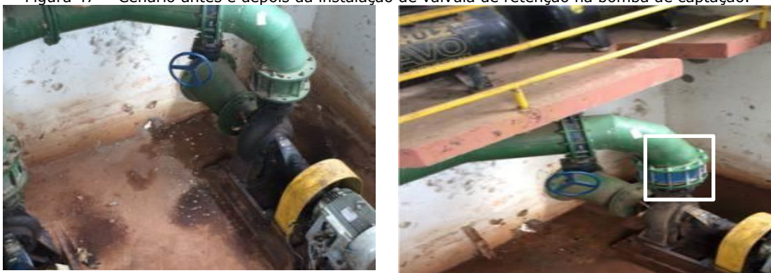
Figura 47 - Cenário antes e depois da instalação de válvula de retenção na bomba de captação.
