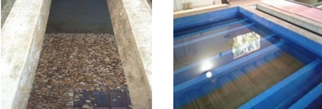
Figura 85 - Substituição do leito filtrante (exemplo à esquerda) por novos (exemplo à direita)
