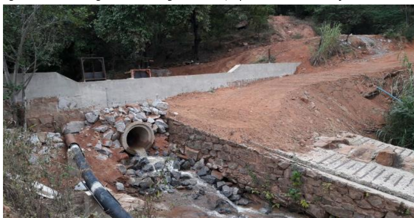
Figura 71 - Barragem no córrego Barroso, após obras de reforço da estrutura.
