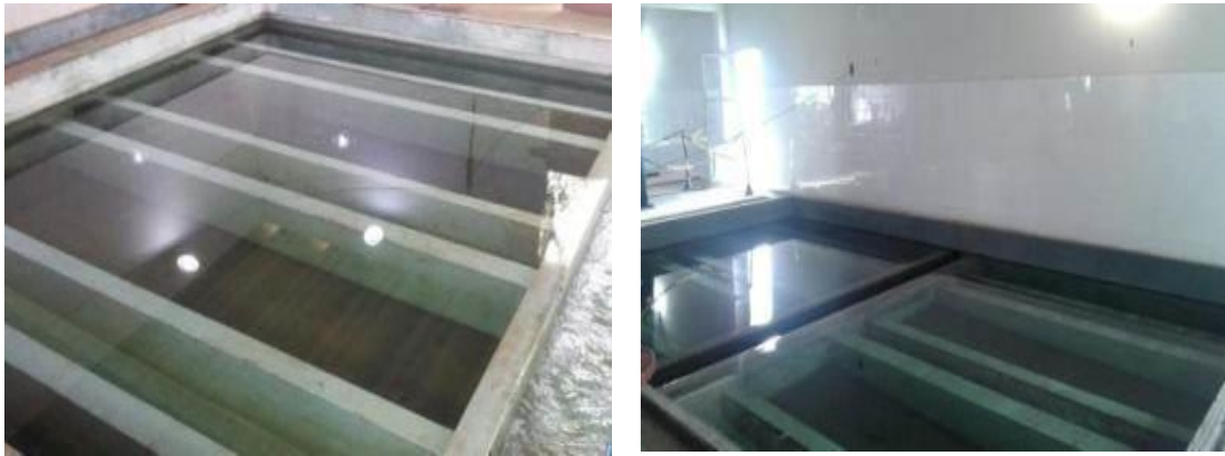
Figura 94 - Substituição do leito filtrante dos filtros "Russos" na ETA II de Colatina
