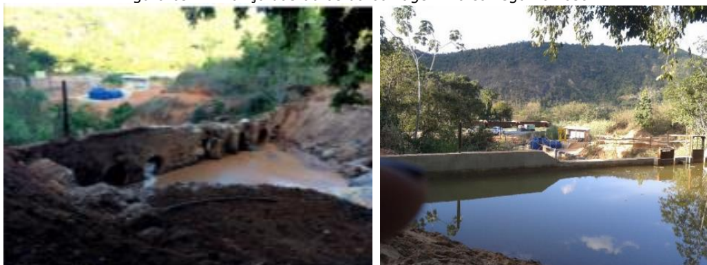
Figura 69 - Avanço das obras da barragem no córrego Barroso.
