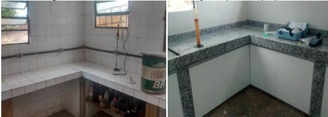
Figura 28 - Reforma do laboratório na Casa de Química (antes e depois).
