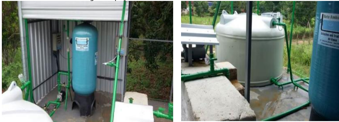
Figura 59 - Imagem do filtro (à esquerda) e do reservatório (à direita) do sistema de tratamento da água do poço do distrito de São Tomé do Rio Doce.
