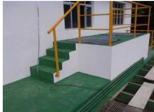
Figura 108 - Reforma da calha Parshall , à esquerda, e guarda corpos à direita.
