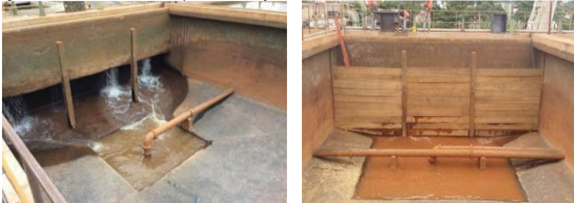
Figura 41 - Cenário de antes e depois da instalação de cortina de madeira na entrada do Decantador 02
