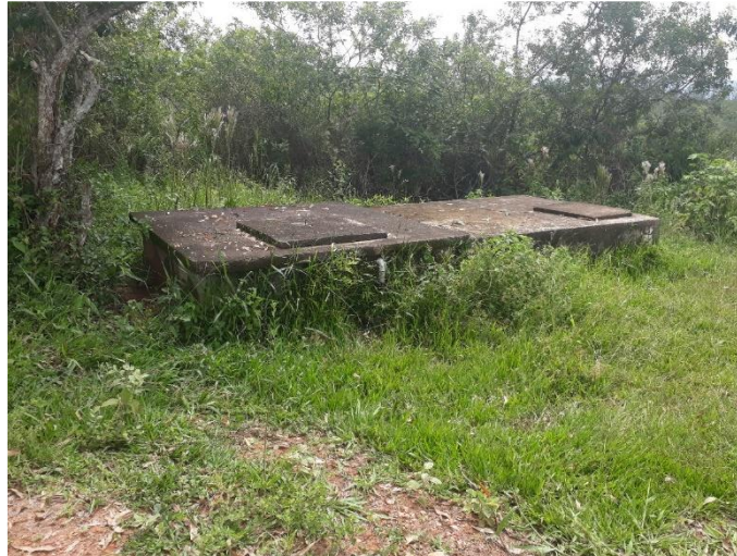
Figura 4 - Reservatório de Água de Camargos.
