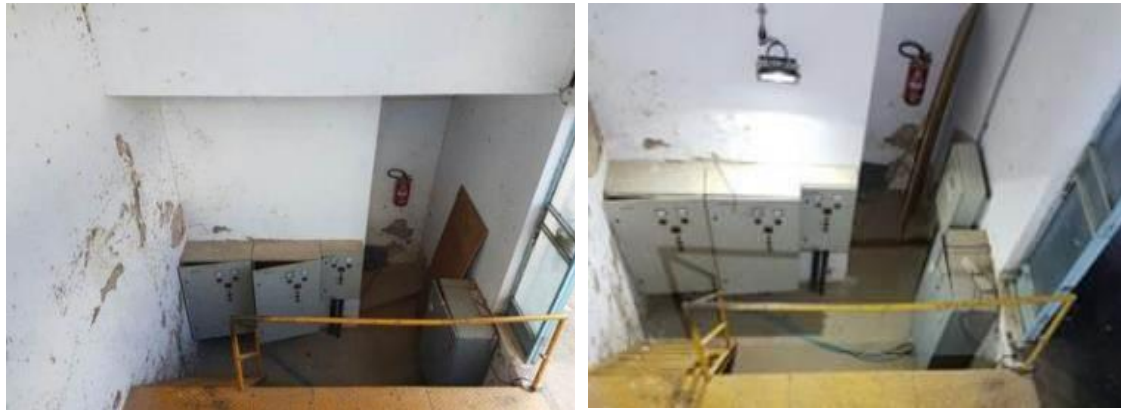
Figura 53 - Imagem da Casa de Bomba de captação antes e depois da instalação de nova iluminação em LED.
