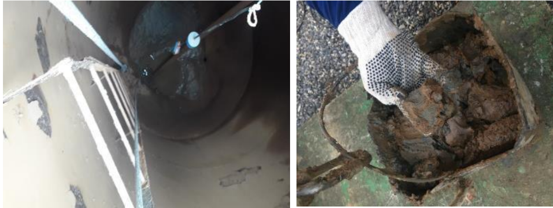
Figura 60 - Interior da torre antes da reforma (à esquerda) e material lodoso retirado no interior do castelo d'água
