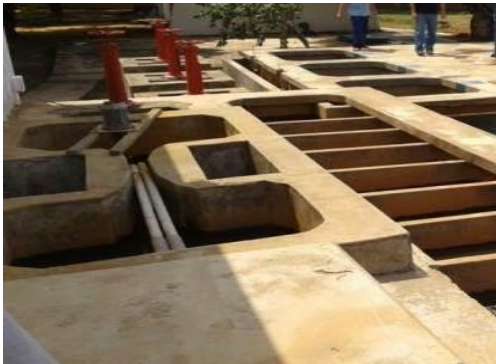
Figura 108 - Reforma da calha Parshall , à esquerda, e guarda corpos à direita.
