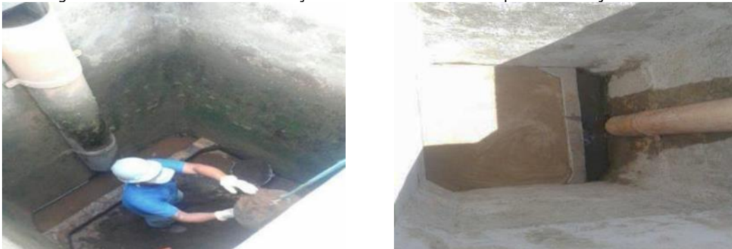
Figura 107 - Processo de substituição dos leitos filtrantes de quatro filtros já existentes
