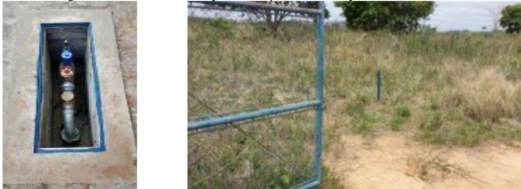
Figura 34 - Evidência de Poço 01 à esquerda e de Poço 02 à direita.
