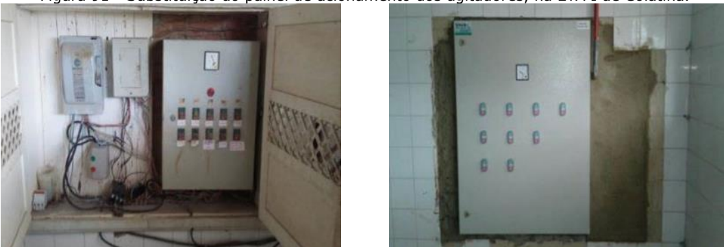
Figura 91 - Substituição do painel de acionamento dos agitadores, na ETA I de Colatina.
