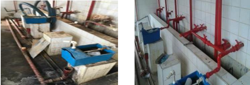
Figura 105 - Reforma das caixas dosadoras dos produtos químicos
