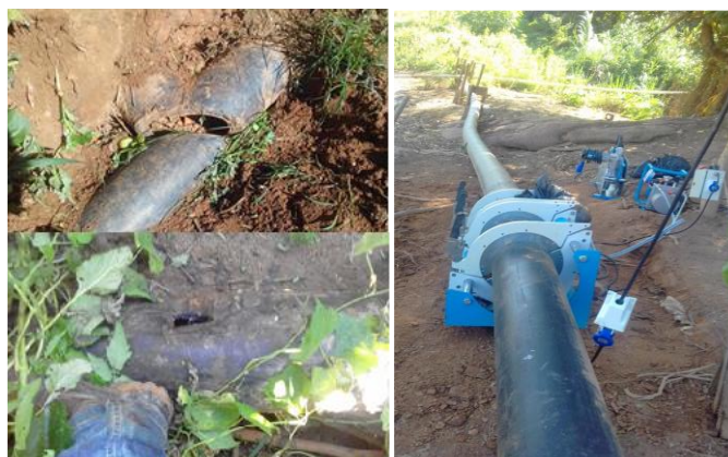
Figura 109 - Reparo e interligação da adutora dos poços; adutora antes do reparo (à esquerda) e após o reparo (à direita)
