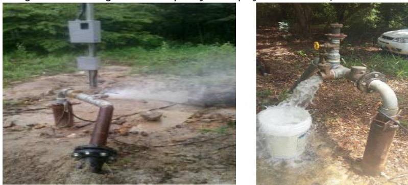
Figura 76 - Imagem de recuperação de poço da COPASA, em Itueta.
