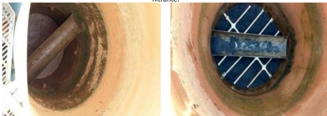
Figura 54 - Imagem de um dos filtros da ETA de Santa Rita, antes e depois da substituição do leito filtrante.
