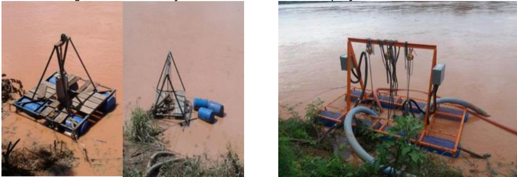
Figura 87 - Substituição de balsa do sistema de captação da ETA I de Colatina.
