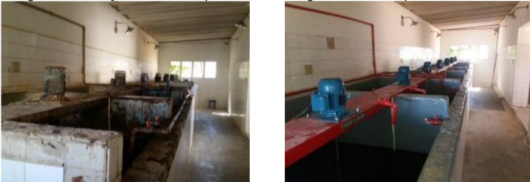
Figura 90 - Instalação de caixas dosadoras de produtos químicos na ETA I de Colatina.
