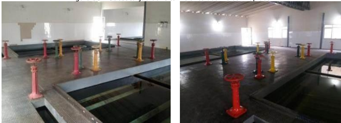
Figura 95 - Substituição do leito filtrante dos filtros "Rápidos"
