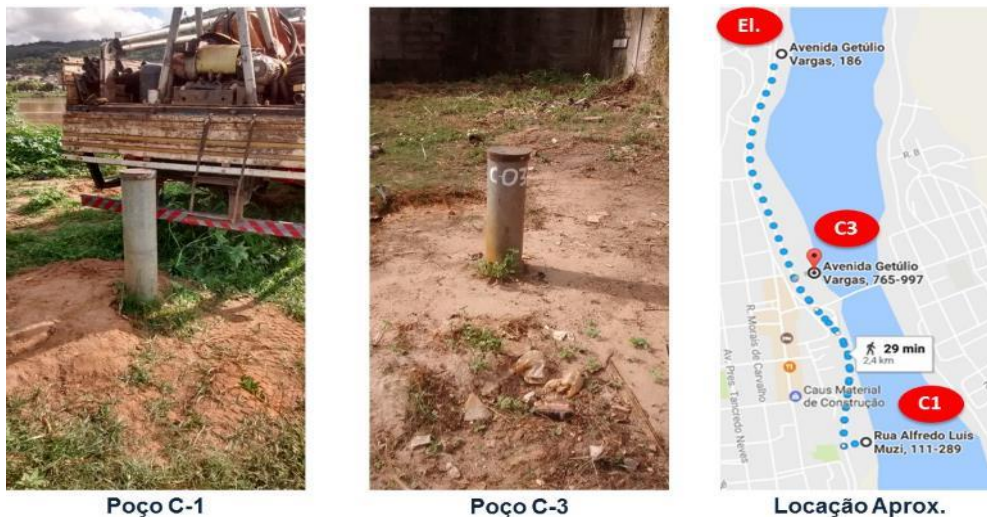
Figura 74 - Imagens dos poços PC 1 com vazão de 18,5 L/s (a esquerda) e PC3 com vazão de 6,8 L/s (central) e, mapa com espacialização dos poços.
