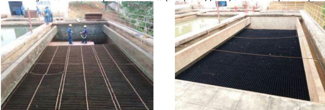
Figura 86 - Troca das placas de amianto (à esquerda) pelos perfis em PVC (à direita).
