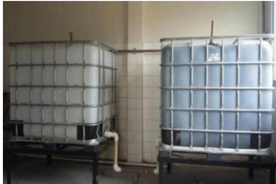
Figura 100 - Instalação de instalação de bombas para dosagem de Tanfloc
