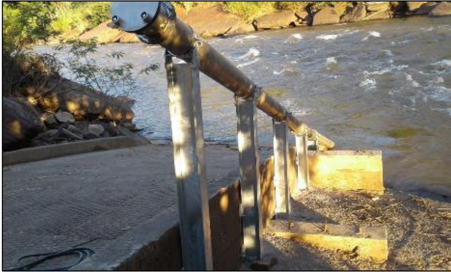
Figura 15 - Estação RDO 02 (rio Doce – jusante UHE Risoleta Neves) em 02/05/2018, após a substituição do pír por conjunto de tubulação - Vista lateral.
