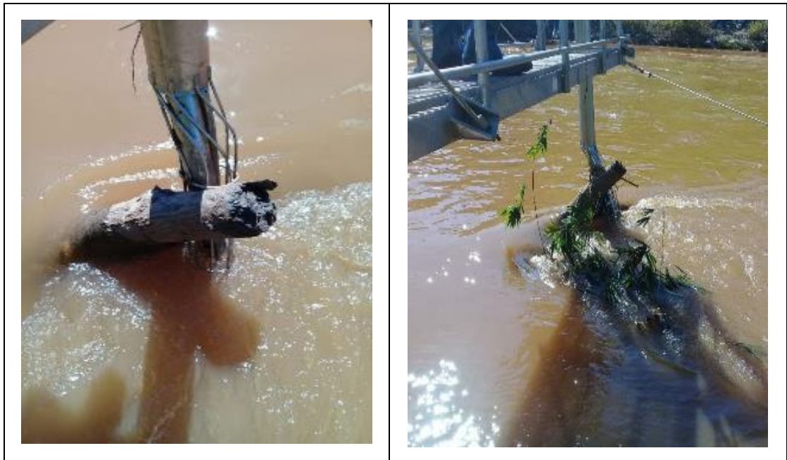
Figura 08 – RCA02 (rio do Carmo - Barra Longa) presença de tronco e identificação do tubo danificado em 27/03/2018.
