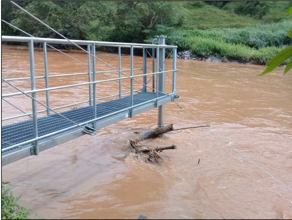
Figura 07 – RCA02 (rio do Carmo - Barra Longa) com tronco de árvore colidido na estrutura do tubo da sonda em 07/03/2018.
