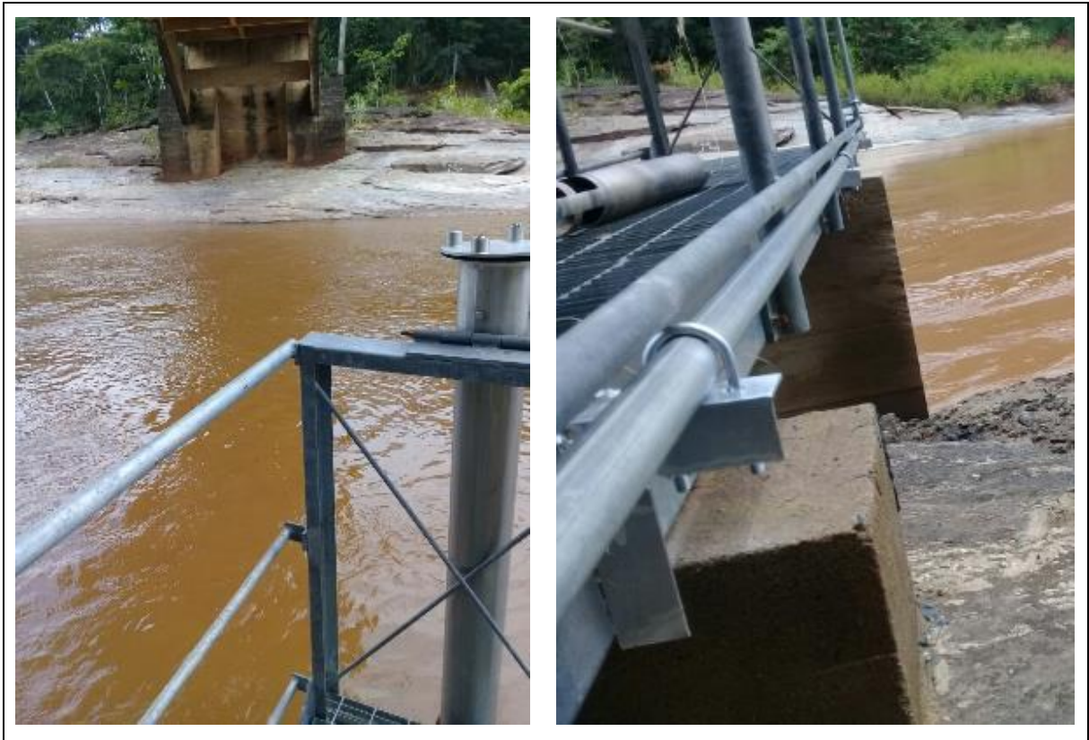
Figura 20 - Píer da RDO 04 (rio Doce – Parque Estadual do Rio Doce) em 25/01/2018, após adequação da estrutura dos cabos reparados.
