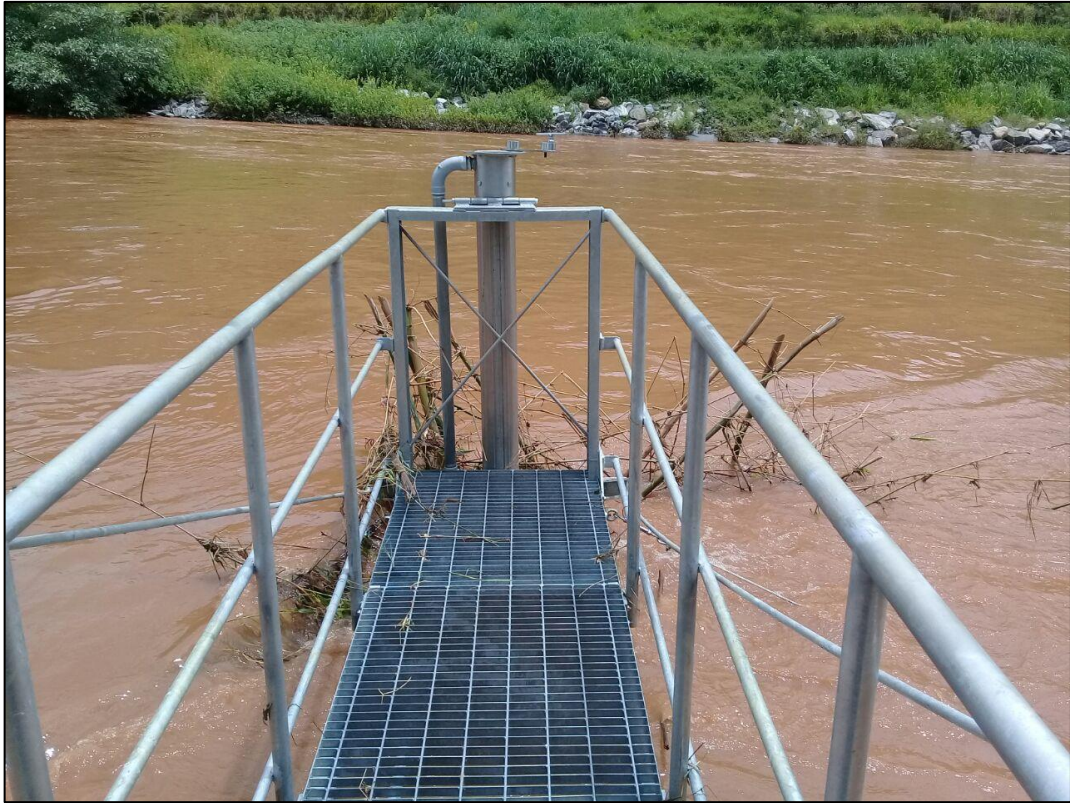
Figura 05 – RCA02 (rio do Carmo - Barra Longa) com elevado nível d'água e acúmulo de material em 07/02/2018.
