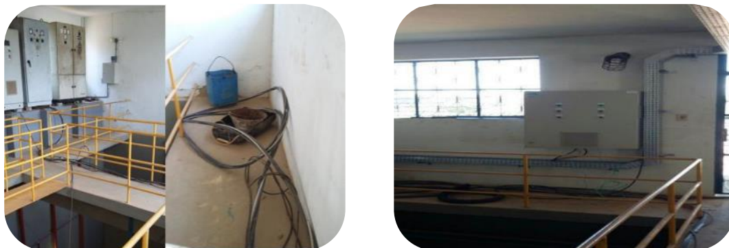
Figura 88 - Novo painel (à esquerda) e eletrocalha (à direita) instalados na ETA 1 de Colatina.
