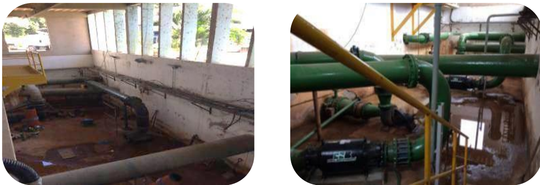
Figura 38 - Cenário antes e depois da ação da instalação das duas novas bombas anfíbias.
