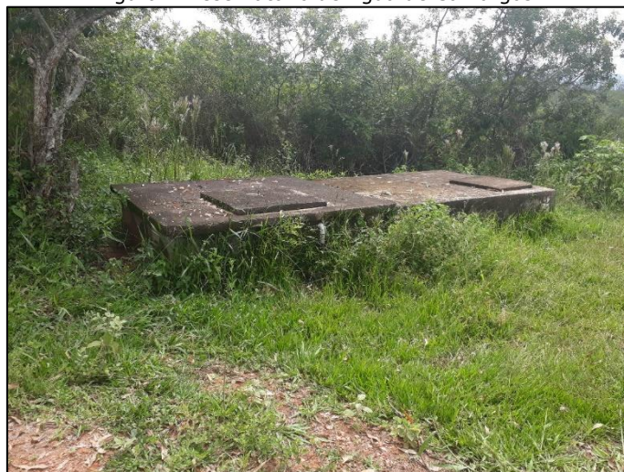
Figura 4: Reservatório de Água de Camargos.
