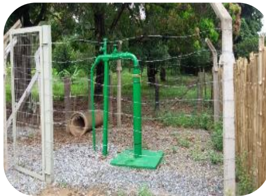
Figura 58 - Poço perfurado na região de São Tomé do Rio Doce.
