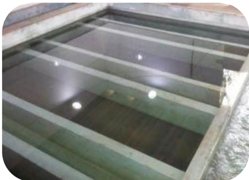
Figura 94 - Substituição do leito filtrante dos filtros “Russos” na ETA II de Colatina.
