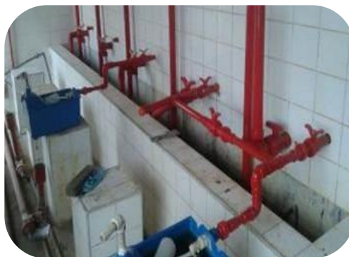
Figura 105 - Reforma das caixas dosadoras dos produtos químicos.
