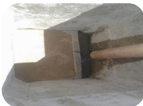
Figura 107 - Processo de substituição dos leitos filtrantes de quatro filtros já existentes.
