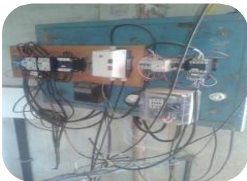
Figura 104 - Substituição do Pannel de Alimentação das Bombas da Captação.
