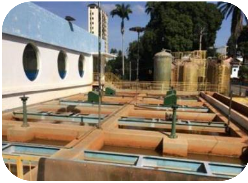
Figura 39: Imagens dos agitadores instalados na ETA Central.
