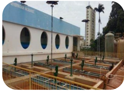
Figura 39: Imagens dos agitadores instalados na ETA Central.
