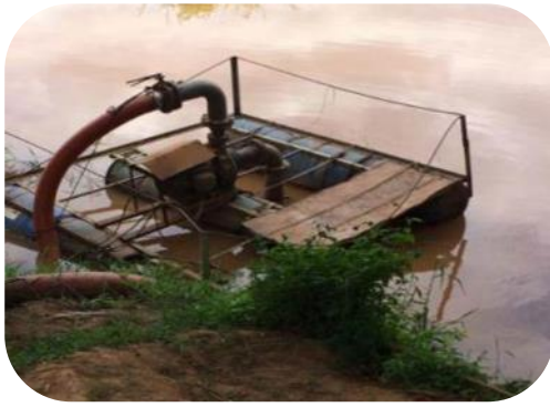
Figura 56 - Imagem do sistema de captação da ETA Santa Rita, antes e depois da substituição dos flutuantes.
