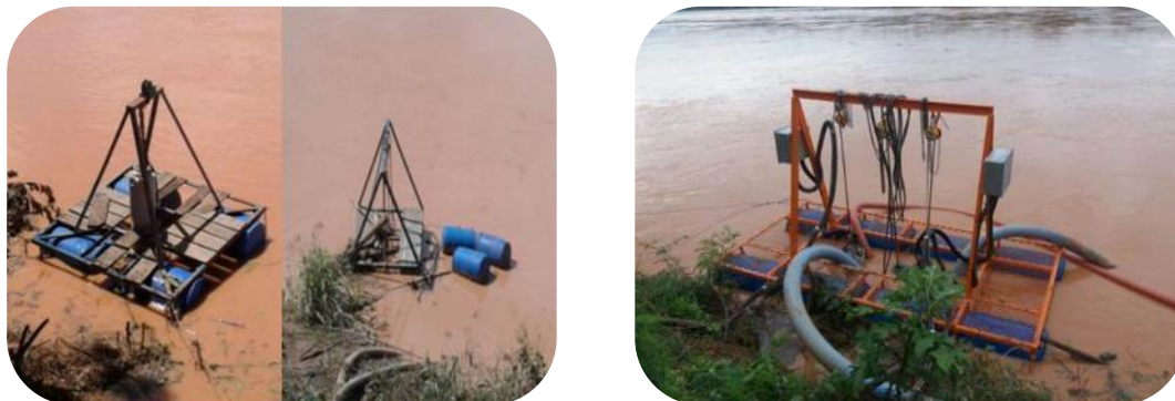
Figura 87 - Substituição de balsa do sistema de captação da ETA I de Colatina.
