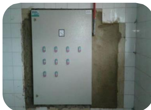
Figura 91 - Substituição do painel de acionamento dos agitadores, na ETA I de Colatina.
