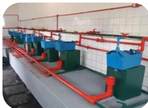
Figura 90 - Instalação de caixas dosadoras de produtos químicos na ETA I de Colatina.
