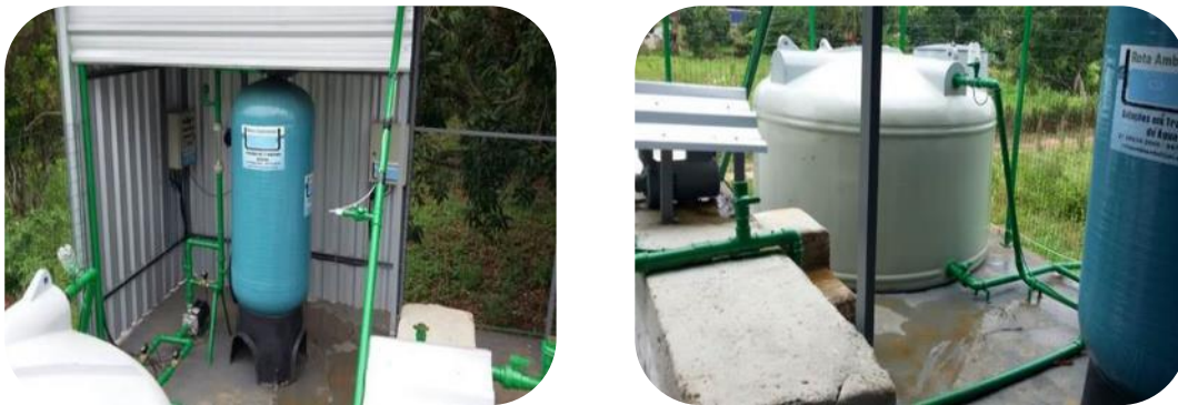
Figura 59 - Imagem do filtro (à esquerda) e do reservatório (à direita) do sistema de tratamento da água do poço do distrito de São Tomé do Rio Doce.
