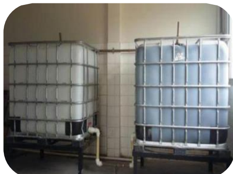
Figura 100 - Instalação de bomba à esquerda e de painel à direita.
