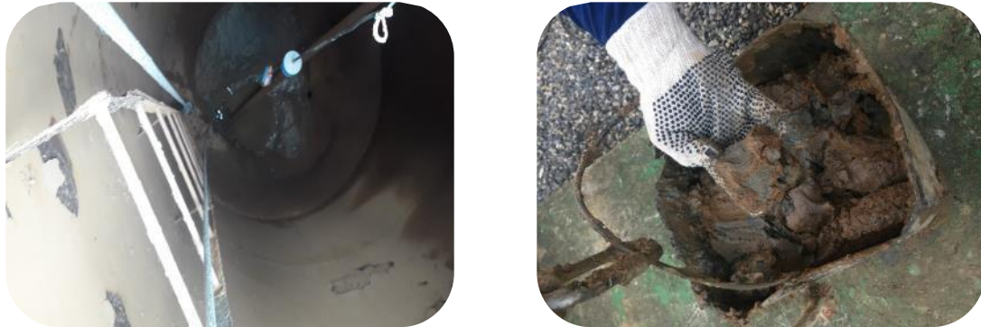
Figura 60 - Interior da torre antes da reforma (à esquerda) e material lodoso retirado no interior do castelo d'água
