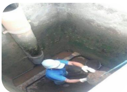
Figura 107 - Processo de substituição dos leitos filtrantes de quatro filtros já existentes.
