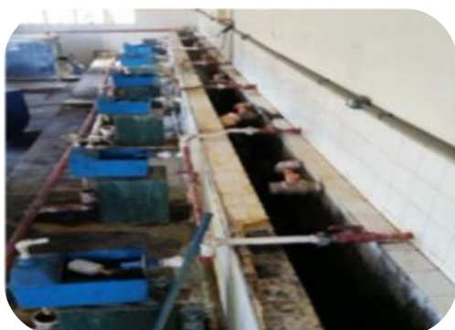
Figura 90 - Instalação de caixas dosadoras de produtos químicos na ETA I de Colatina.
