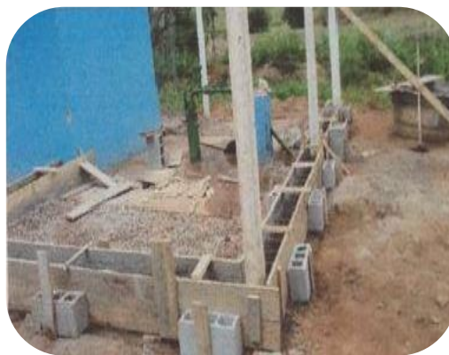
Figura 8: construção do muro no entorno do reservatório em Gesteira
