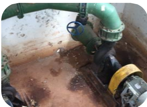
Figura 47 - Cenário antes e depois da instalação de válvula de retenção na bomba de captação.
