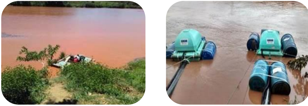
Figura 20 - Substituição da balsa de captação (à esquerda) por dois flutuadores (à direita) no sistema de captação da ETA modular de Cachoeira Escura.
