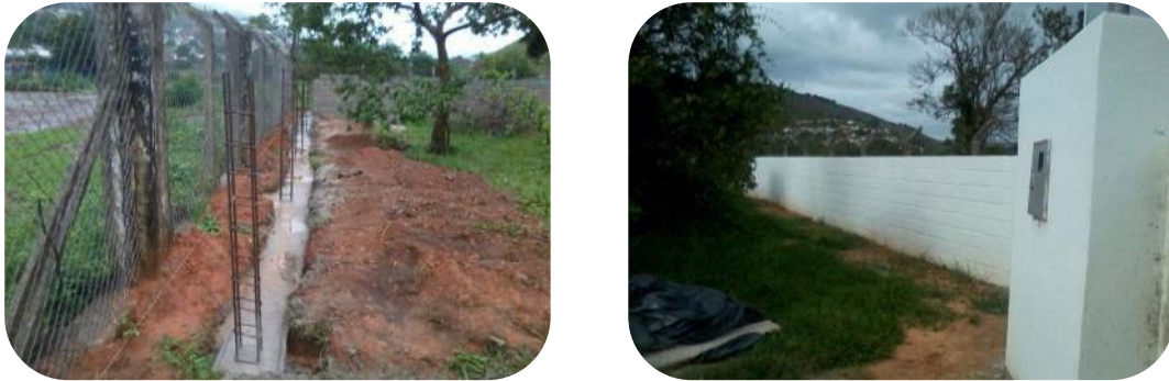
Figura 11 - Antes e depois da construção do muro ao redor da ETA de Barra Longa.
