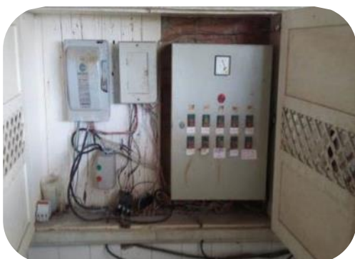
Figura 91 - Substituição do painel de acionamento dos agitadores, na ETA I de Colatina.
