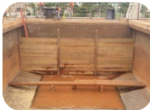
Figura 41 - Cenário de antes e depois da instalação de cortina de madeira na entrada do Decantador 02.
