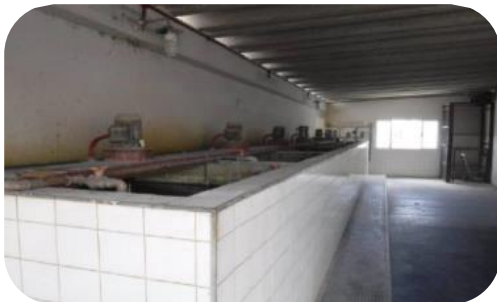
Figura 98: Melhoria dos tanques, que passaram por revestimento de fibra de vidro.
