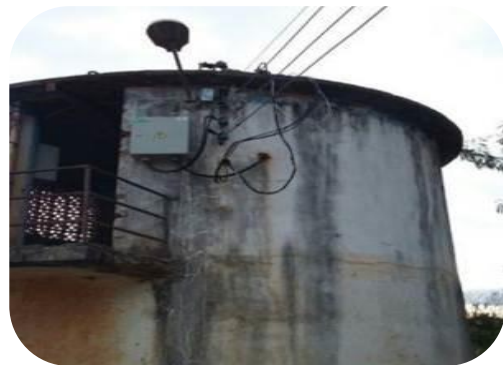
Figura 103 - Instalação de disjuntor de entrada para eliminação do padrão elétrico antigo.
