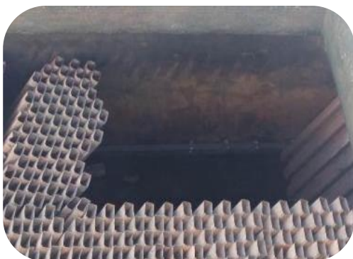
Figura 43 - Mosaico de imagens ilustrando a substituição das colmeias (antes e depois).
