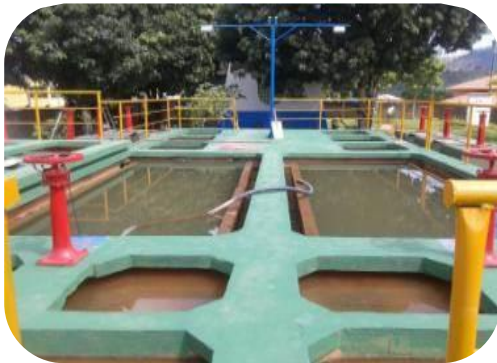
Figura 102 - Melhoria do sistema de decantação, pela instalação de perfis de decantação.
