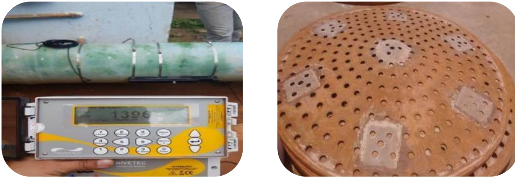
Figura 50 - Sistema de mediação melhorado (à esquerda) e manutenção de anel de floculador (à direita).
