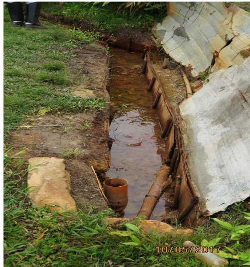
Figura 6: Caixa de areia utilizada após a captação por nascente (à esquerda) e Detalhes de adaptações no sistema de bóias da caixa de areia (à direita)
