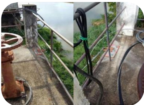
Figura 96 - Novo sistema de ancoragem e alimentação elétrica da Balsa de captação da ETA II.
