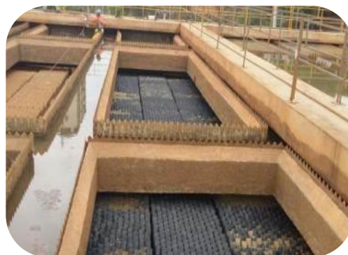
Figura 43 - Mosaico de imagens ilustrando a substituição das colmeias (antes e depois).
