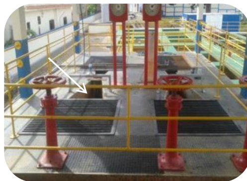
Figura 101 - Corrimão e grade de proteção instalados, ambos evidenciados.
