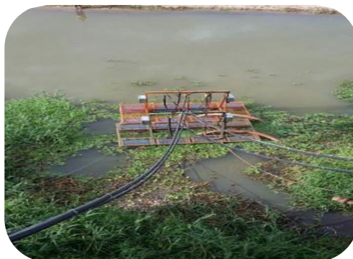
Figura 96 - Novo sistema de ancoragem e alimentação elétrica da Balsa de captação da ETA II.
