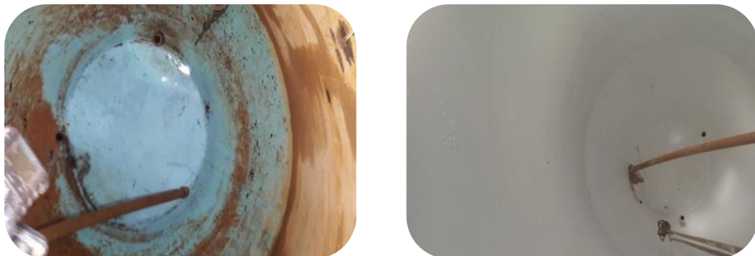
Figura 61 - Jateamento do interior da torre durante a reforma (à esquerda) e resultado da pintura no mesmo interior (à direita)
