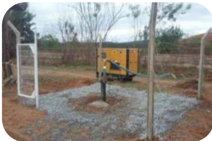
Figura 23 - Poço 03 em Belo Oriente, considerado para abastecimento emergencial.
