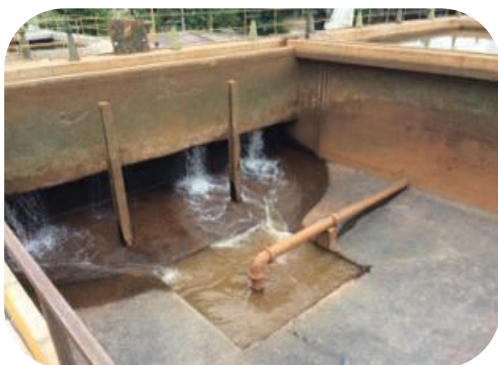
Figura 41 - Cenário de antes e depois da instalação de cortina de madeira na entrada do Decantador 02.
