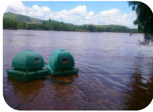
Figura 56 - Imagem do sistema de captação da ETA Santa Rita, antes e depois da substituição dos flutuantes.
