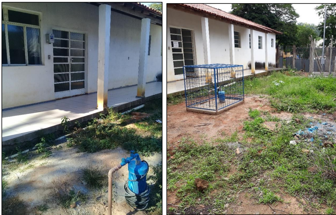
Figura 14 - Perfuração de poço tubular em Ponte do Gama/Camargos/Mariana/MG (captação alternativa), posteriormente com seu entorno protegido
