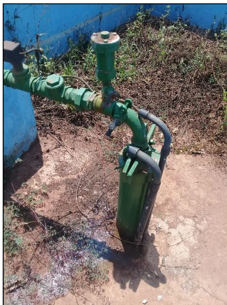
Figura 12 - Poço Beira Rio, utilizado como fonte principal de abastecimento de Gesteira.
