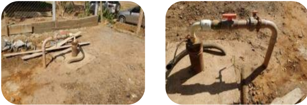
Figura 22 - Poço já perfurado em Belo Oriente, interligado à Estação de Tratamento de Água de Cachoeira Escura.
