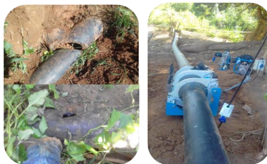
Figura 109 - Reparo e interligação da adutora dos poços; adutora antes do reparo (à esquerda) e após o reparo (à direita)
