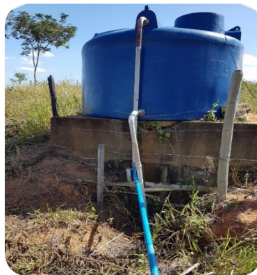
Figura 11 - Reservatório instalado em substituição à cisterna com nova tubulação.
