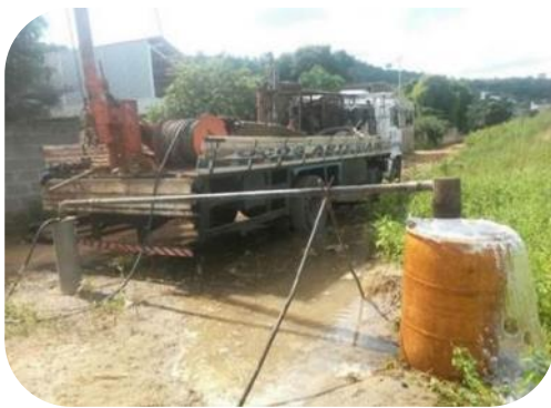
Figura 72 - Imagens de recuperação do Poço C3 em Resplendor.
