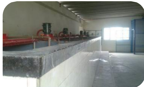
Figura 98: Melhoria dos tanques, que passaram por revestimento de fibra de vidro.
