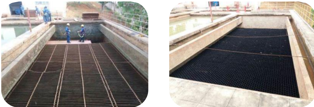
Figura 86 - Troca das placas de amianto (à esquerda) pelos perfis em PVC (à direita).
