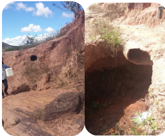
Figura 70 - Adutora do Córrego Santaninha da COPASA.
