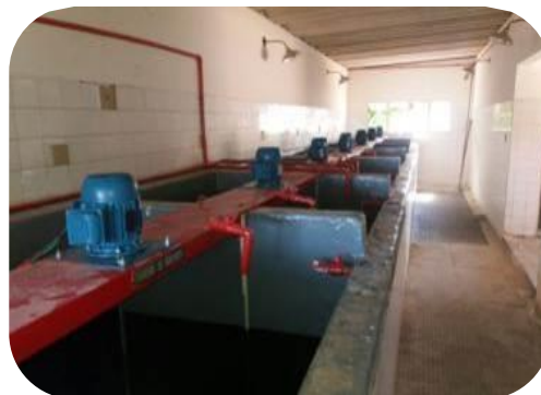
Figura 89 - Situação de antes e depois da troca dos agitadores dos tanques da ETAI de Colatina.
