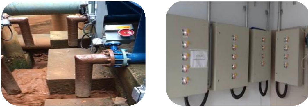
Figura 52 - Válvulas com acionamento automático à esquerda e painel de controle instalado à direita.
