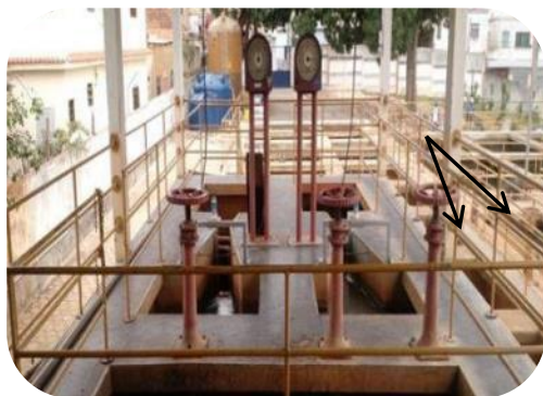
Figura 101 - Corrimão e grade de proteção instalados, ambos evidenciados.
