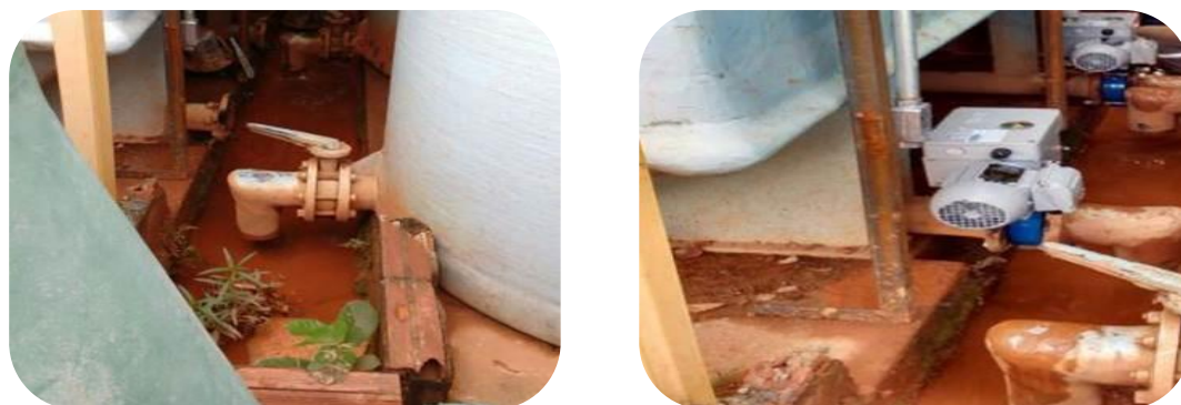
Figura 55: Imagem dos drenos dos decantadores da ETA Santa Rita, antes e depois da instalação das válvulas.
