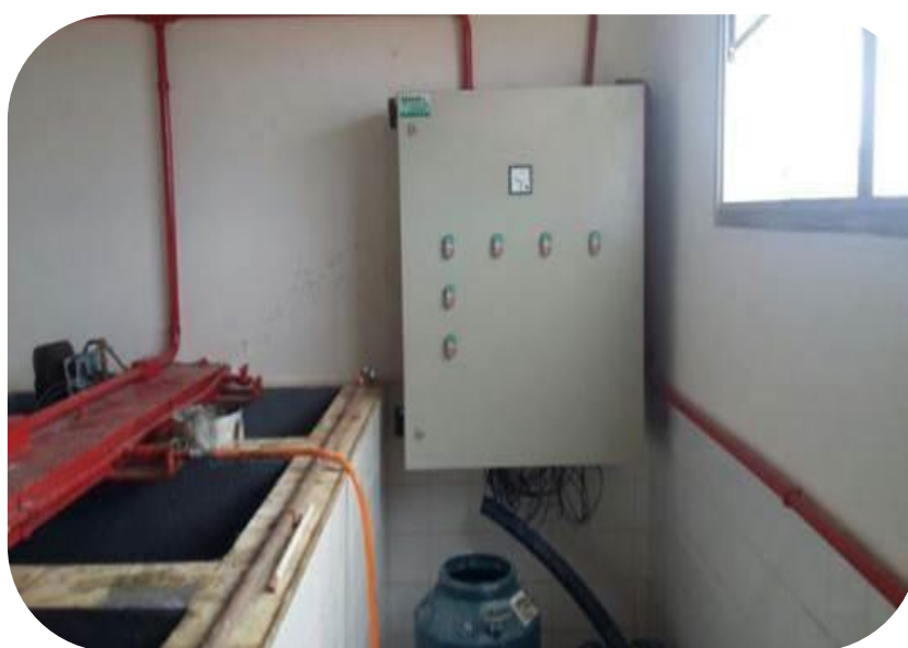
Figura 106 - Montagem do painel de comando dos agitadores dos tanques de produto químicos.
