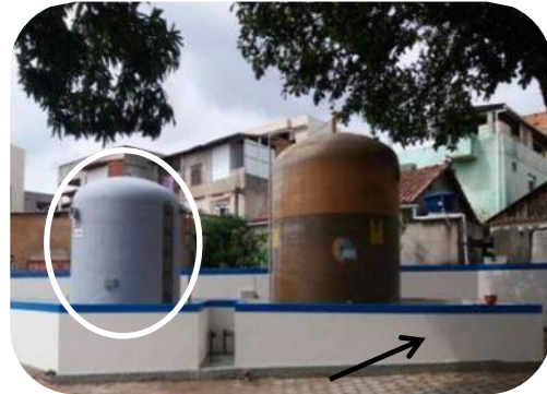
Figura 97 - Construção de caixa de contenção para reagentes e tanque para Tanfloc, evidenciados à direita, cenários de antes (à esquerda) e depois (à direita).
