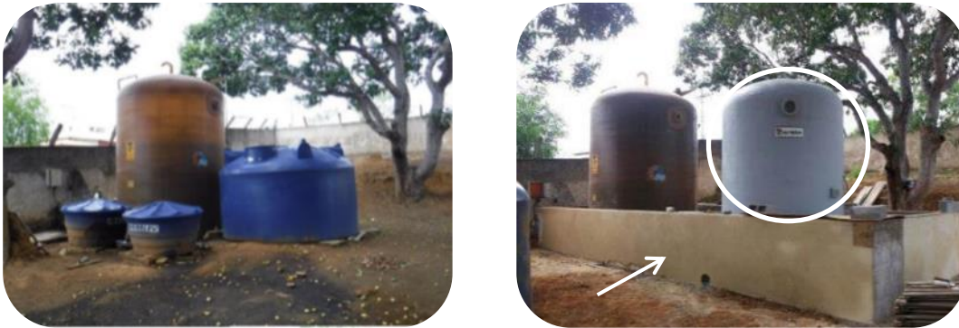
Figura 92 - Instalação de Tanque de Tanfloc de 15.000l (à direita) e Caixa de Contenção para Tanfloc e Sulfato de Alumínio (ambos evidenciados), em cenário de antes (à esquerda) e depois (à direita).
