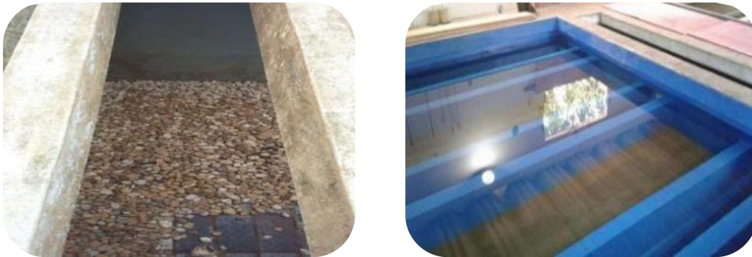
Figura 85 - Substituição do leito filtrante (exemplo à esquerda) por novos (exemplo à direita).
