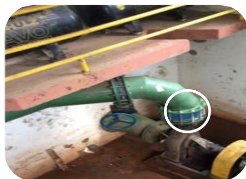
Figura 47 - Cenário antes e depois da instalação de válvula de retenção na bomba de captação.
