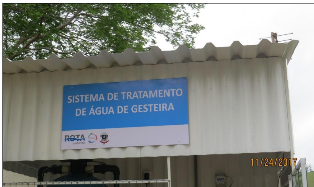
Figura 17 - Placa com a identificação do sistema e do Distrito.
