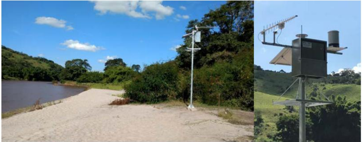
Poste e painel de monitoramento
