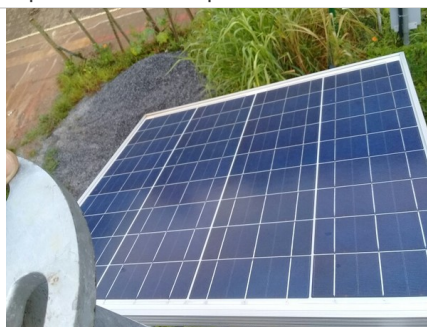
Foto do painel solar - Antes da limpeza
