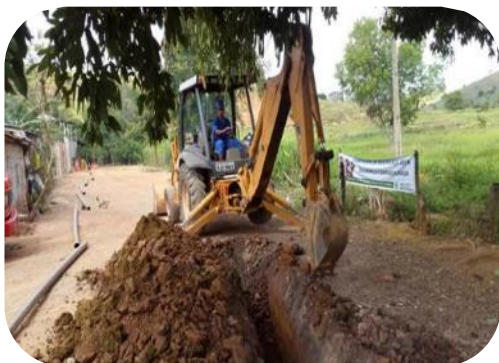
Figura 76: Evidências da interligação hidráulica do poço tubular PN01 à adutora.
