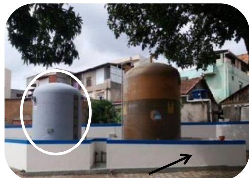
Figura 51: Construção de caixa de contenção para reagentes e tanque para Tanfloc, evidenciados à direita, cenários de antes (à esquerda) e depois (à direita).
