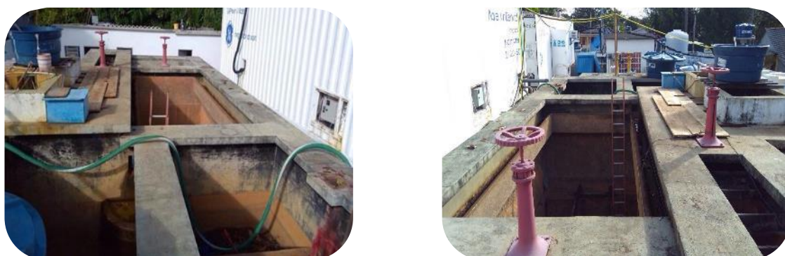
Figura 66: Instalação de caixas d'água na ETA de Regência.
