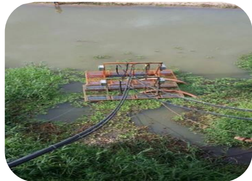
Figura 50: Novo sistema de ancoragem e alimentação elétrica da Balsa de captação da ETA II.
