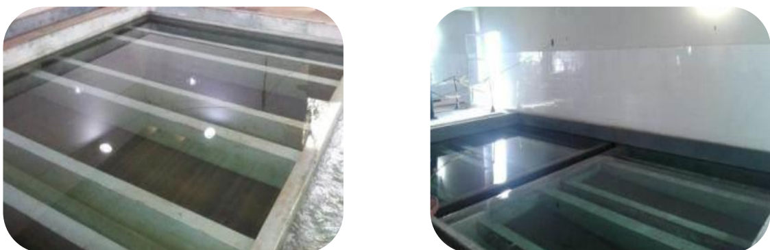
Figura 48: Substituição do leito filtrante dos filtros “Russos” na ETA II de Colatina.
