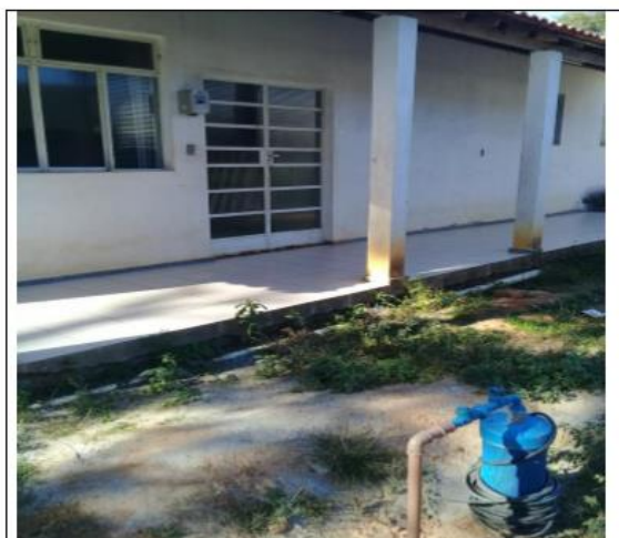
Figura 3 - Poço perfurado na área do Posto de Saúde pela FR em janeiro/2017.
