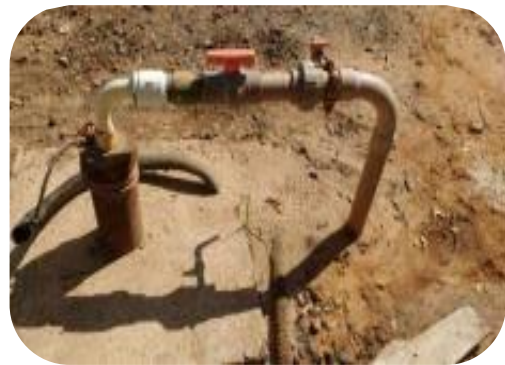
Figura 72: Poço já perfurado em Belo Oriente, interligado à Estação de Tratamento de Água de Cachoeira Escura.
