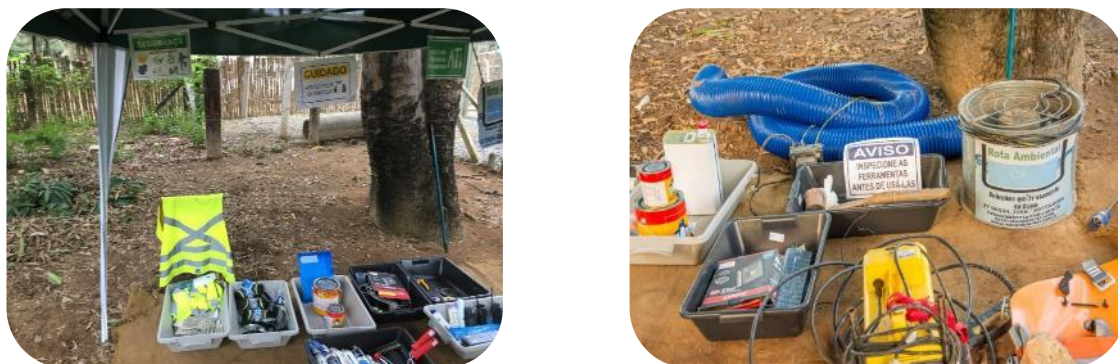
Figura 32: Exemplos de EPIs (à esquerda) e exemplos de ferramentas (à direita), todos utilizados nos serviços envolvidos na torre de armazenamento de água.
