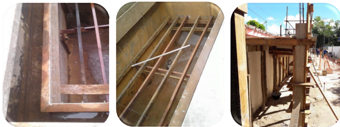
Figura 67: Imagens das reformas realizadas na ETA de Regência
