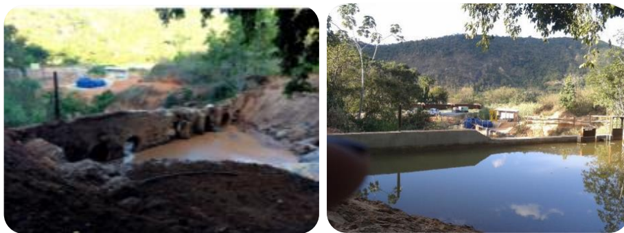
Figura 89: Avanço das obras da barragem no córrego Barroso.
