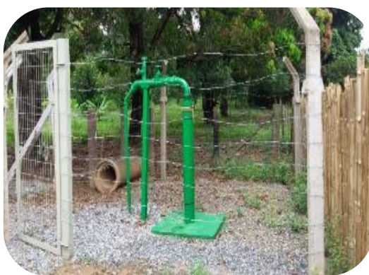
Figura 82: Poço perfurado na região de São Tomé do Rio Doce.
