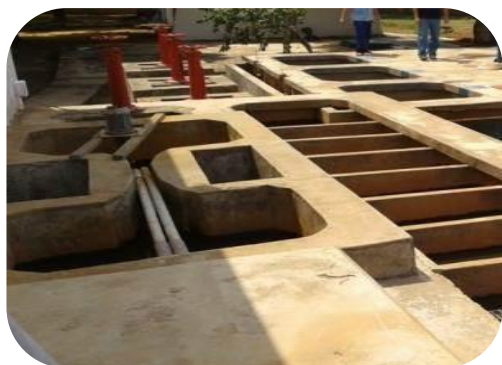
Figura 62: Reforma da calha Parshall , à esquerda, e guarda corpos à direita.
