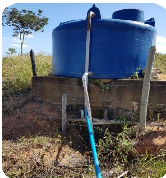
Figura 103: Reservatório instalado em substituição à cisterna com nova tubulação.
