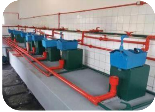
Figura 44: Instalação de caixas dosadoras de produtos químicos na ETA I de Colatina.
