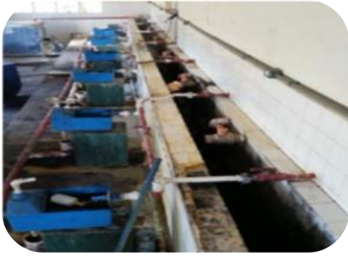
Figura 44: Instalação de caixas dosadoras de produtos químicos na ETA I de Colatina.
