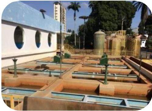
Figura 11: Imagens dos agitadores instalados na ETA Central.
