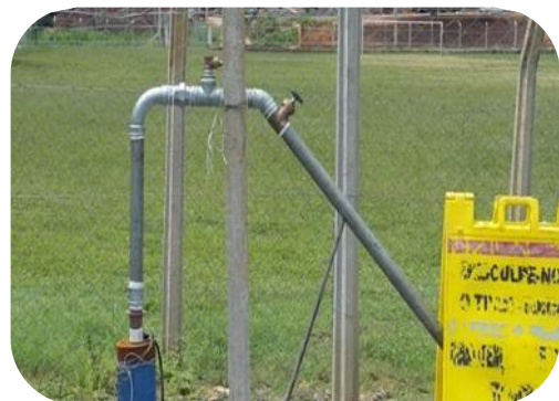
Figura 76: Evidências da interligação hidráulica do poço tubular PN01 à adutora.
