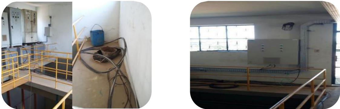
Figura 42: Novo painel (à esquerda) e eletrocalha (à direita) instalados na ETA 1 de Colatina.
