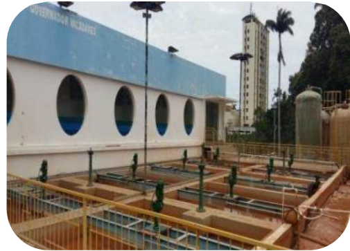
Figura 11: Imagens dos agitadores instalados na ETA Central.
