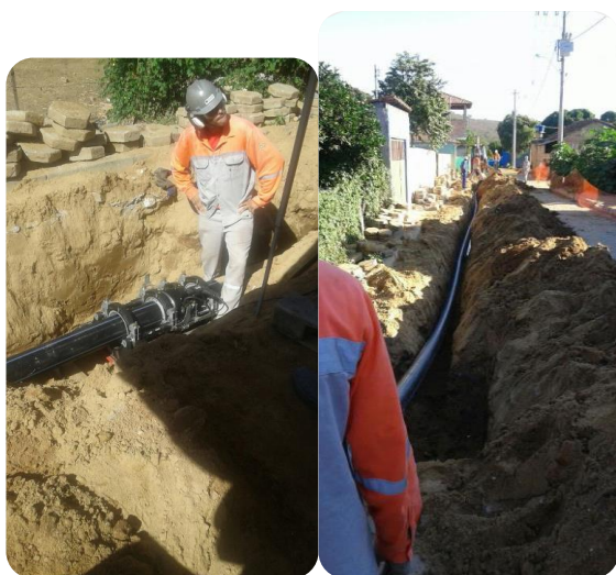
Figura 36. Imagens durante a construção da adutora de água tratada (à esquerda) e após a conclusão (à direita), que interligará a nova ETA de Galileia ao reservatório do SAAE.
