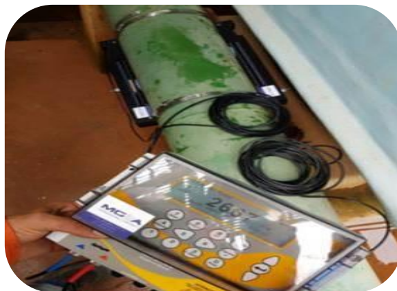
Figura 29: Instalação de medidor de vazão.
