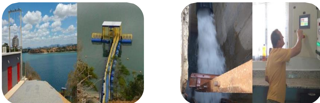
Figura 105: Sistema de Bombeamento e Subestação (esquerda) e Chegada de água no SAAE e painel de operação Remota da adutora de Lagoa Nova (direita).
