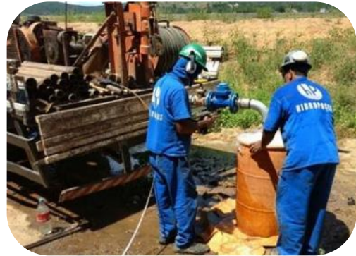
Figura 92: Imagens de recuperação do Poço C3 em Resplendor.
