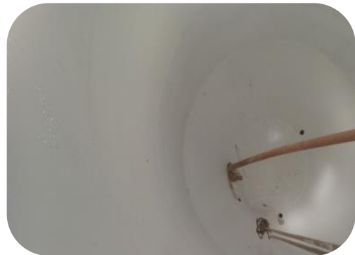
Figura 34: Jateamento do interior da torre durante a reforma (à esquerda) e resultado da pintura no mesmo interior (à direita)
