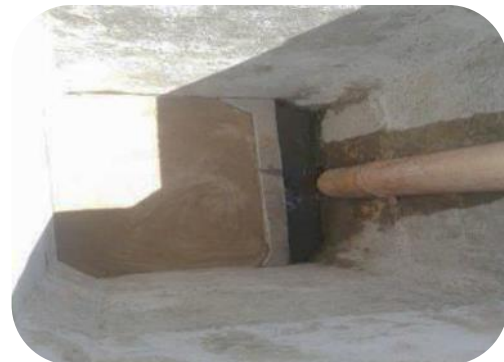
Figura 61: Processo de substituição dos leitos filtrantes de quatro filtros já existentes.
