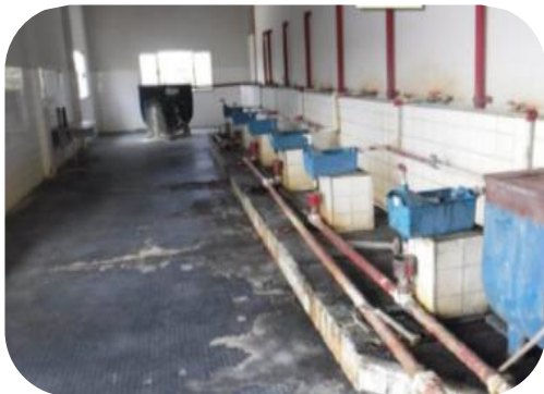
Figura 53: Melhorias nas caixas dosadoras.
