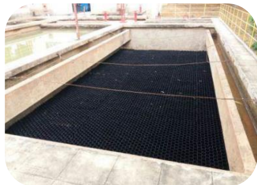
Figura 40: Troca das placas de amianto (à esquerda) pelos perfis em PVC (à direita).
