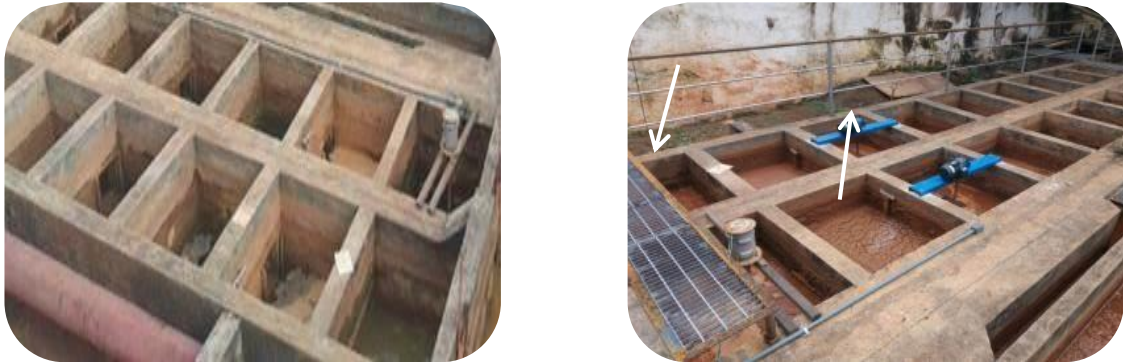
Figura 47: Implantação de acesso seguro às áreas dos floculadores e decantadores, evidenciado.
