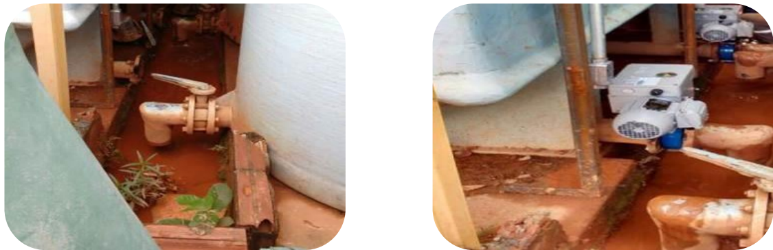
Figura 27: Imagem dos drenos dos decantadores da ETA Santa Rita, antes e depois da instalação das válvulas.
