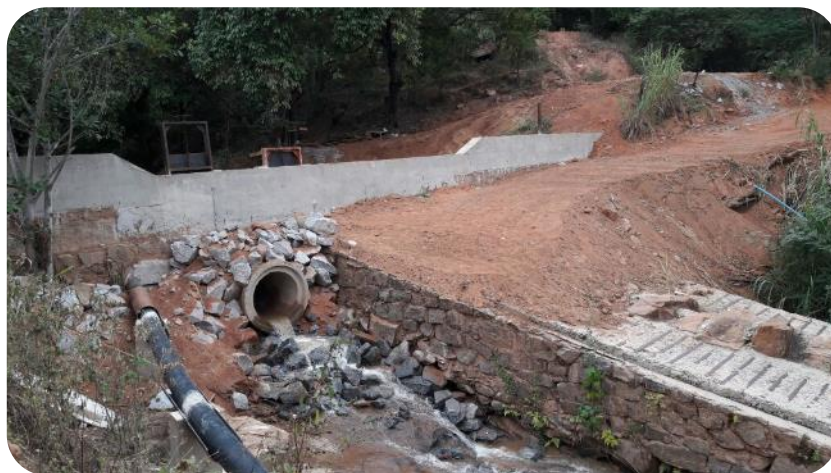
Figura 91: Barragem no córrego Barroso, após obras de reforço da barragem.
