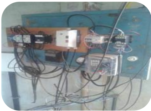
Figura 58: Substituição do Pannel de Alimentação das Bombas da Captação.
