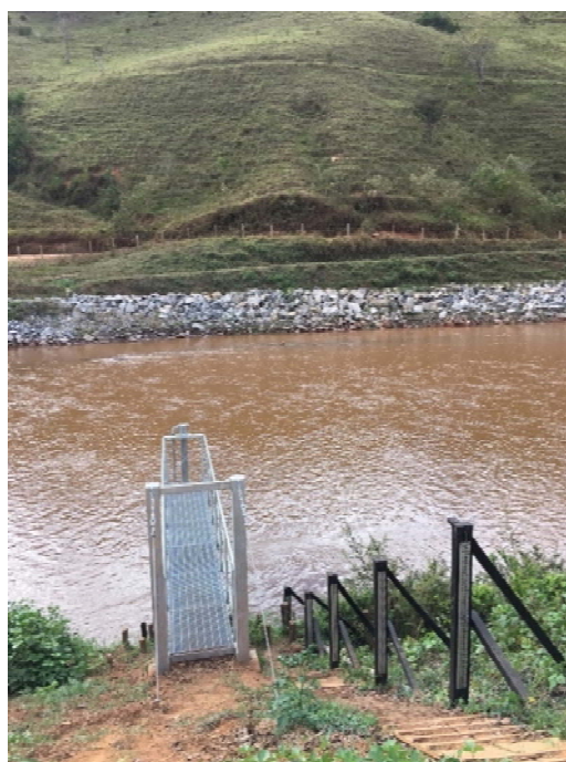
Figura 3.6: Foto da plataforma da sonda multiparâmetro no Rio do Carmo - Estação Automática em Barra Longa RCA02
