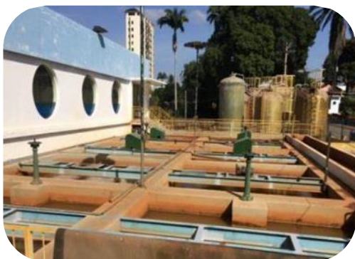
Figura 11: Imagens dos agitadores instalados na ETA Central.
