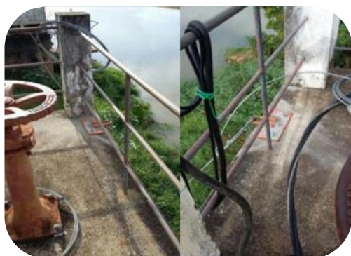
Figura 50: Novo sistema de ancoragem e alimentação elétrica da Balsa de captação da ETA II.
