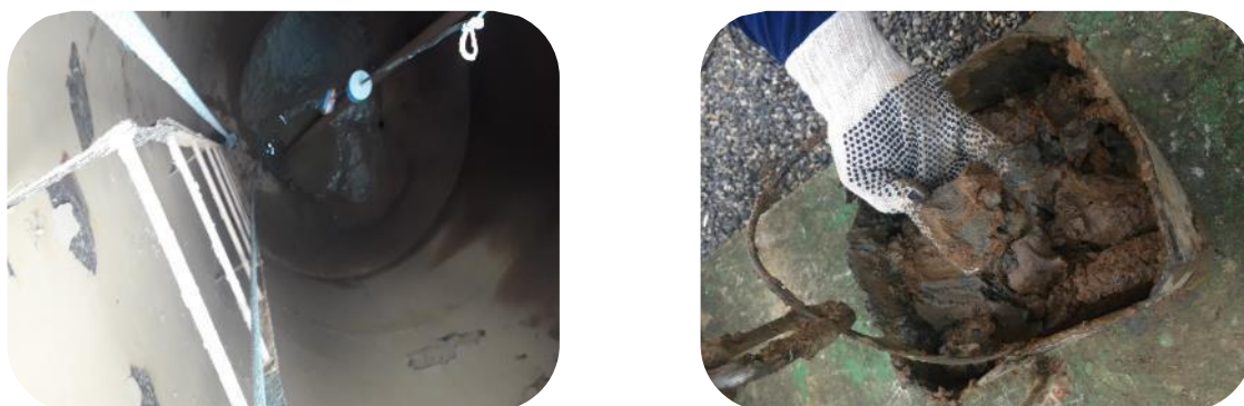
Figura 33: Interior da torre antes da reforma (à esquerda) e material lodoso retirado no interior do castelo d'água
