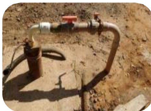
Figura 75: Poço já perfurado em Belo Oriente, interligado à Estação de Tratamento de Água de Cachoeira Escura.
