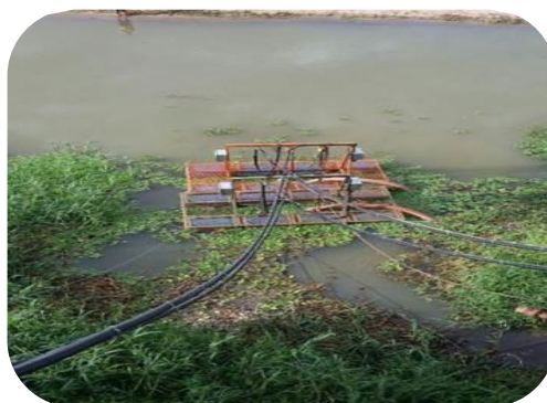
Figura 50: Novo sistema de ancoragem e alimentação elétrica da Balsa de captação da ETA II.
