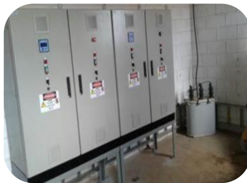
Figura 5: Evidência de melhoria do sistema elétrico, após a instalação de painéis com inversores de frequência.
