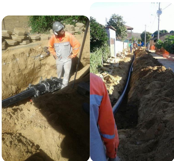
Figura 36. Imagens durante a construção da adutora de água tratada (à esquerda) e após a conclusão (à direita), que interligará a nova ETA de Galiléia ao reservatório do SAAE.
