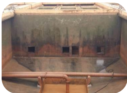
Figura 12: Melhoria da decantação pela instalação de calhas de overflow , cenário de antes e depois, respectivamente à esquerda e à direita.
