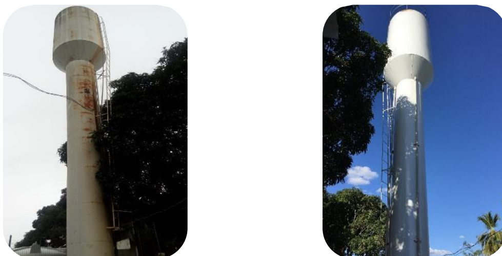
Figura 35: Torre antes da pintura (à esquerda) e depois da pintura (à direita)
