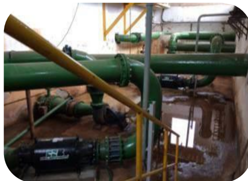
Figura 10: Cenário antes e depois da ação da instalação das duas novas bombas anfíbias.
