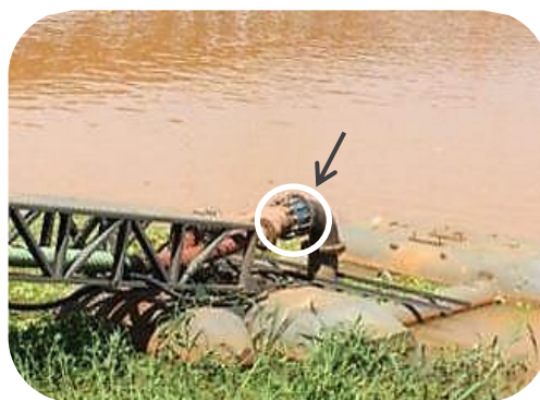
Figura 18: Cenário de antes e depois, evidenciando a instalação de válvula de retenção.
