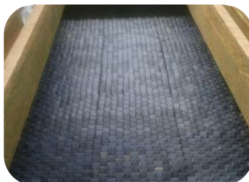
Figura 56: Melhoria do sistema de decantação, pela instalação de perfis de decantação.
