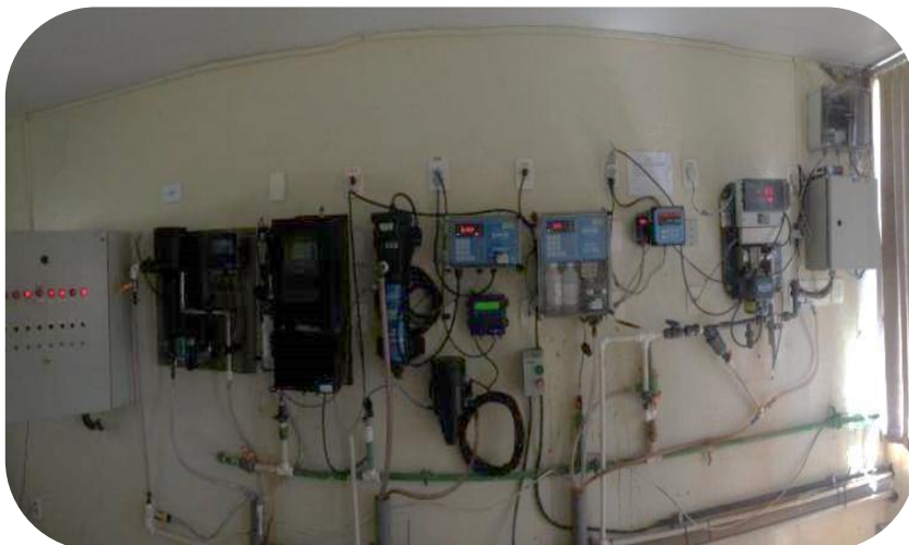
Figura 17: Equipamentos de medição da ETA Central que foram calibrados em novembro de 2016.
