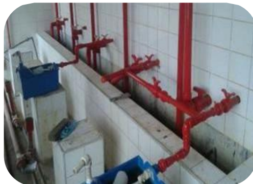
Figura 59: Reforma das caixas dosadoras dos produtos químicos.
