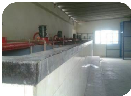
Figura 52: Melhoria dos tanques, que passaram por revestimento de fibra de vidro.
