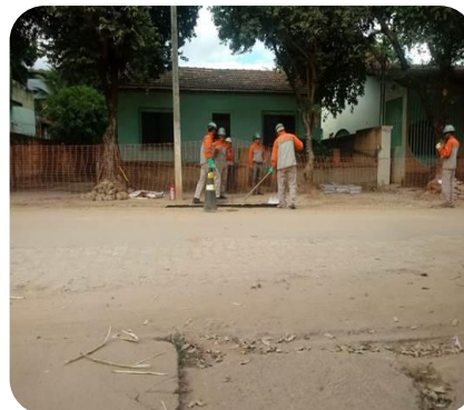
Figura 36. Imagens durante a construção da adutora de água tratada (à esquerda) e após a conclusão (à direita), que interligará a nova ETA de Galiléia ao reservatório do SAAE.
