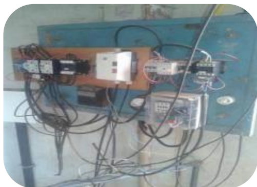
Figura 58: Substituição do Painel de Alimentação das Bombas da Captação.
