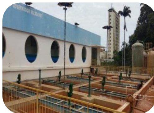
Figura 11: Imagens dos agitadores instalados na ETA Central.
