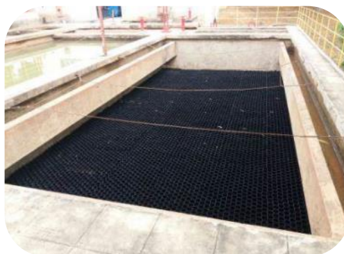
Figura 40: Troca das placas de amianto (à esquerda) pelos perfis em PVC (à direita).
