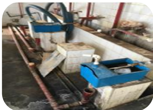
Figura 59: Reforma das caixas dosadoras dos produtos químicos.
