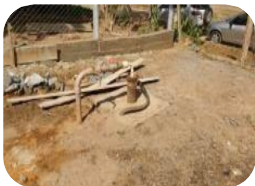
Figura 75: Poço já perfurado em Belo Oriente, interligado à Estação de Tratamento de Água de Cachoeira Escura.
