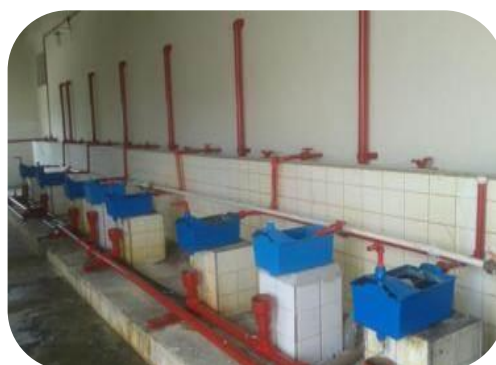
Figura 53: Melhorias nas caixas dosadoras.
