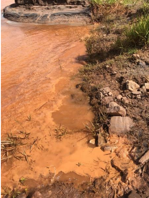
Material inconsolidado presente na Barragem Nova Santarém
