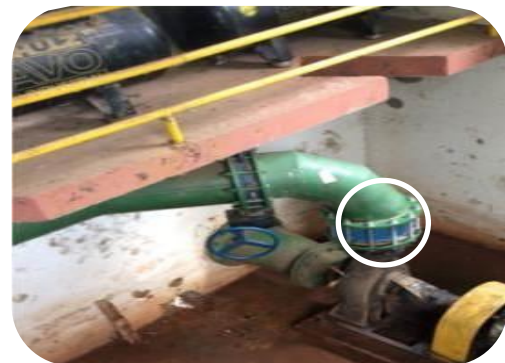
Figura 19: Cenário antes e depois da instalação de válvula de retenção na bomba de captação.
