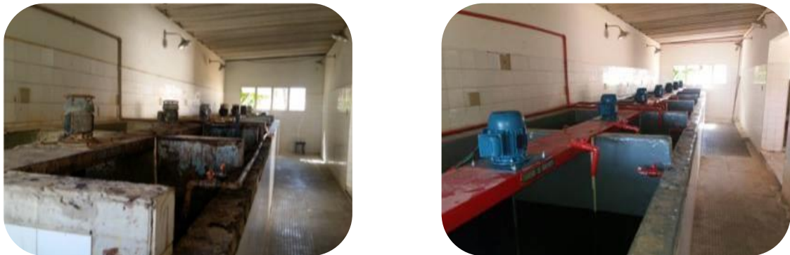
Figura 43: Situação de antes e depois da troca dos agitadores dos tanques da ETAI de Colatina.
