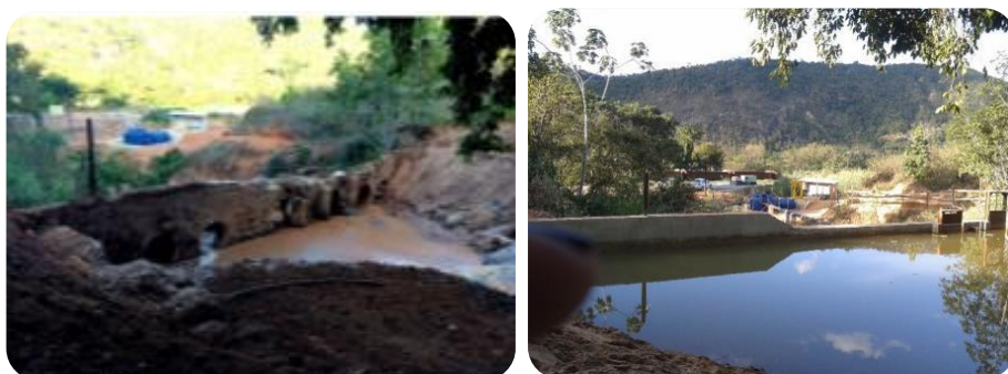
Figura 92: Avanço das obras da barragem no córrego Barroso.
