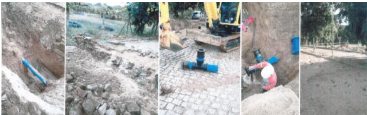
Figura 101: Poço de Aimorés, com vazão aproximada de 8,57 L/s, interligado na adutora de captação do Rio Doce.
