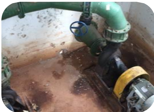
Figura 19: Cenário antes e depois da instalação de válvula de retenção na bomba de captação.
