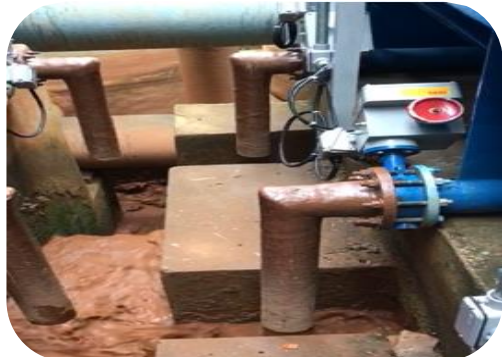
Figura 24: Válvulas com acionamento automático à esquerda e painel de controle instalado à direita.
