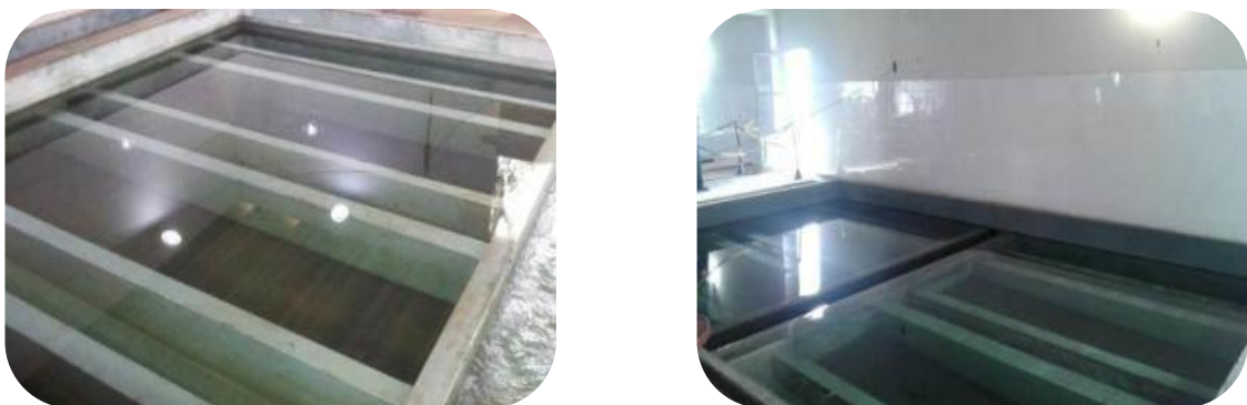
Figura 48: Substituição do leito filtrante dos filtros “Russos” na ETA II de Colatina.
