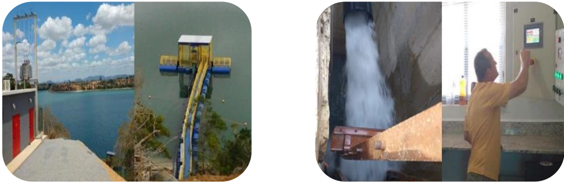
Figura 108: Sistema de Bombeamento e Subestação (esquerda) e Chegada de água no SAAE e painel de operação Remota da adutora de Lagoa Nova (direita).
