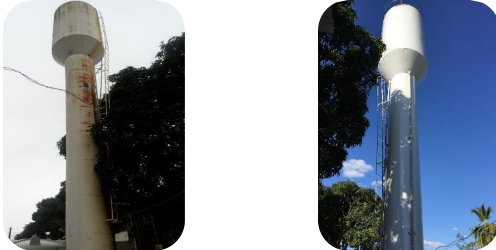
Figura 35: Torre antes da pintura (à esquerda) e depois da pintura (à direita)
