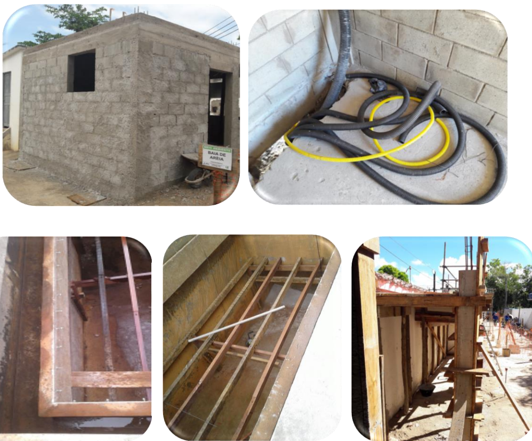
Figura 67: Imagens das reformas realizadas na ETA de Regência
