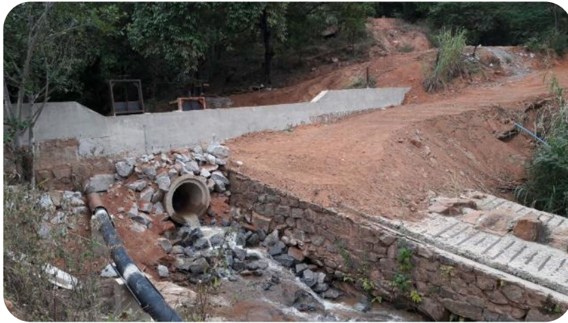
Figura 94: Barragem no córrego Barroso, após obras de reforço da barragem.
