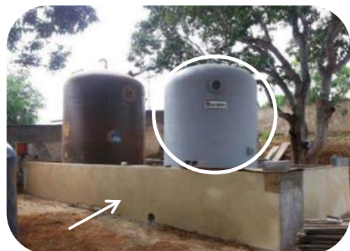
Figura 46: Instalação de Tanque de Tanfloc de 15.000l (à direita) e Caixa de Contenção para Tanfloc e Sulfato de Alumínio (ambos evidenciados), em cenário de antes (à esquerda) e depois (à direita).
