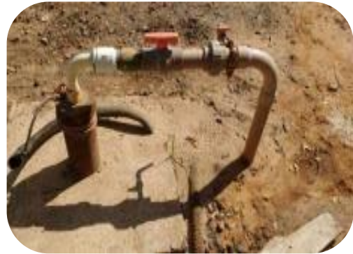
Figura 75: Poço já perfurado em Belo Oriente, interligado à Estação de Tratamento de Água de Cachoeira Escura.
