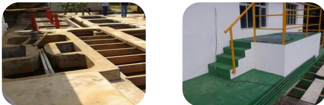
Figura 62: Reforma da calha Parshall , à esquerda, e guarda corpos à direita.
