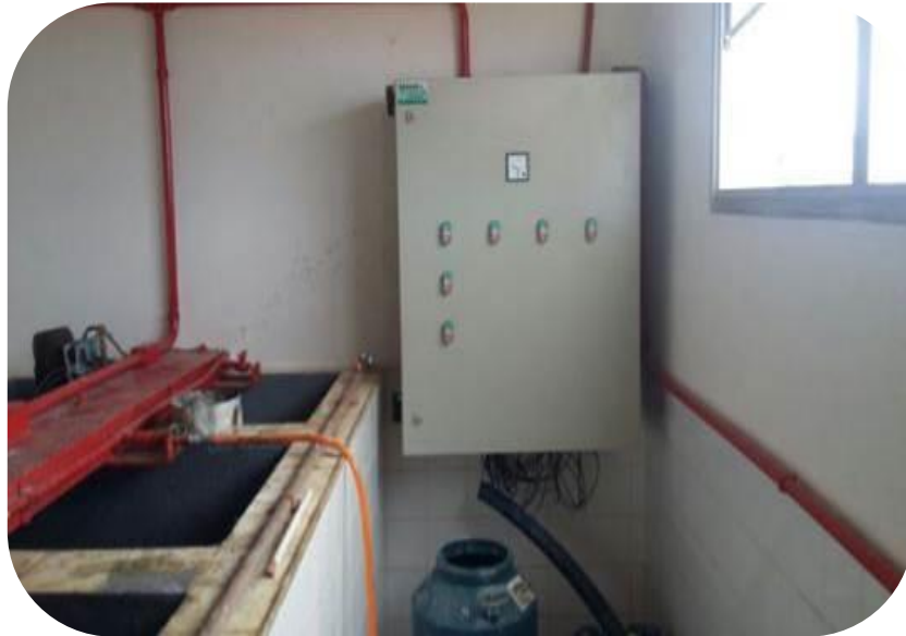
Figura 60: Montagem do painel de comando dos agitadores dos tanques de produto químicos.
