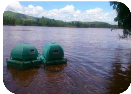
Figura 28: Imagem do sistema de captação da ETA Santa Rita, antes e depois da substituição dos flutuantes.
