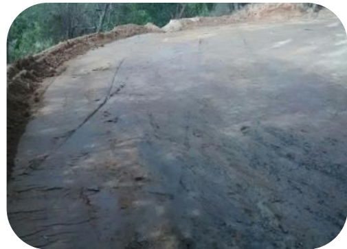
Figura 37: Lançamento de solo brita (à esquerda) e compactação da via de acesso (à direita)
