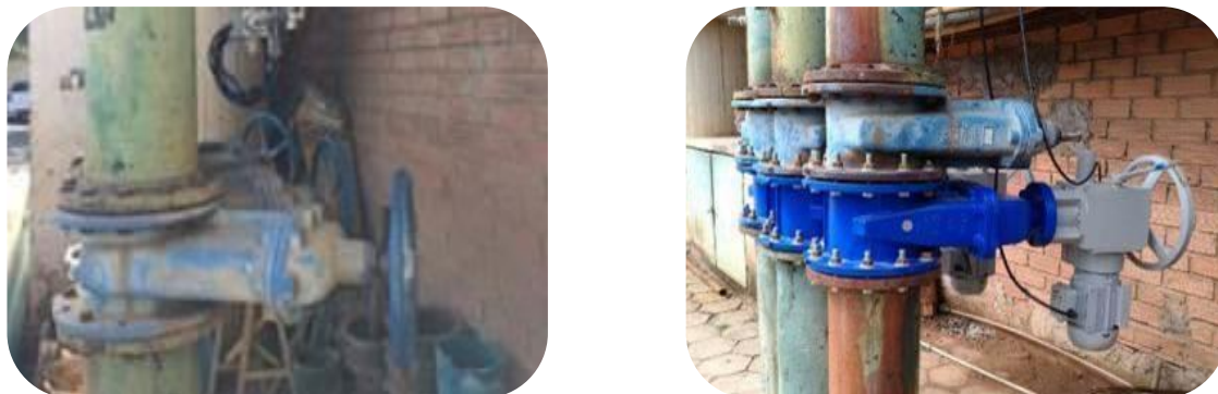
Figura 16: Evidência da instalação de válvulas automáticas, situação de antes e depois.
