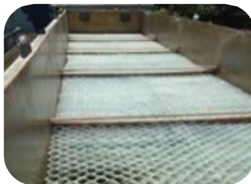
Figura 23: Pintura (à esquerda) e substituição de colmeias (à direita) na ETA Vila Isa.
