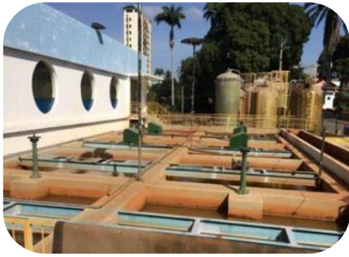
Figura 11: Imagens dos agitadores instalados na ETA Central.
