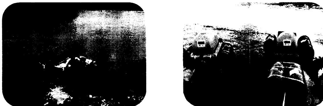
Figura 6: Substituição da balsa de captação (à esquerda) por dois flutuadores (à direita) no sistema de captação da ETA modular de Cachoeira Escura.
