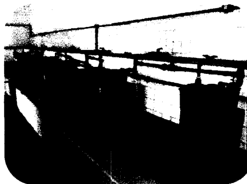
Figura 38: Instalação de caixas dosadoras de produtos químicos na ETA I de Colatina.
