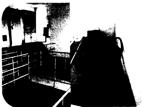
Figura 36: Novo painel (à esquerda) e eletrocalha (à direita) instalados na ETA 1 de Colatina.
