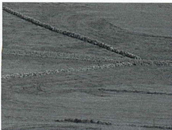
Foto 5.68 – Drenos de lixiviados
