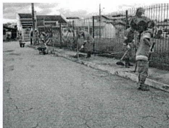
Foto 5.58 – Serviços de limpeza de sarjetas
