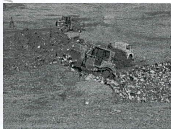
Foto 5.67 – Compactação dos resíduos
