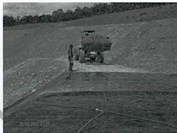
Foto 5.65 – Camada de proteção da geomembrana
