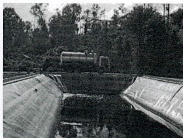
Foto 5.69 – Tanque de armazenamento de lixiviados
