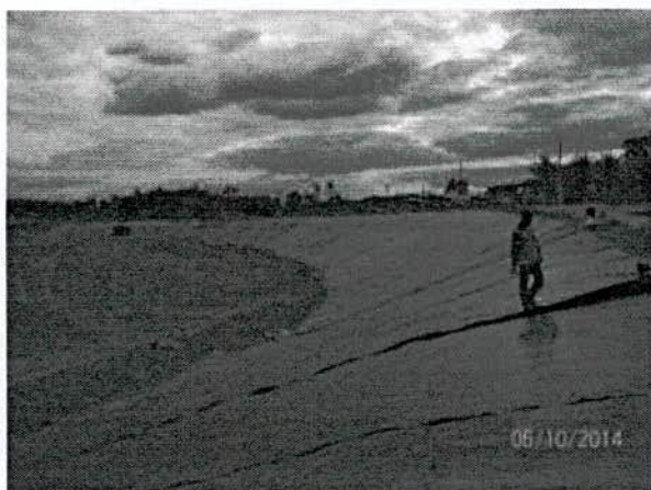
Foto 5.64 – Impermeabilização do solo com PEAD
