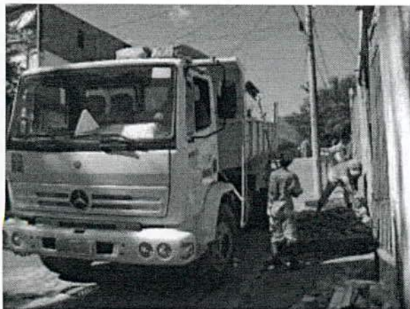
Foto 5.89 – Remoção manual de inertes
