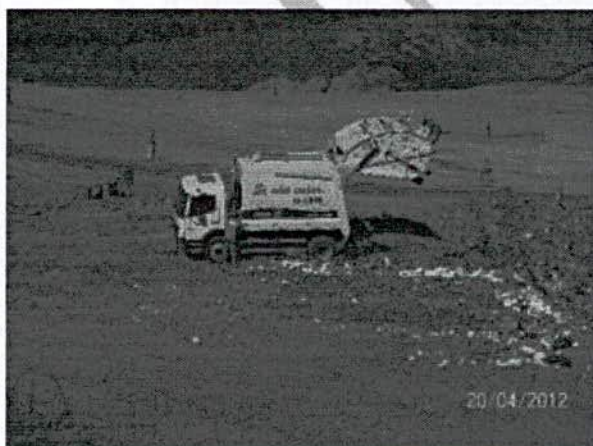
Foto 5.66 – Descarga dos resíduos na frente de operação
