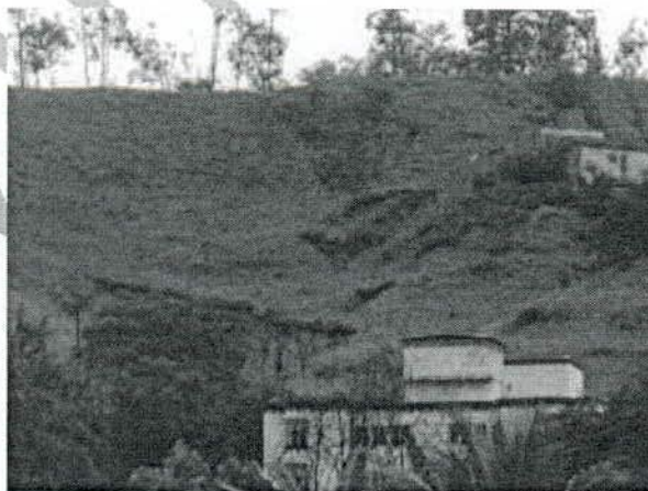
Foto 5.99 – Erosão próxima a casas (Bairro Vagalume)
