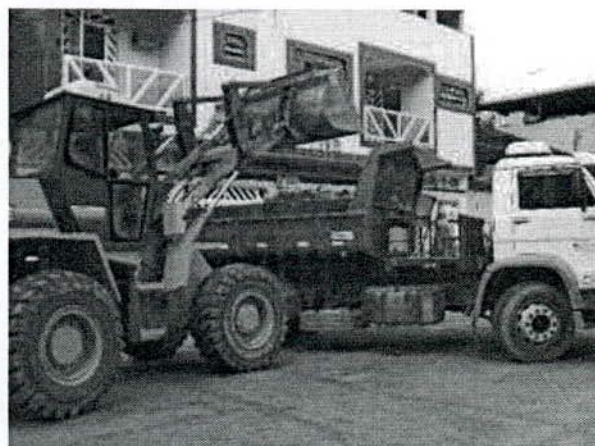
Foto 5.90 – Remoção mecanizada de inertes
