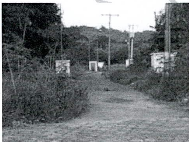
Foto 5.1 – Bateria de Poços – Captação
