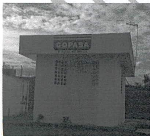
Foto 5.20 – EAAB RSE-04 – Casa de Bombas
