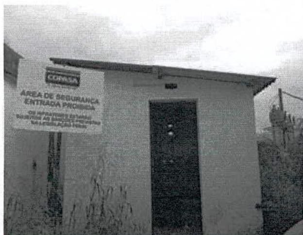
Foto 5.16 – EAAB RSE-02 – Casa de Bombas
