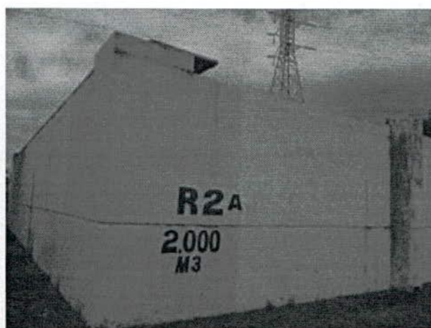
Foto 5.12 – Complexo de Reservação – R.2A
