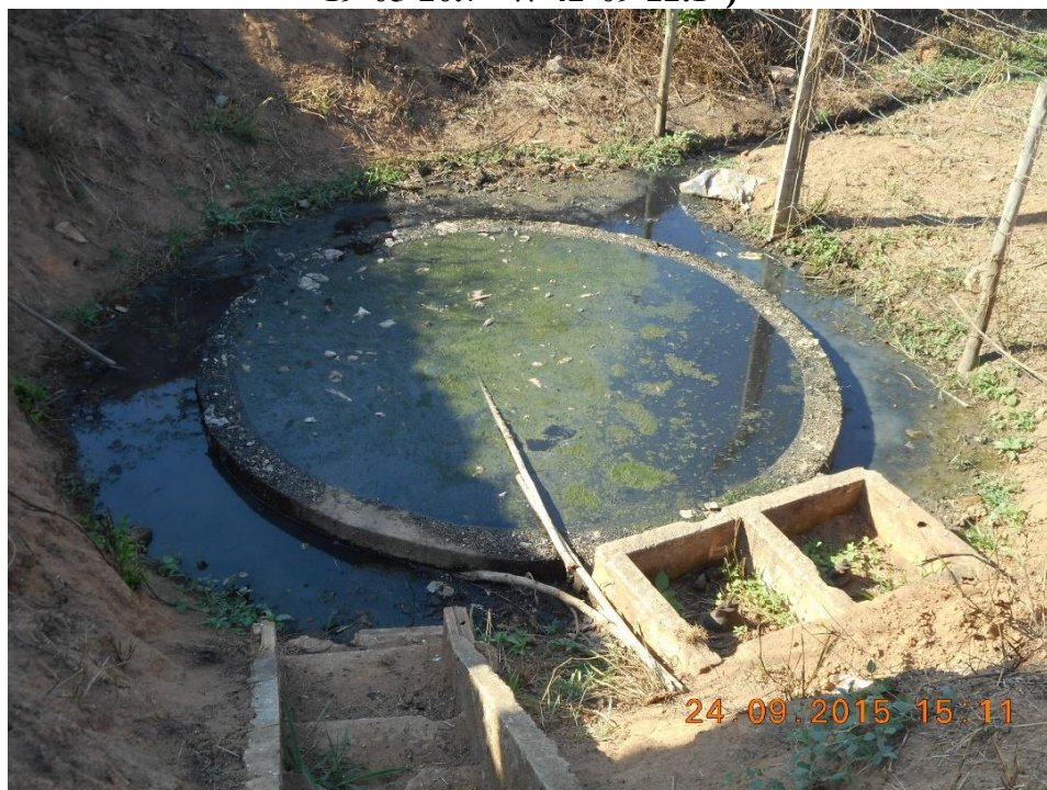
Figura 47: Estação de Tratamento de Esgoto do distrito de Pedra Corrida (Local: S 19°05'20.7" W 42°09'22.1")
