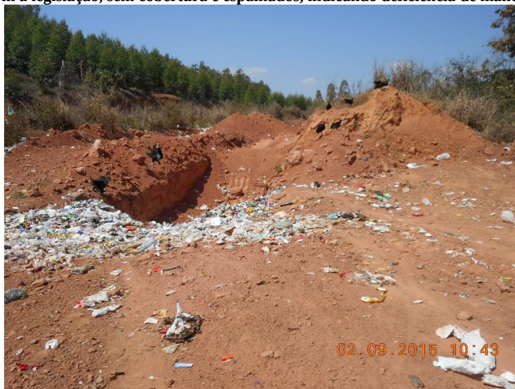
Figura 60: Disposição final dos rejeitos coletados na cidade de Periquito em desacordo com a legislação, sem cobertura e espalhados, indicando deficiência de manejo
