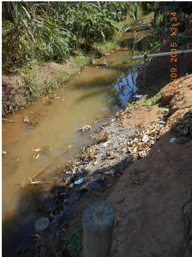
Figura 56: Lançamento de esgoto in natura no córrego (Coordenadas: S 19°06'13.7" W 42°16'33.9")
