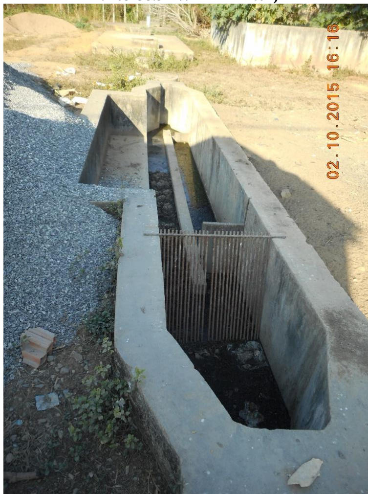
Figura 50: Estação de Tratamento de Esgoto da Comunidade de Serraria (Local: S 19°03'58.3" W 42°12'24.0")
