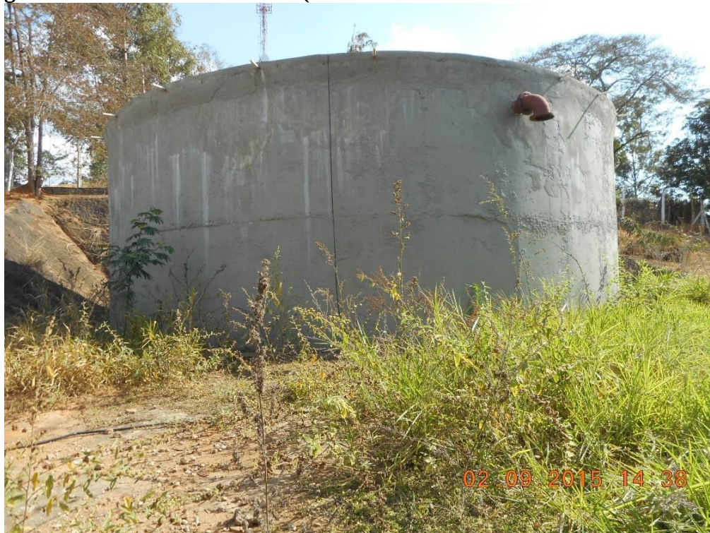
Figura 33: Reservatório da Sede (Coordenadas: S19°09'30.5'' W42°14'30.0'')
