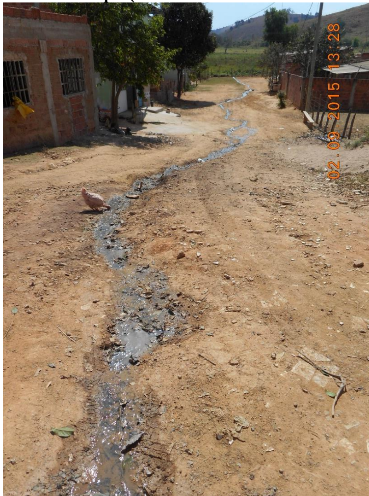
Figura 44: Ponto de lançamento de esgoto doméstico in natura direto das residências nas ruas do município (Local: S 19°09'07.4'' – W 42°14'42.3'')
