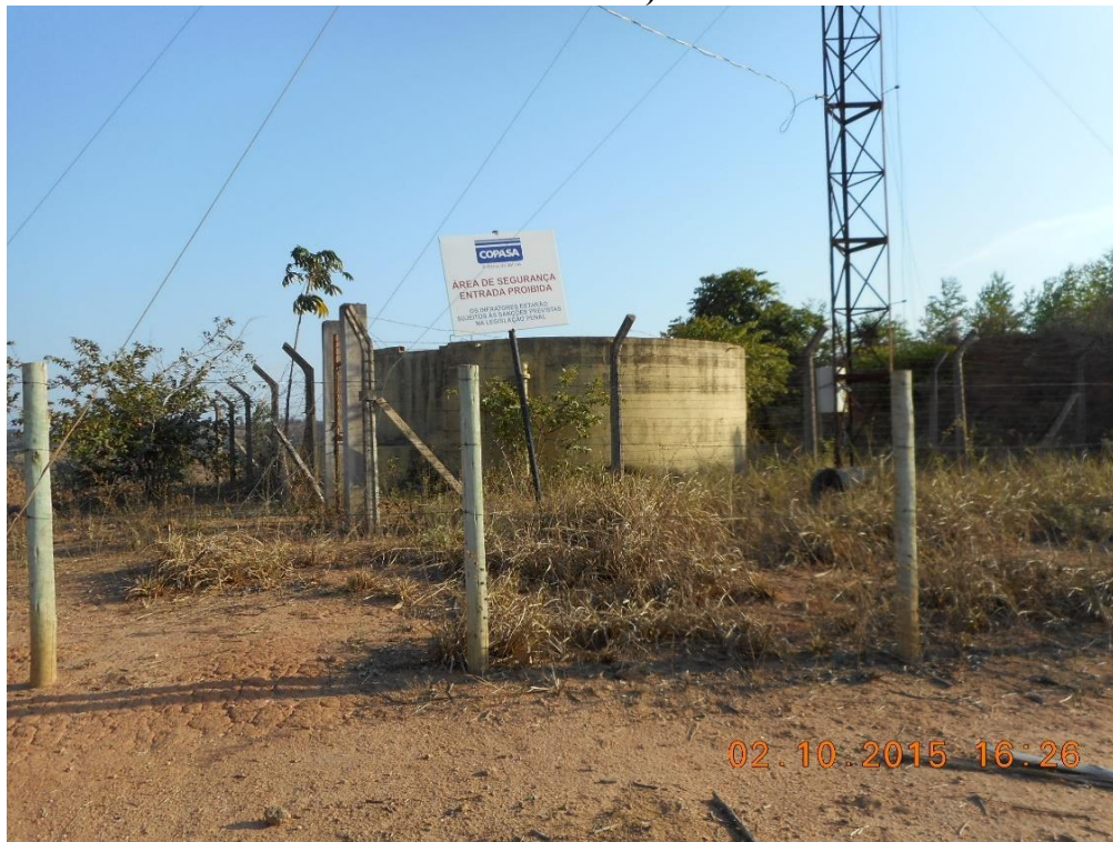
Figura 39: Reservatório Comunidade de Serraria (Local: S 19°03'52.7" – W 42°12'38.7")
