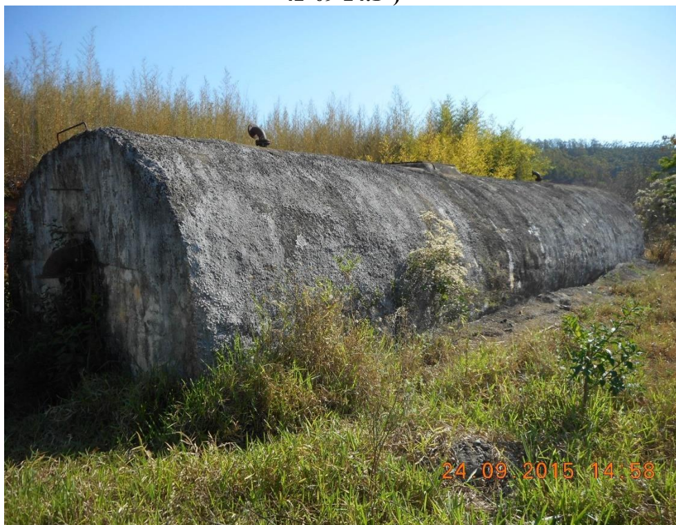
Figura 37: Reservatório de água de Pedra Corrida (Local: S 19°05'35.2" W 42°09'24.1")
