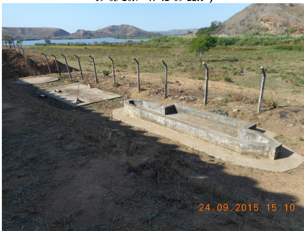
Figura 45: Estação de Tratamento de Esgoto do distrito de Pedra Corrida (Local: S 19°05'20.7" W 42°09'22.1")
