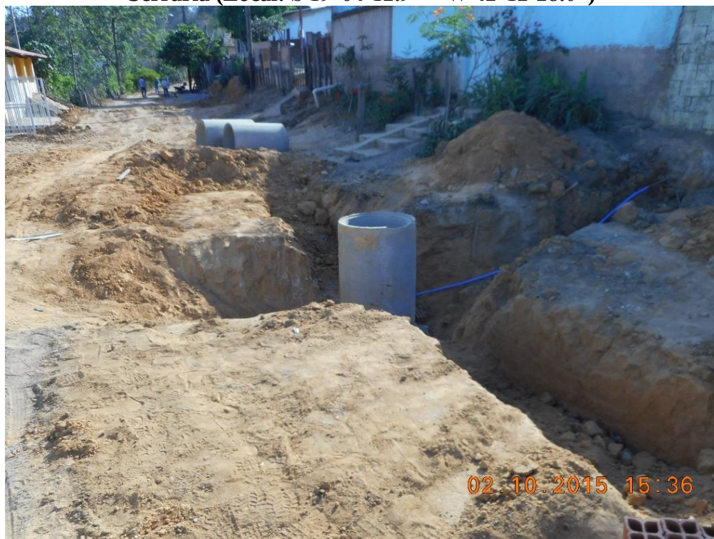
Figura 54: Obras de esgotamento sanitário e drenagem feitas no Comunidade de Serraria (Local: S 19°04'12.9" – W 42°12'28.0")
