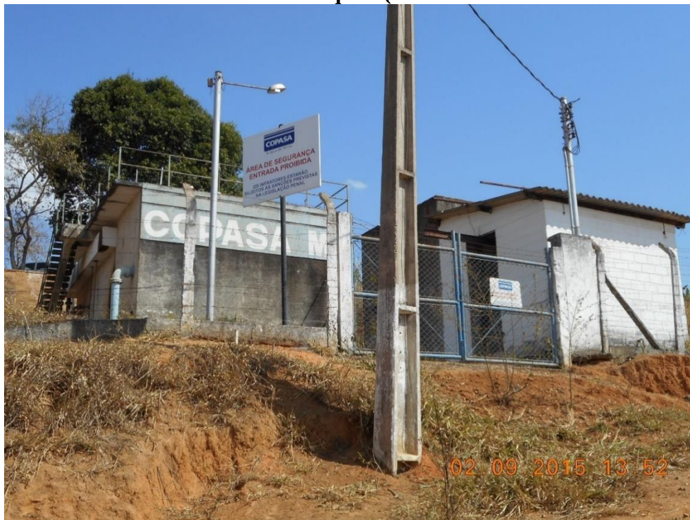
Figura 32: Visão da ETA na sede de Periquito (Local: S 19°09'10.6" – W 42°14'43,7")
