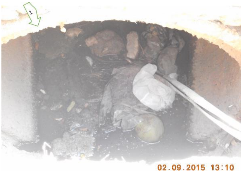
Figura 67: Rede mista-esgoto e águas pluvias (1)
