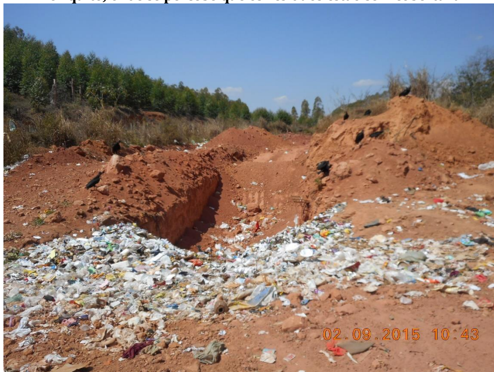
Figura 59: Vala construída para a disposição final dos rejeitos segregados na UTC de Periquito, onde se percebe que os resíduos estão sem cobertura
