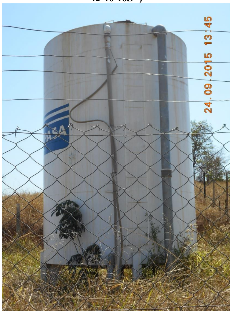
Figura 42: Reservatório distrito de São Sebastião do Baixio (Local: S 19°05'59.4" – W 42°16'16.9")
