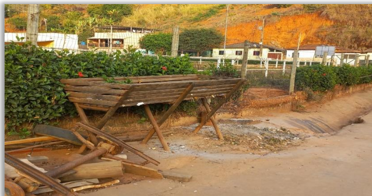
Figura 15: Lixeira na Zona Urbana na Sede do Município de Córrego Novo-MG
