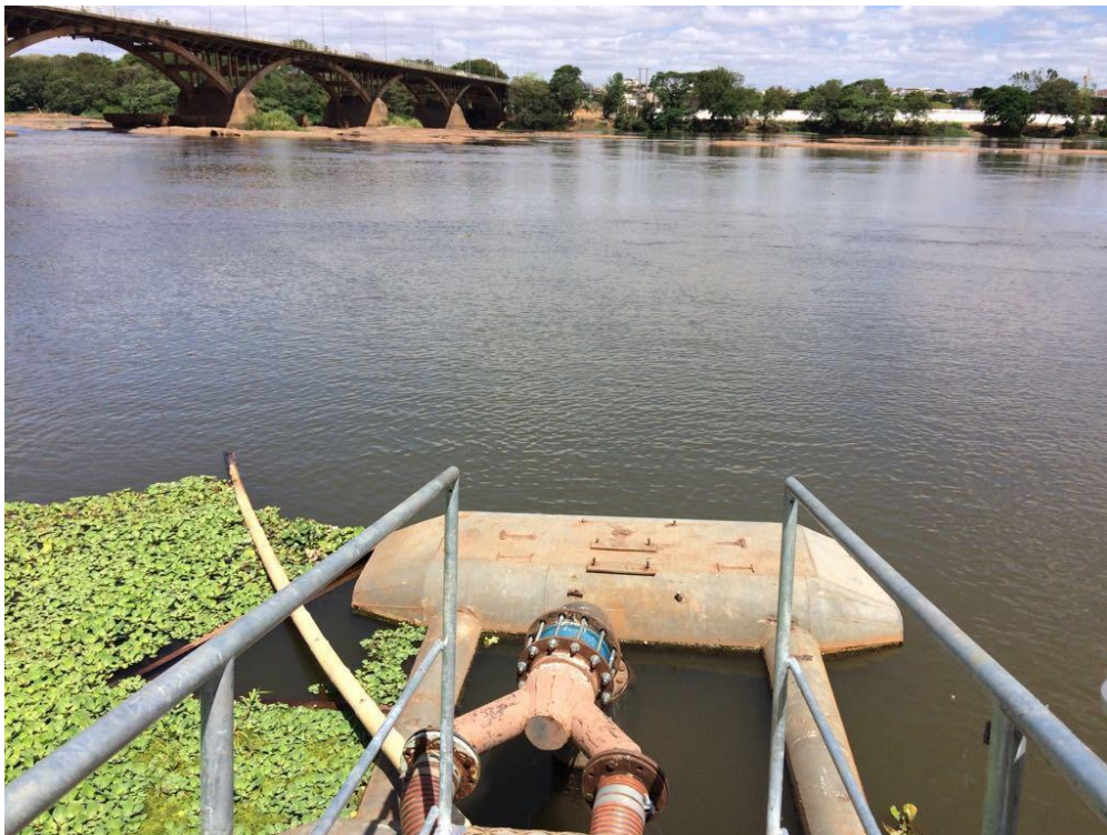
Figura 2 – Ponto RDO 08 na ETA Vila Isa em Valadares_foto1.
