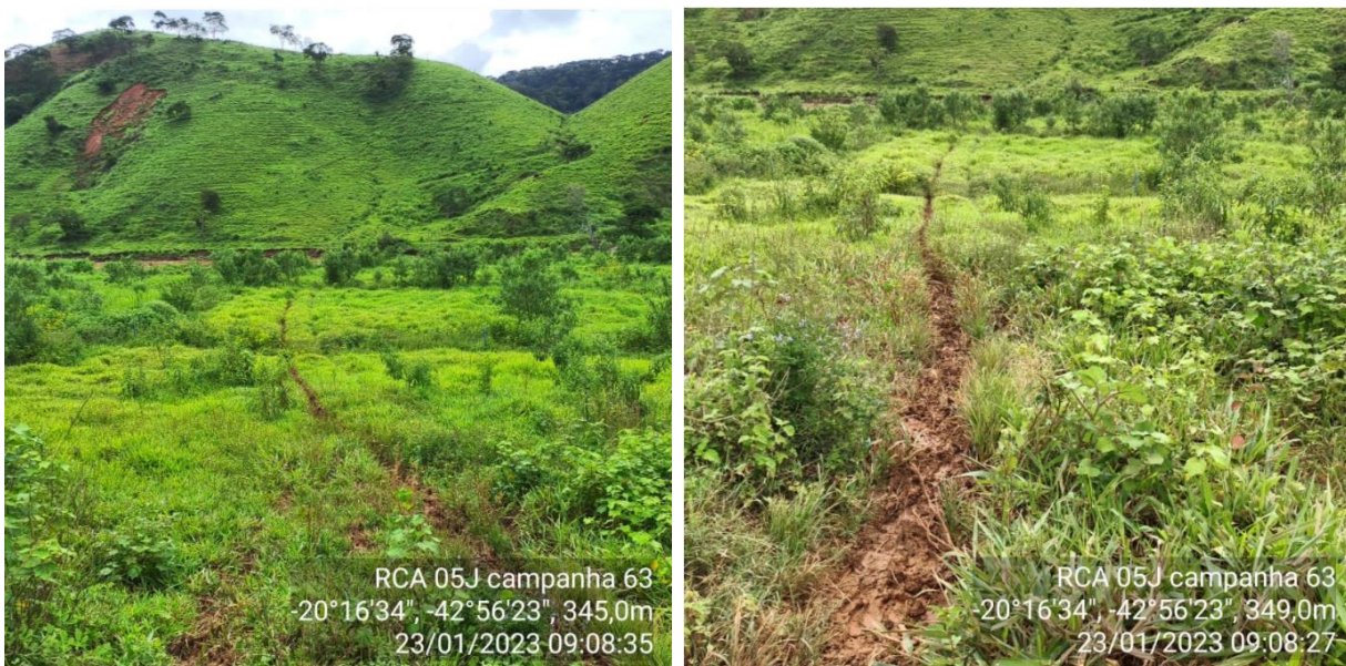
Figura 2 – Condição do acesso ao ponto RCA 05J (23/01/2023).
