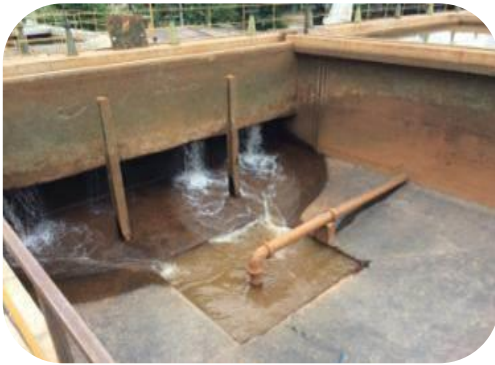
Figura 13: Cenário de antes e depois da instalação de cortina de madeira na entrada do Decantador 02.
