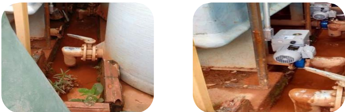
Figura 27: Imagem dos drenos dos decantadores da ETA Santa Rita, antes e depois da instalação das válvulas.
