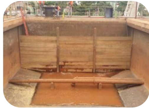
Figura 13: Cenário de antes e depois da instalação de cortina de madeira na entrada do Decantador 02.
