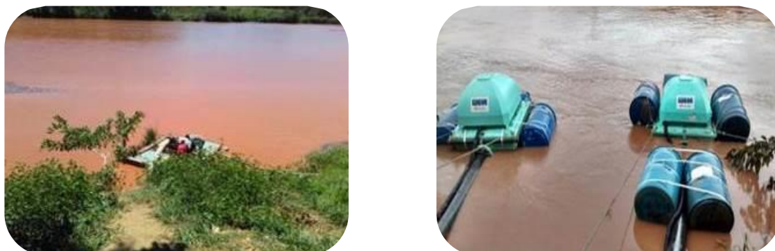
Figura 6: Substituição da balsa de captação (à esquerda) por dois flutuadores (à direita) no sistema de captação da ETA modular de Cachoeira Escura.
