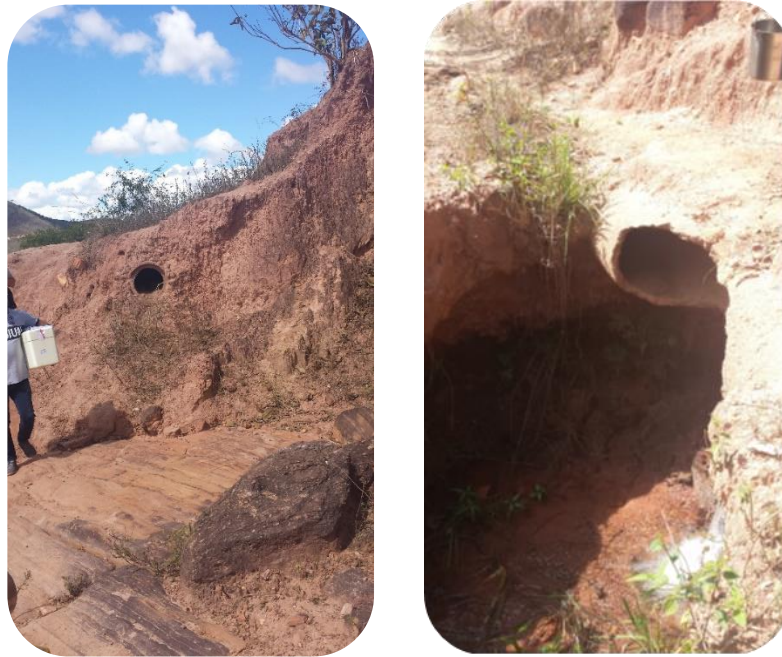
Figura 933: Adutora do Córrego Santaninha da COPASA.
