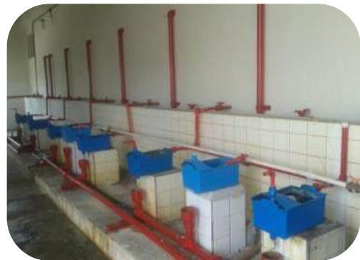
Figura 53: Melhorias nas caixas dosadoras.
