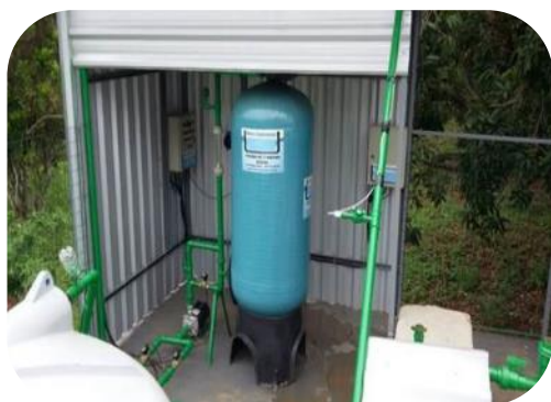
Figura 31: Imagem do filtro (à esquerda) e do reservatório (à direita) do sistema de tratamento da água do poço do distrito de São Tomé do Rio Doce.
