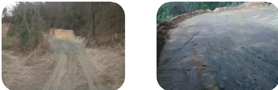
Figura 37: Lançamento de solo brita (à esquerda) e compactação da via de acesso (à direita)
