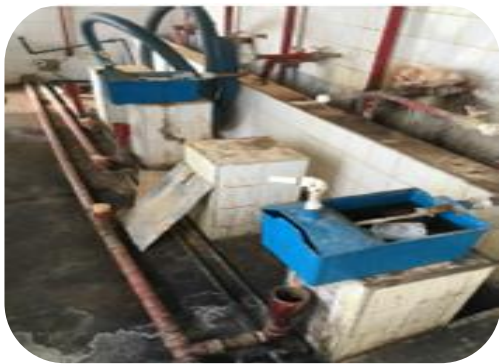
Figura 59: Reforma das caixas dosadoras dos produtos químicos.
