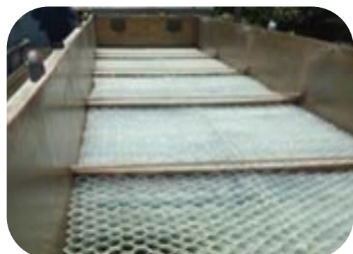
Figura 23: Pintura (à esquerda) e substituição de colmeias (à direita) na ETA Vila Isa.
