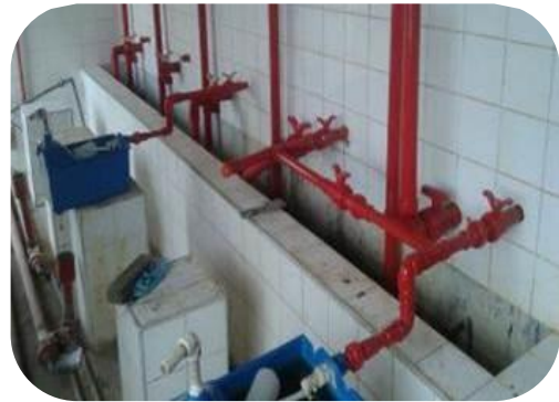
Figura 59: Reforma das caixas dosadoras dos produtos químicos.
