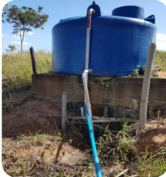
Figura 106: Reservatório instalado em substituição à cisterna com nova tubulação.
