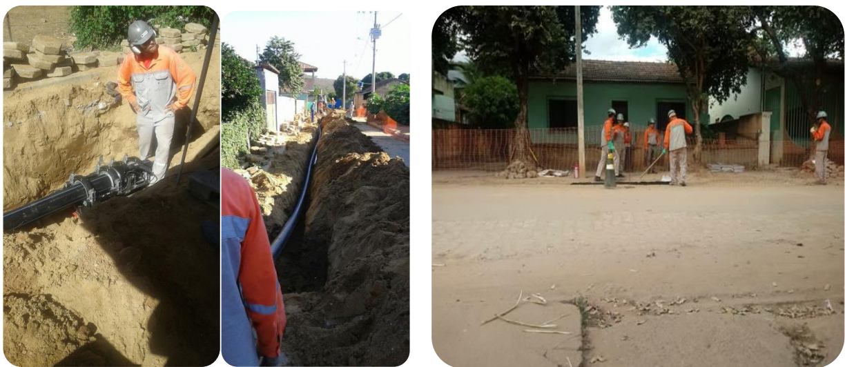
Figura 36. Imagens durante a construção da adutora de água tratada (à esquerda) e após a conclusão (à direita), que interligará a nova ETA de Galileia ao reservatório do SAAE.
