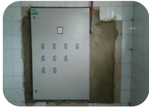
Figura 45: Substituição do painel de acionamento dos agitadores, na ETA I de Colatina.
