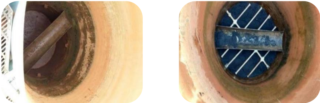
Figura 26: Imagem de um dos filtros da ETA de Santa Rita, antes e depois da substituição do leito filtrante.
