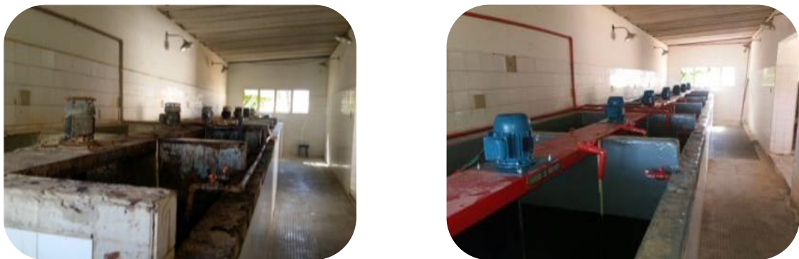
Figura 43: Situação de antes e depois da troca dos agitadores dos tanques da ETA I de Colatina.
