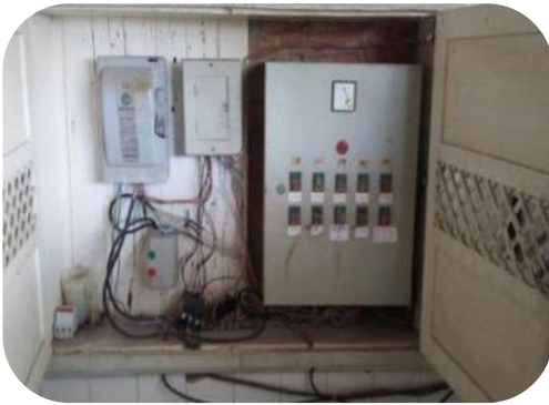
Figura 45: Substituição do painel de acionamento dos agitadores, na ETA I de Colatina.
