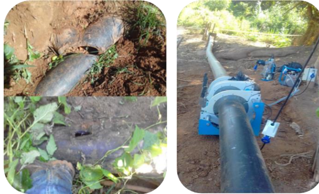
Figura 63: Reparo e interligação da adutora dos poços; adutora antes do reparo (à esquerda) e após o reparo (à direita)
