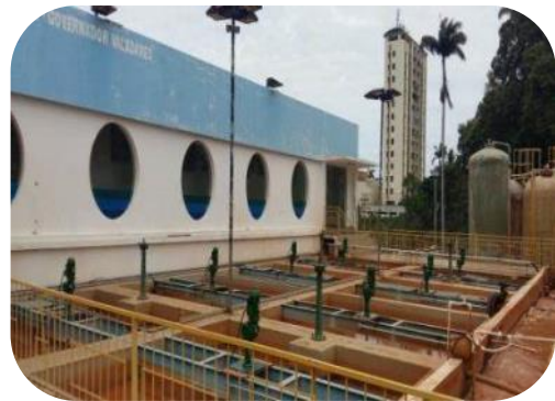
Figura 11: Imagens dos agitadores instalados na ETA Central.
