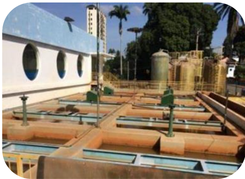
Figura 11: Imagens dos agitadores instalados na ETA Central.
