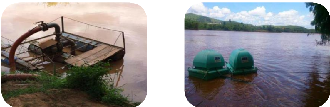
Figura 28: Imagem do sistema de captação da ETA Santa Rita, antes e depois da substituição dos flutuantes.
