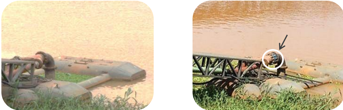
Figura 18: Cenário de antes e depois, evidenciando a instalação de válvula de retenção.
