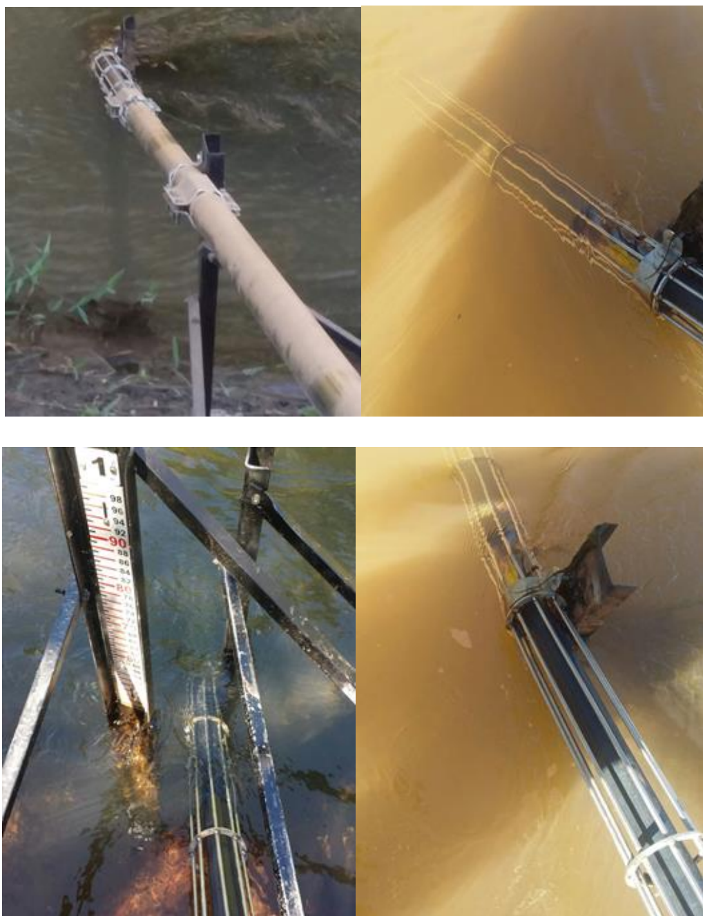
Figura 23 – Modelo das novas grades de proteção instaladas
