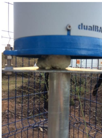
Figura 17 - Instalação de espuma expansível nos tubos de suporte
