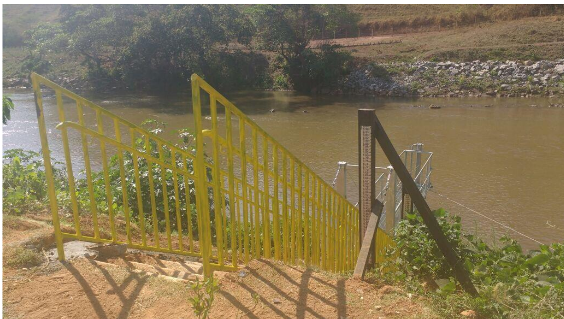
Figura 9 - Escadaria de acesso ao píer da estação RCA-02 em Barra Longa
