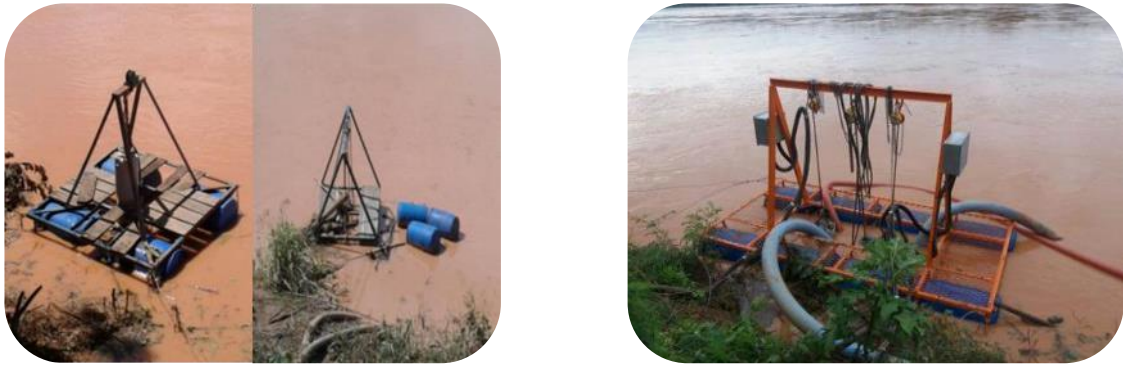
Figura 41: Substituição de balsa do sistema de captação da ETA I de Colatina.
