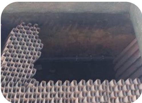
Figura 15: Mosaico de imagens ilustrando a substituição das colmeias (antes e depois).
