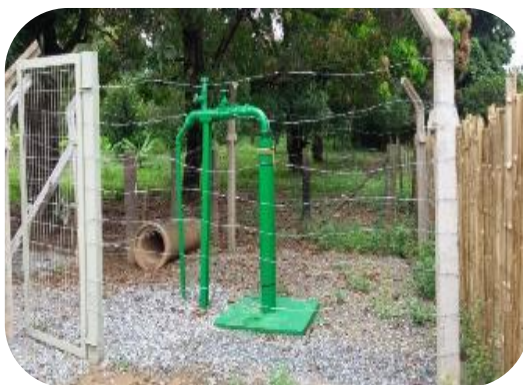
Figura 85: Poço perfurado na região de São Tomé do Rio Doce.
