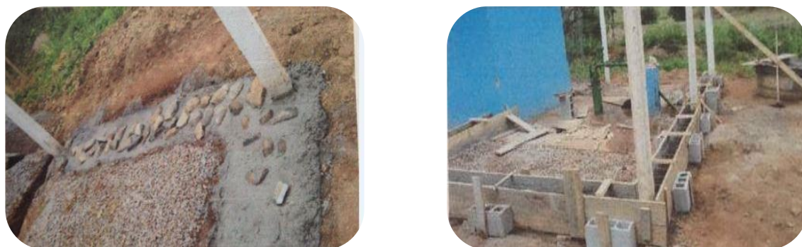
Figura 1: Mosaico de imagens da construção do muro no entorno do reservatório.
