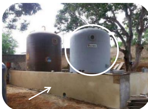
Figura 46: Instalação de Tanque de Tanfloc de 15.000l (à direita) e Caixa de Contenção para Tanfloc e Sulfato de Alumínio (ambos evidenciados), em cenário de antes (à esquerda) e depois (à direita).
