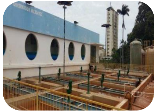
Figura 11: Imagens dos agitadores instalados na ETA Central.
