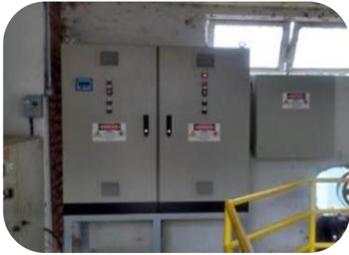
Figura 21: Mosaico de imagens evidenciando o painel de alimentação e sistema de bombas anfíbias.
