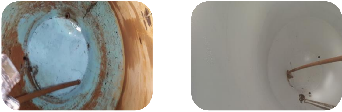
Figura 34: Jateamento do interior da torre durante a reforma (à esquerda) e resultado da pintura no mesmo interior (à direita)
