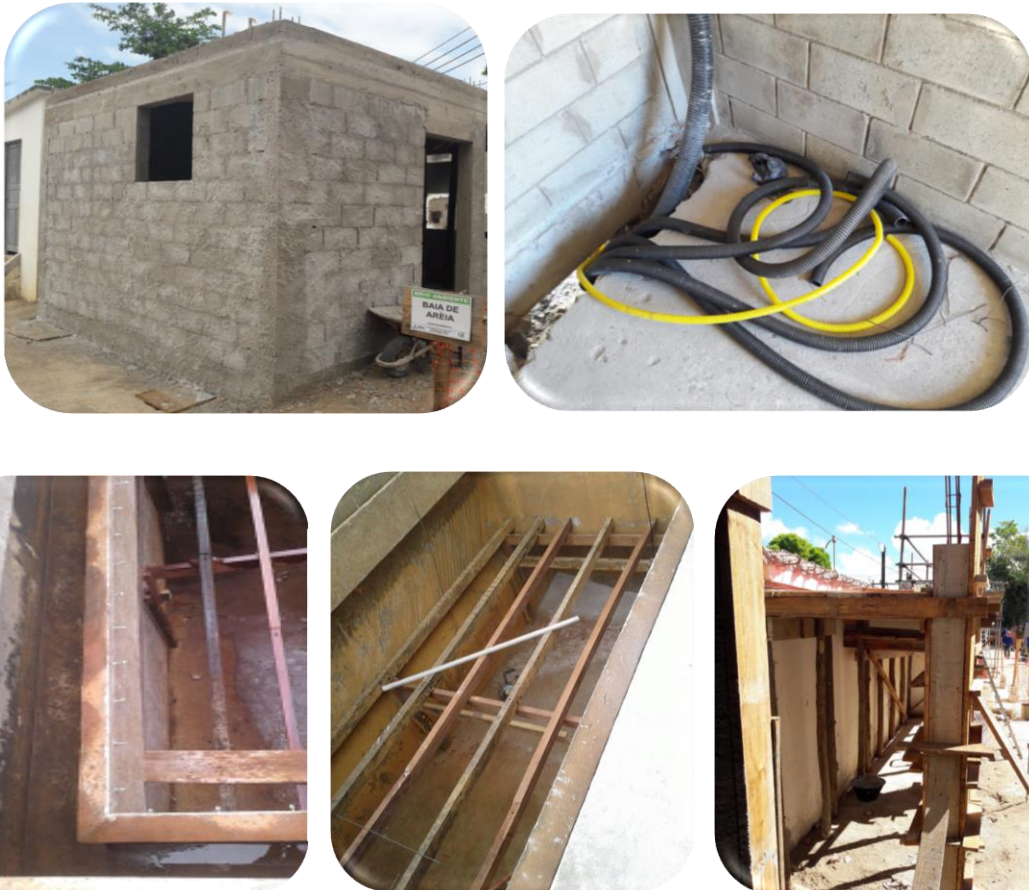
Figura 67: Imagens das reformas realizadas na ETA de Regência
