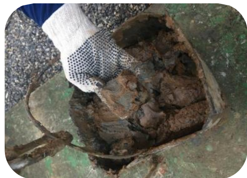
Figura 33: Interior da torre antes da reforma (à esquerda) e material lodoso retirado no interior do castelo d'água
