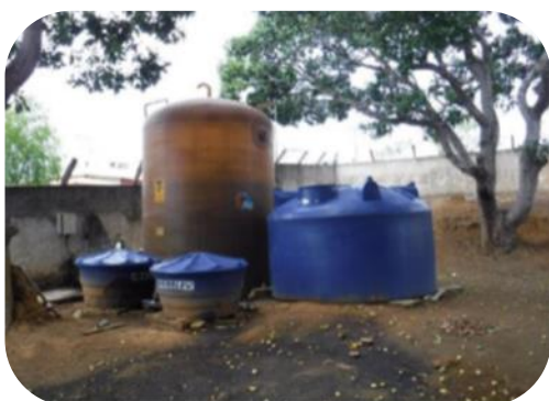
Figura 46: Instalação de Tanque de Tanfloc de 15.000l (à direita) e Caixa de Contenção para Tanfloc e Sulfato de Alumínio (ambos evidenciados), em cenário de antes (à esquerda) e depois (à direita).
