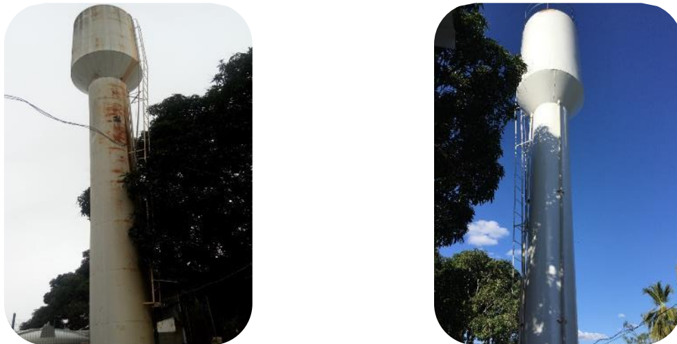
Figura 35: Torre antes da pintura (à esquerda) e depois da pintura (à direita)
