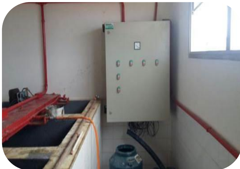
Figura 60: Montagem do painel de comando dos agitadores dos tanques de produto químicos.
