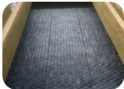
Figura 56: Melhoria do sistema de decantação, pela instalação de perfis de decantação.
