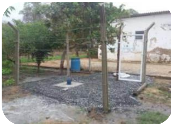
Figura 84: Poço perfurado na região de São Vitor em Governador Valadares.
