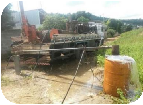
Figura 95: Imagens de recuperação do Poço C3 em Resplendor.
