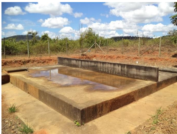
FIGURA 27 – RESERVATÓRIO VISTA ALEGRE (FONTE: ACERVO DO AUTOR, 2014)
