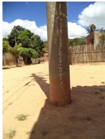
FIGURA 48 – RUA DONA GERALDA XAVIER ALVARENGA (FONTE: ACERVO DO AUTOR, 2014)
