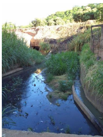
FIGURA 44—RUA JOÃO LOURENÇO TORRES (FONTE: ACERVO DO AUTOR, 2014)
