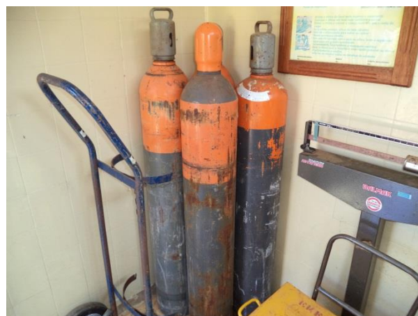
FIGURA 10 – CLORO GASOSO (FONTE: ACERVO DO AUTOR 2014)
