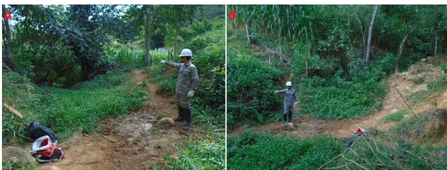
Foto 6.10: A) Vista à jusante da SCA-DS-01, região com solo saturado próximo à confluência com o Rio do Peixe. B) Vista a montante da drenagem, indicação da direção do suposto fluxo superficial.
