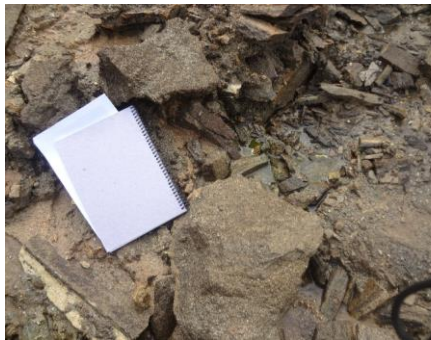
Foto 6.7: Detalhe da surgência PNA-01 na área da Pedreira Corsini.
