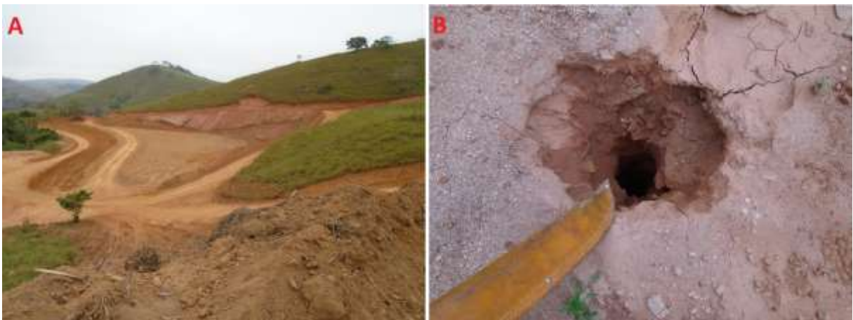
Foto 7.12: Pontos de controle do Platô II. A) Ponto SCA-PC-17, visada para a área. B) Ponto SCA-PC-18, furo de sonda obstruído a partir de 1,3 m.
