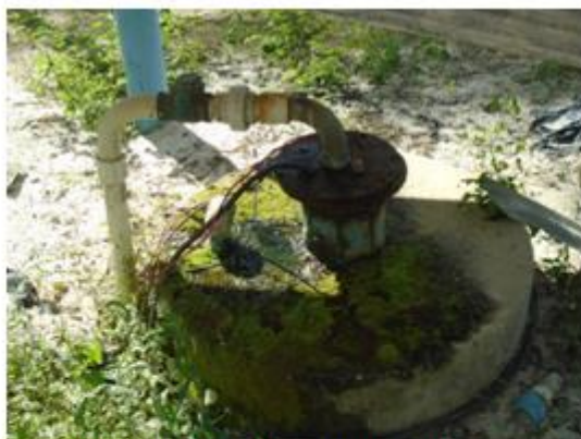
Poço Tubular Profundo lacrado (Impossibilitando a leitura do N.A.).
