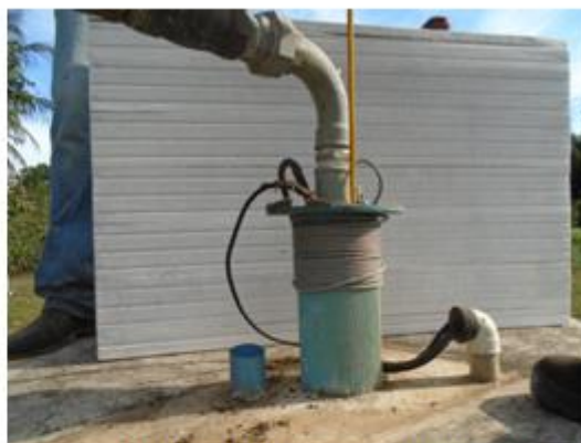
Poço Tubular Profundo (medindo o N.A.).
