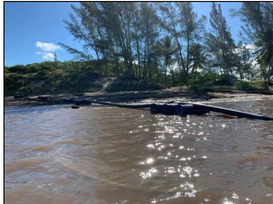
Figura 25. Tubulação da draga de sucção e recalque posicionada, sem acúmulo de sedimento na saída.
