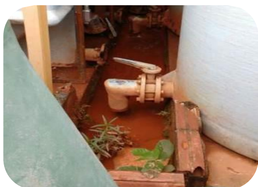
Figura 27: Imagem dos drenos dos decantadores da ETA Santa Rita, antes e depois da instalação das válvulas.
