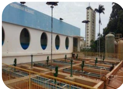
Figura 11: Imagens dos agitadores instalados na ETA Central.
