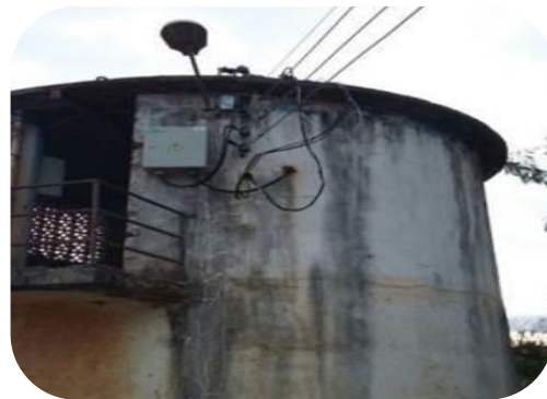
Figura 57: Instalação de disjuntor de entrada para eliminação do padrão elétrico antigo.
