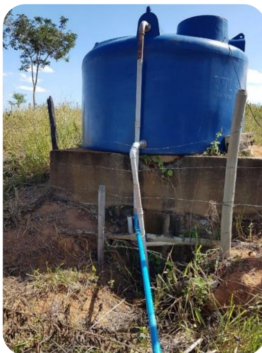
Figura 106: Reservatório instalado em substituição à cisterna com nova tubulação.
