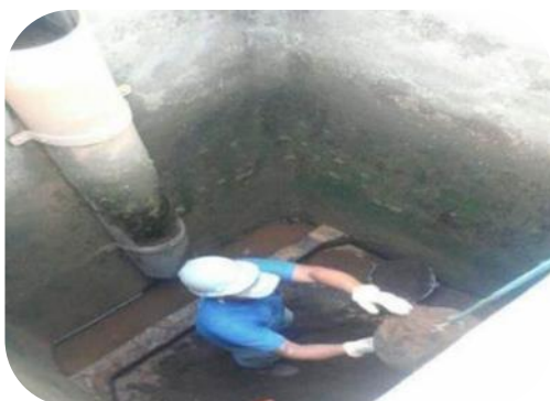
Figura 61: Processo de substituição dos leitos filtrantes de quatro filtros já existentes.
