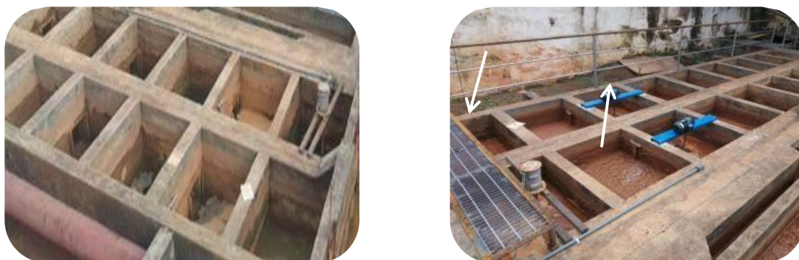
Figura 47: Implantação de acesso seguro às áreas dos floculadores e decantadores, evidenciado.
