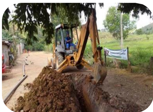
Figura 79: Evidências da interligação hidráulica do poço tubular PN01 à adutora.
