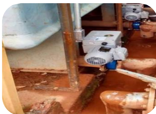
Figura 27: Imagem dos drenos dos decantadores da ETA Santa Rita, antes e depois da instalação das válvulas.
