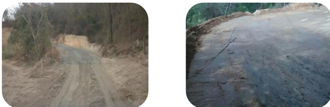
Figura 37: Lançamento de solo brita (à esquerda) e compactação da via de acesso (à direita)
