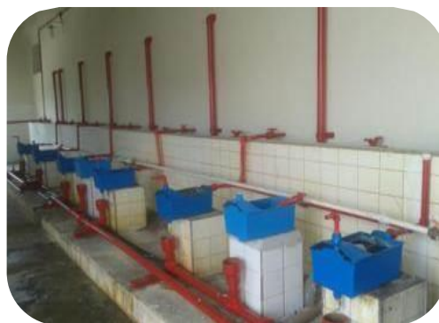
Figura 53: Melhorias nas caixas dosadoras.
