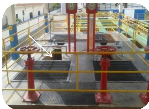
Figura 55: Corrimão e grade de proteção instalados, ambos evidenciados.
