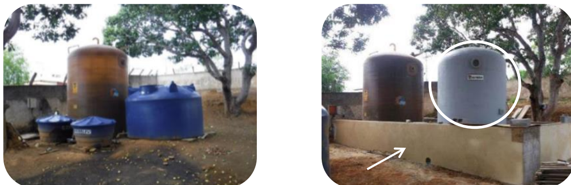
Figura 46: Instalação de Tanque de Tanfloc de 15.000l (à direita) e Caixa de Contenção para Tanfloc e Sulfato de Alumínio (ambos evidenciados), em cenário de antes (à esquerda) e depois (à direita).
