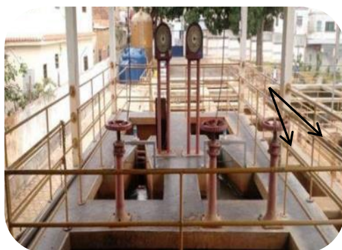
Figura 55: Corrimão e grade de proteção instalados, ambos evidenciados.
