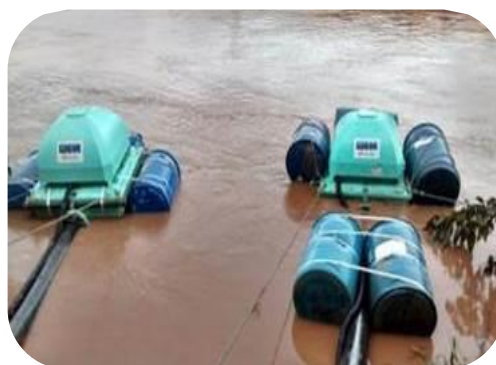
Figura 6: Substituição da balsa de captação (à esquerda) por dois flutuadores (à direita) no sistema de captação da ETA modular de Cachoeira Escura.
