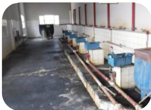
Figura 53: Melhorias nas caixas dosadoras.
