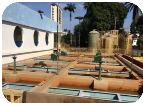
Figura 11: Imagens dos agitadores instalados na ETA Central.
