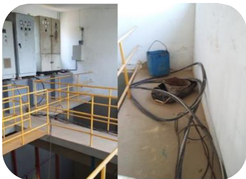
Figura 42: Novo painel (à esquerda) e eletrocalha (à direita) instalados na ETA 1 de Colatina.
