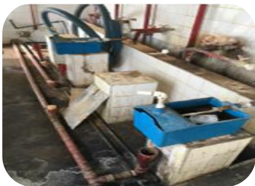
Figura 59: Reforma das caixas dosadoras dos produtos químicos.
