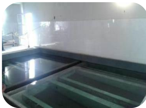
Figura 48: Substituição do leito filtrante dos filtros “Russos” na ETA II de Colatina.
