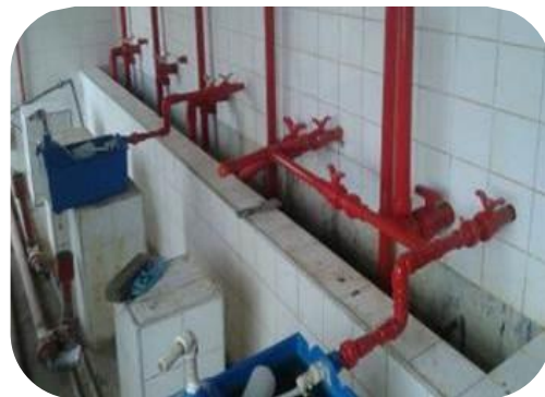
Figura 59: Reforma das caixas dosadoras dos produtos químicos.
