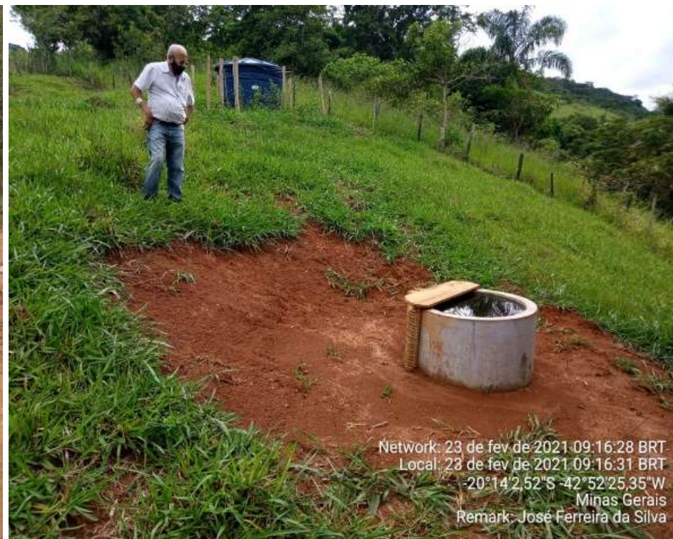
Perfuração de poços tubular, em propriedades que não apresenta fonte de água para dessedentação animal e instalação da rede hidráulica, levando água a um reservatório que abastece o bebedouro – propriedades de Marcio Martins e José Ferreira da Silva em MG - 23/02/2021
