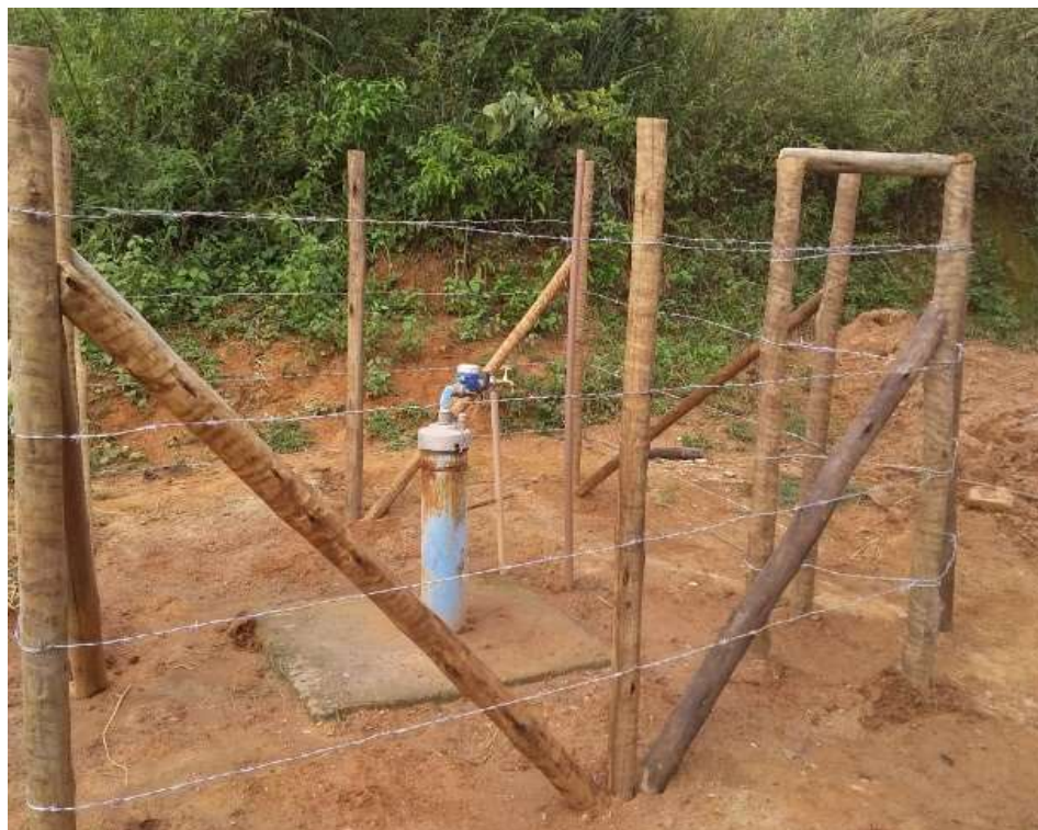
Perfuração de poços tubular, em propriedades que não apresenta fonte de água para dessedentação animal e instalação da rede hidráulica, levando água a um reservatório que abastece o bebedouro – propriedades de Marcio Martins e José Ferreira da Silva em MG - 23/02/2021
