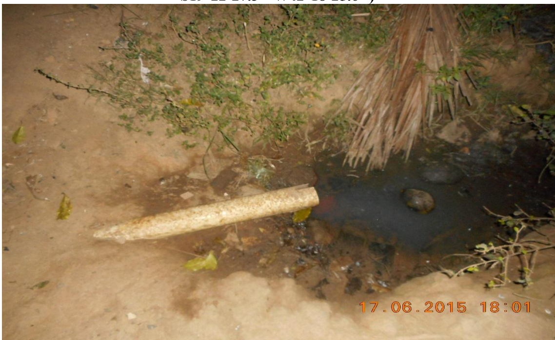
Figura 50: Lançamento de esgoto doméstico in natura no Córrego Rio Branco (Local: S19°22'27.3" W42°18'25.6")
