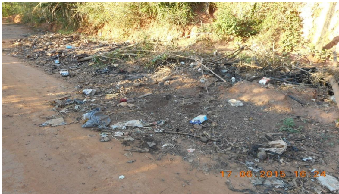
Figura 60: Rua sem drenagem contribuindo com carga de sedimentos obstruindo drenagem existente (ineficiente) no município do Bugre.
