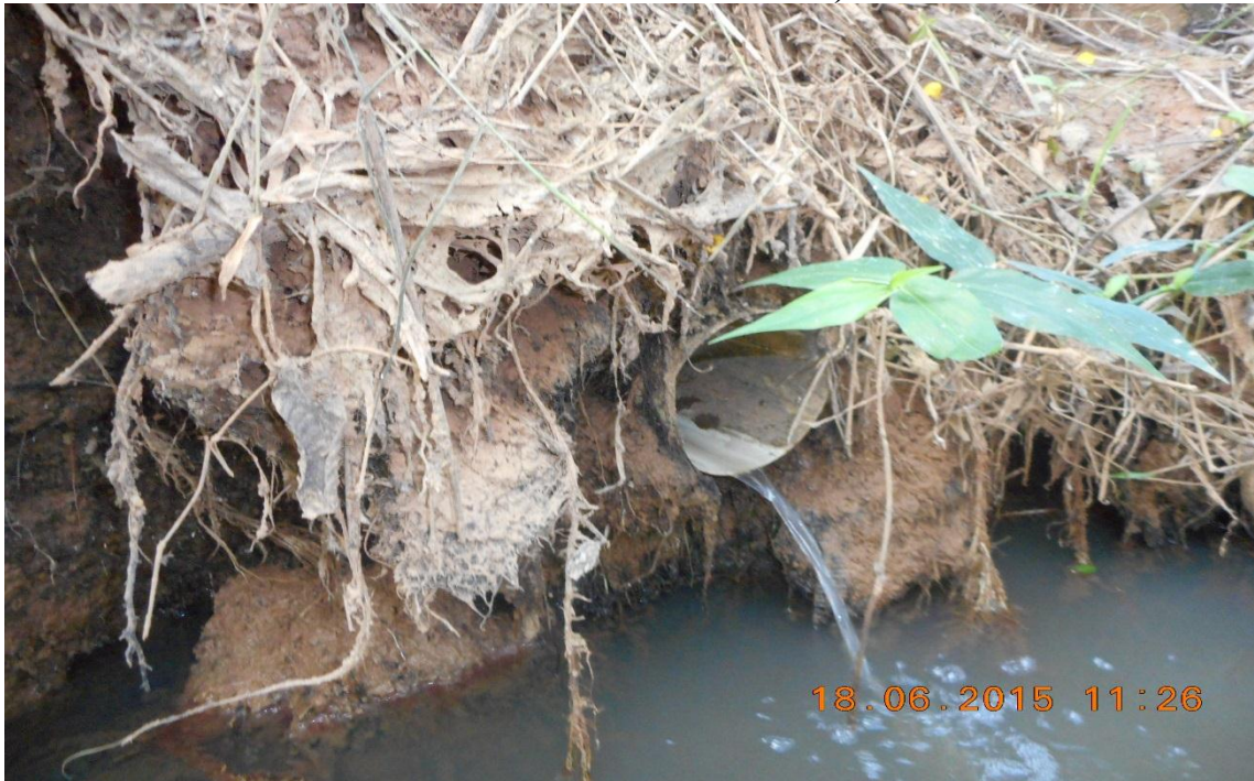
Figura 49: Lançamento de esgoto doméstico in natura no Córrego Boachá (Local: S19°22'12.4" W42°21'57.8")
