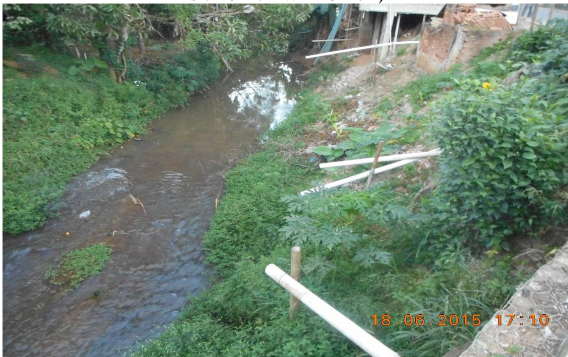
Figura 43: Ponto de lançamento de esgoto doméstico in natura na sede de Bugre (Local: S19°25'24.2" W42°15'24.4")
