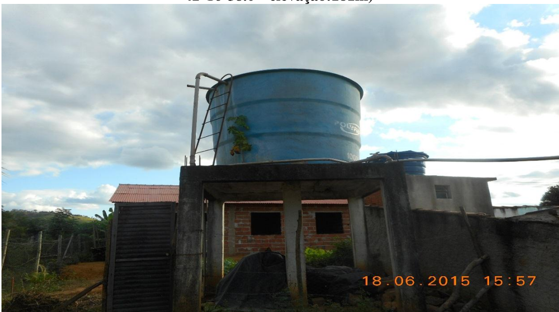
Figura 40: Reservatório do Córrego Livramento (10 m 3 ) (S 19°19'27.9" – W 42°16'58.0" elevação:181m)
